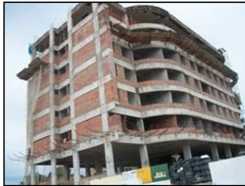
FIGURA 12 – Prédio em Estrutura de Concreto Armado com vedação em alvenaria de bloco cerâmico.
