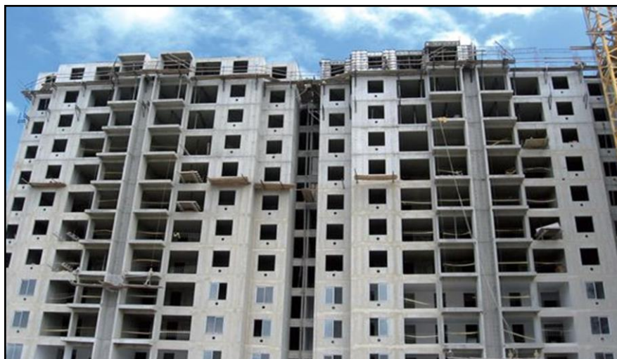
Figura 01 – Edificação com parede de concreto
