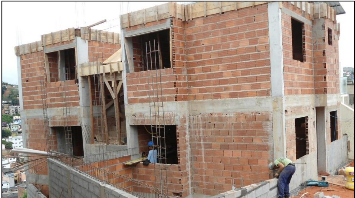
Figura 13 – alvenaria de vedação com blocos cerâmicos
