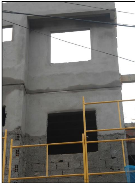
Figura 14 – Chapisco, emboço e reboco
