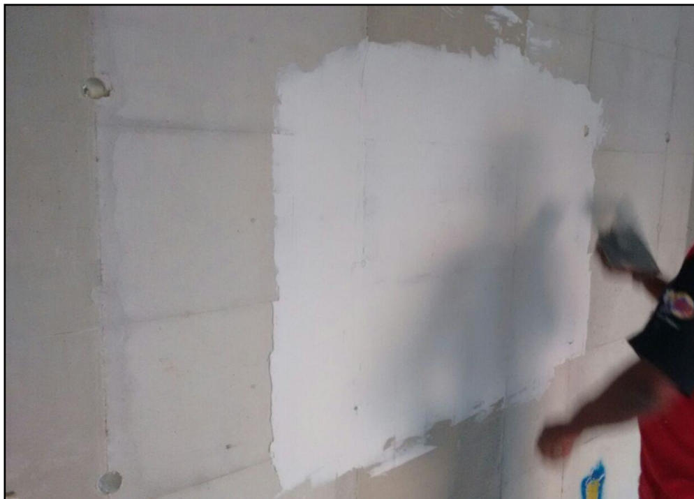
Figura 10 – Revestimento com massa corrida direto no concreto
