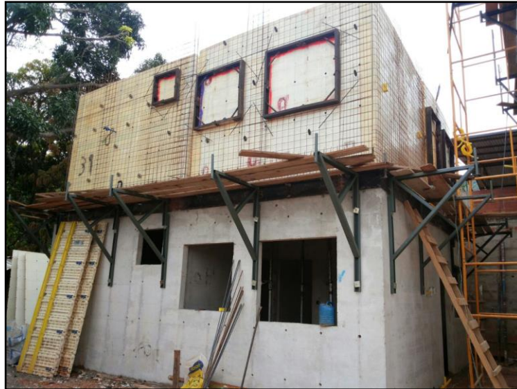
Figura 11 – Edificação utilizando fôrmas Tecwall
