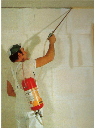
Figura 33 – encunhamento com espuma de poliuretano
