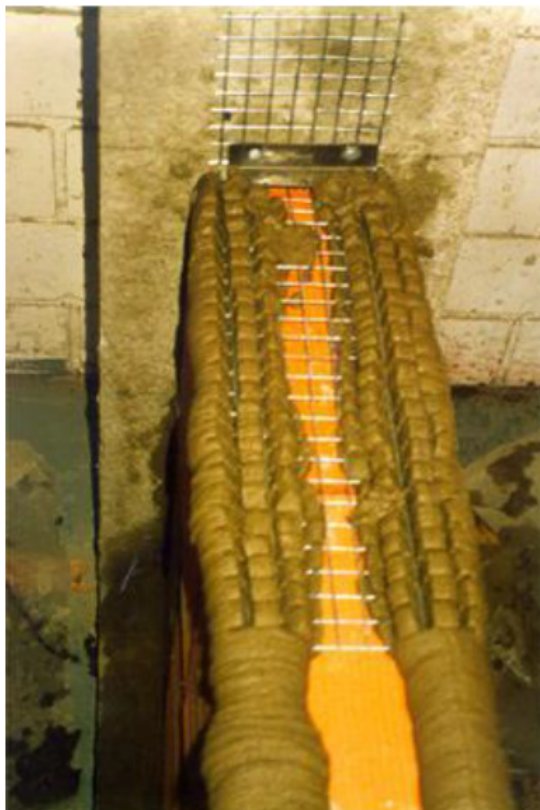
Figura 25 – Aplicação de Armadura para execução de reboco armado
