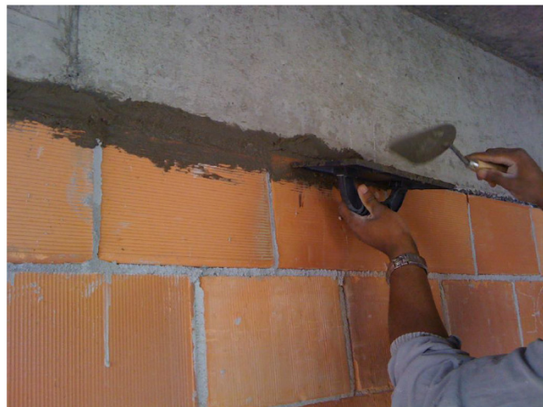
Figura 34 – Encunhamento com argamassa pobre
