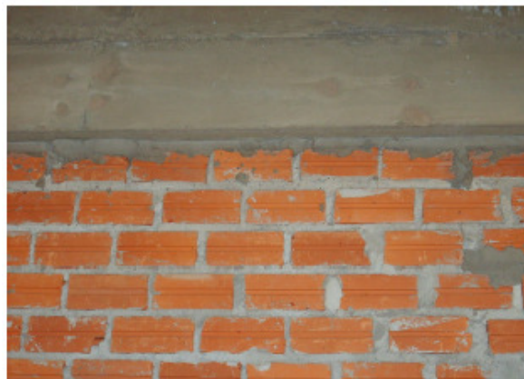
Figura 32 – Encunhamento com argamassa expansiva
