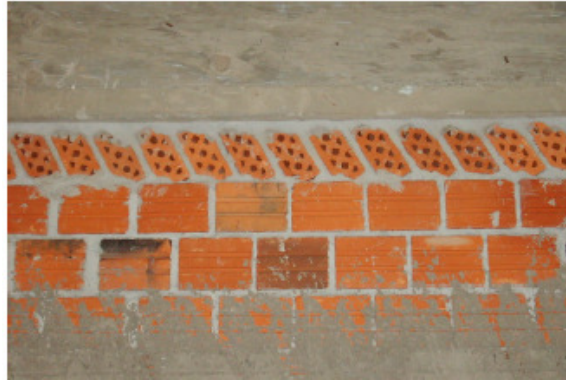
Figura 30 – Encunhamento com tijolos cerâmicos
