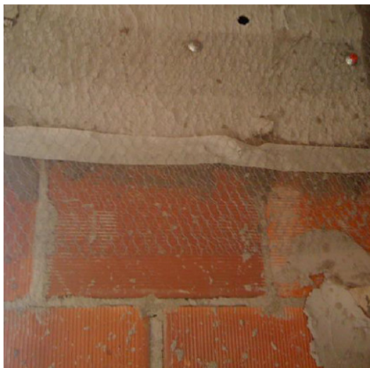
Figura 28 – Execução de ponte de transmissão em vigamento
