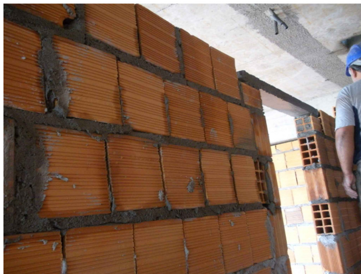
Figura 40 – Colocação contravergas (pré-moldada) em portas
