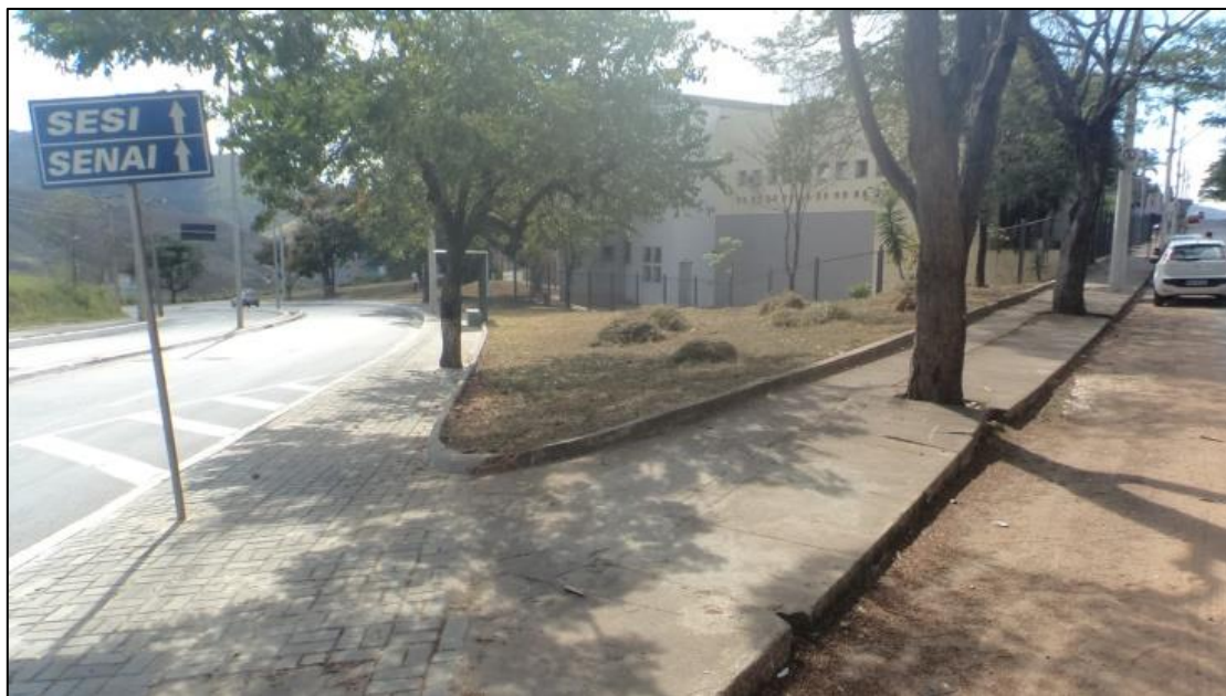
Figura 18 – Vista diagonal das duas avenidas, evidenciando o estado das calçadas
