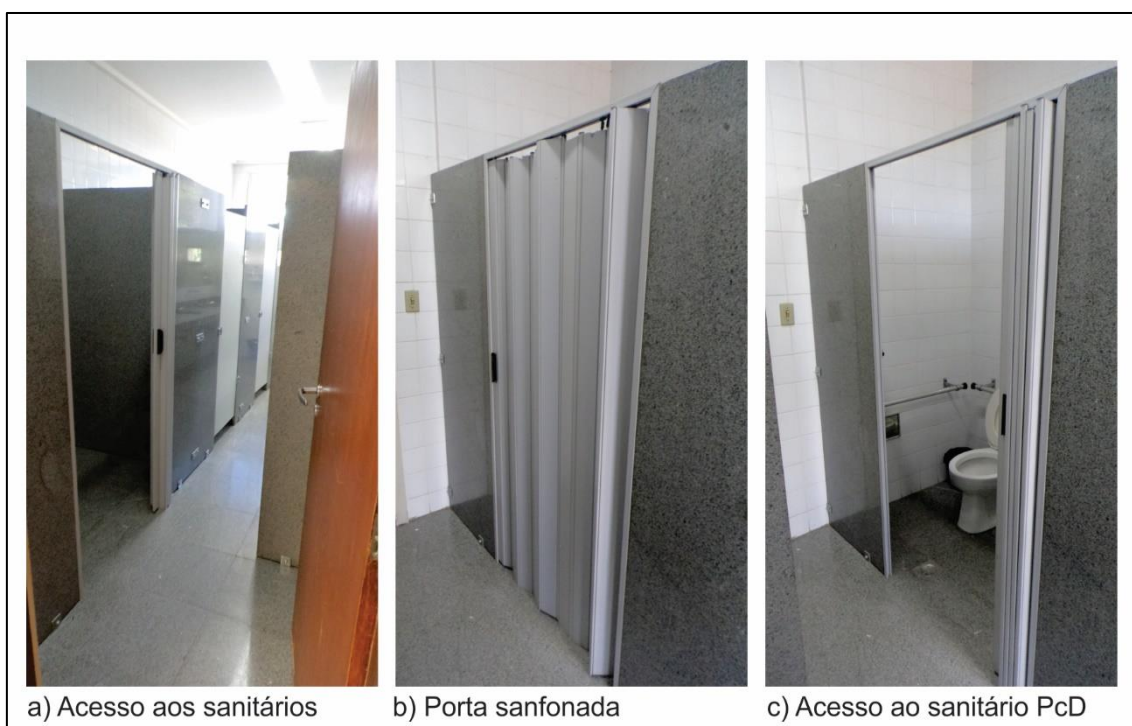
Figura 30 - Acesso aos banheiros
