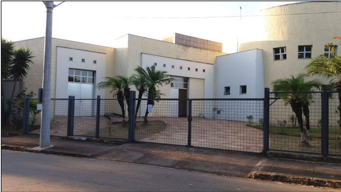
Figura 32 – Rampa e acesso para o segundo pavimento
