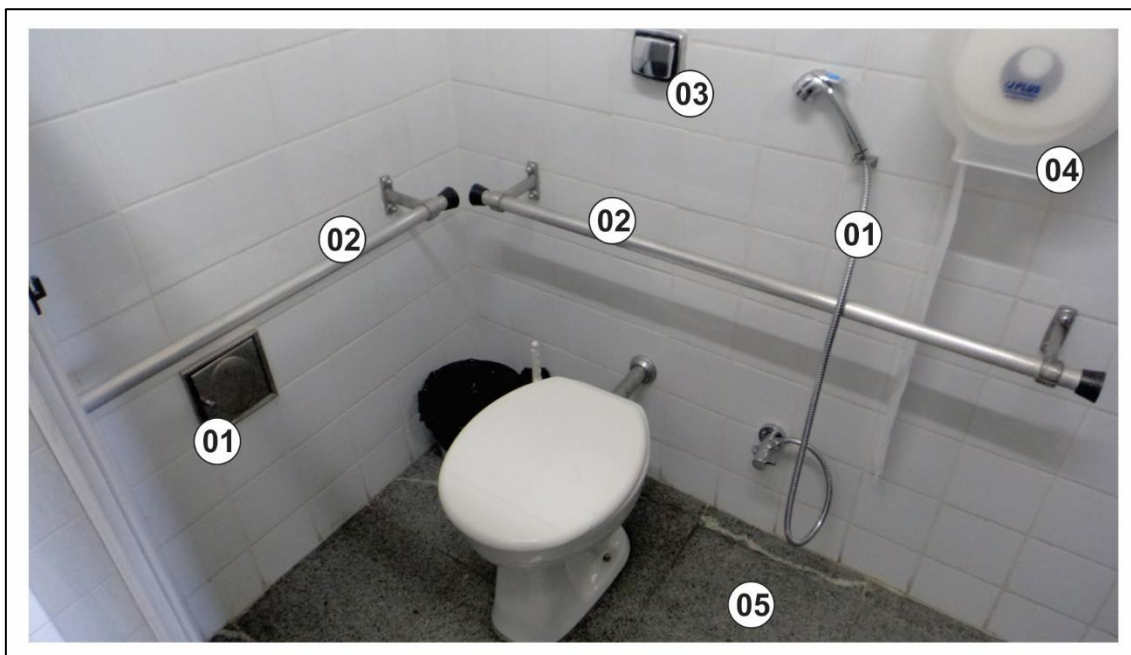
Figura 31 - Elementos de segurança dos banheiros
