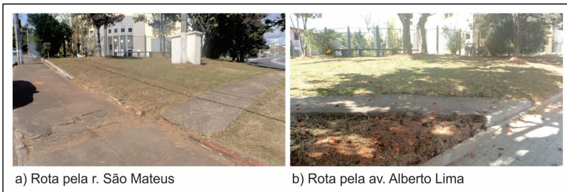
Figura 23 – Degraus da calçada ligação entre vias
