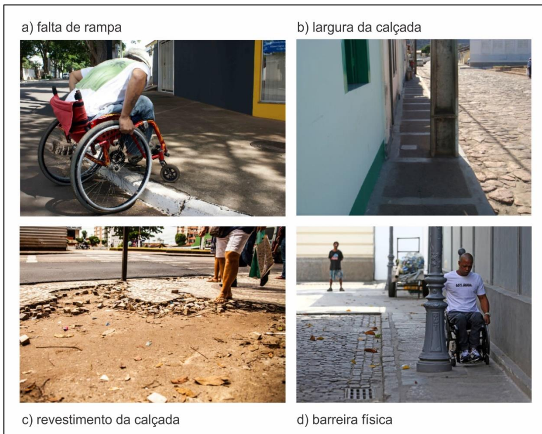
Figura 1 - Calçamentos e calçadas com restrição de mobilidade a cadeirantes
