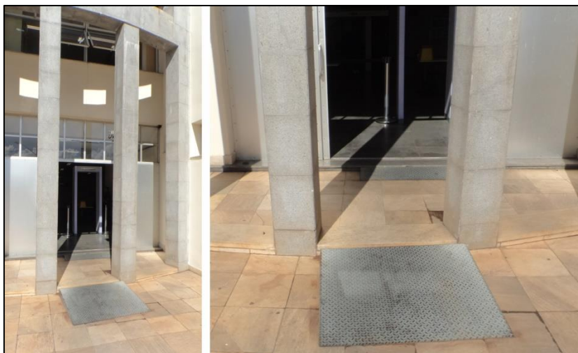
Figura 27 - Rampas do hall de entrada
