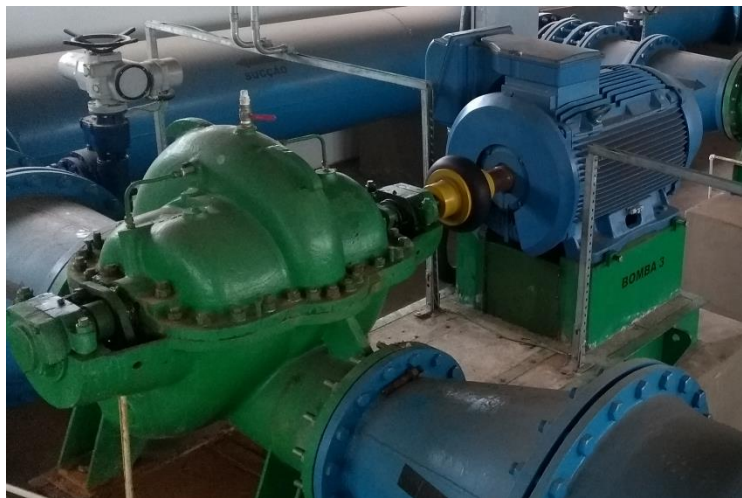
Figura 6 - Conjunto de eixo horizontal.
