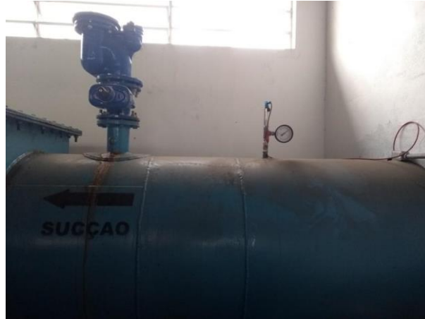
Figura 32 - Sensor de Pressão de Sucção
