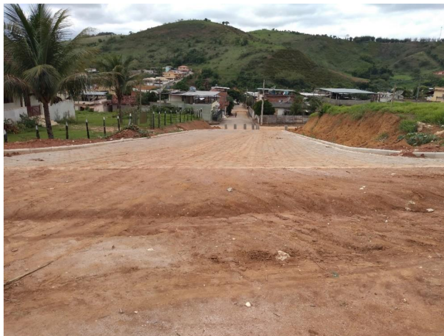
Figura 35: Imagem do prolongamento Rua Francisco Xavier de Carvalho já pavimentada.
