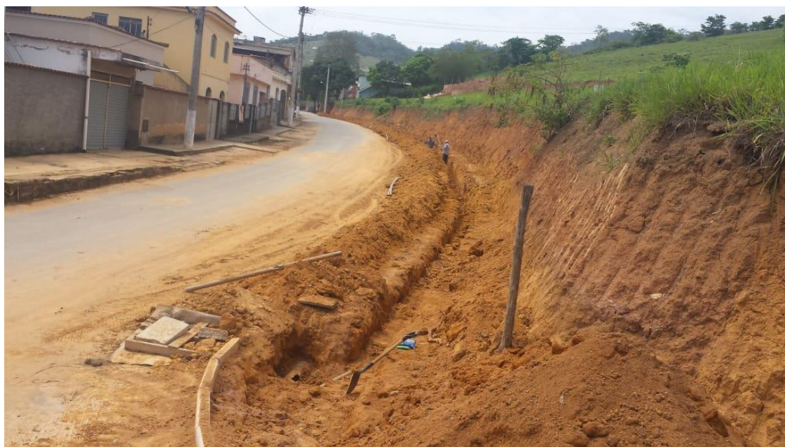
Figura 26: Preparação do solo para colocação da tubulação da rede de água.
