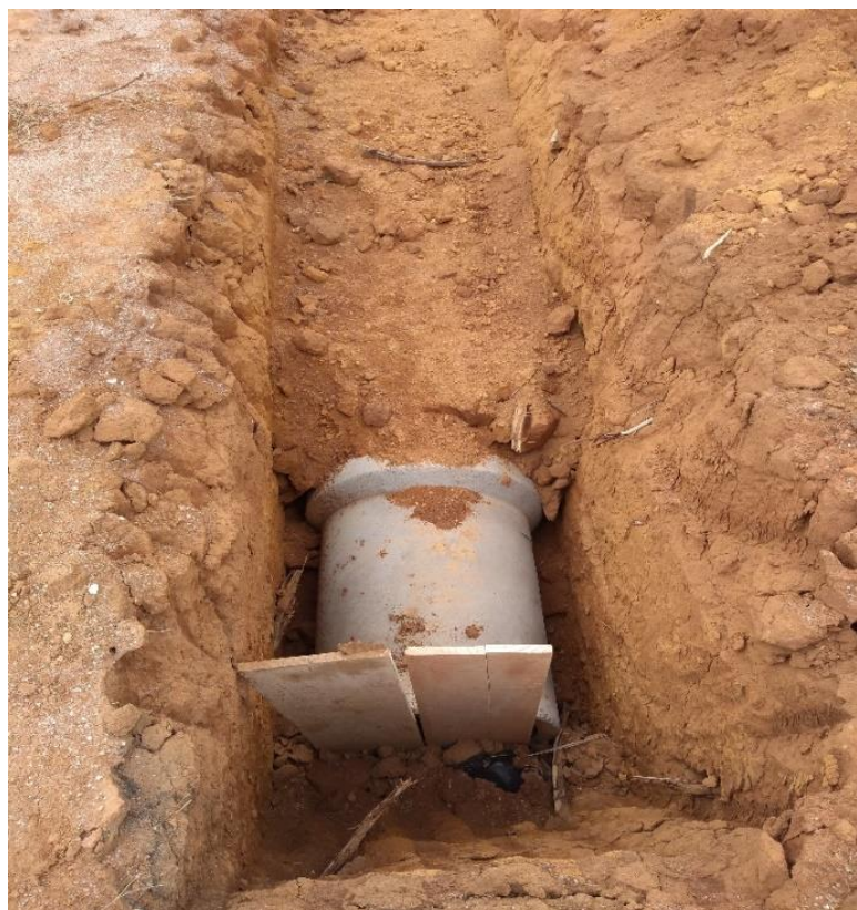
Figura 24: Imagem da manilha da rede pluvial já colocada.
