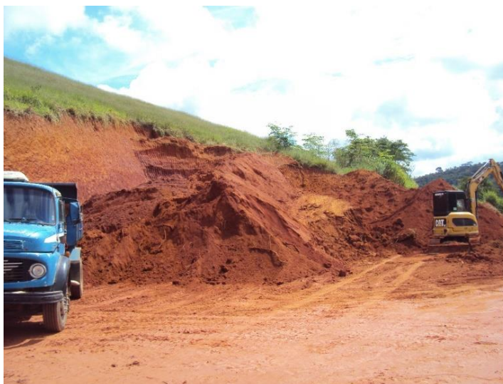
Figura 19: Movimentação de terra sendo feita para abertura das ruas.
