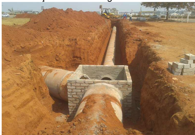
Figura 5: Execução de Caixa e galerias de microdrenagem.
