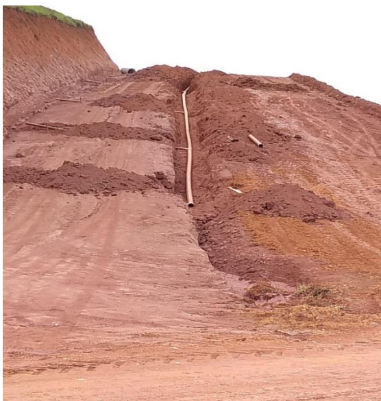
Figura 30: Colocação dos tubos da rede de esgoto na rua.
