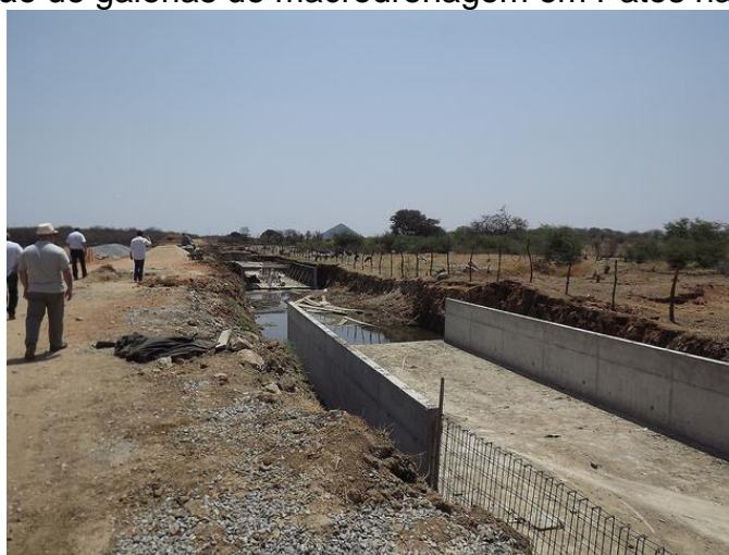
Figura 6: Execução de galerias de macrodrenagem em Patos na Paraíba em 2012
