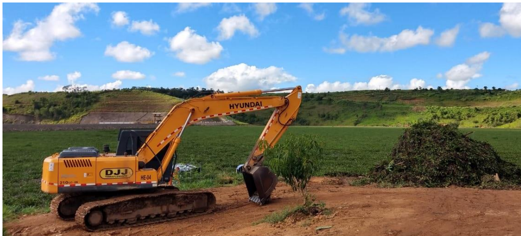
Figura 12 – Retroescavadeira utilizada na retirada das macrófitas
