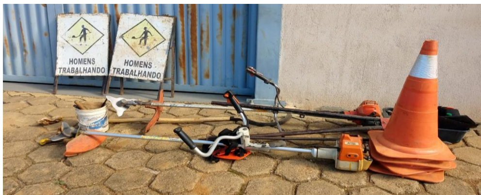
Figura 14 – Equipamentos utilizados para limpeza das estradas.
