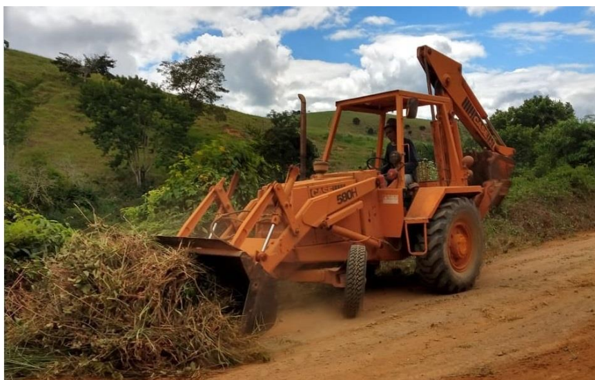
Imagem 16 – Retroescavadeira utilizada na limpeza das estradas.
