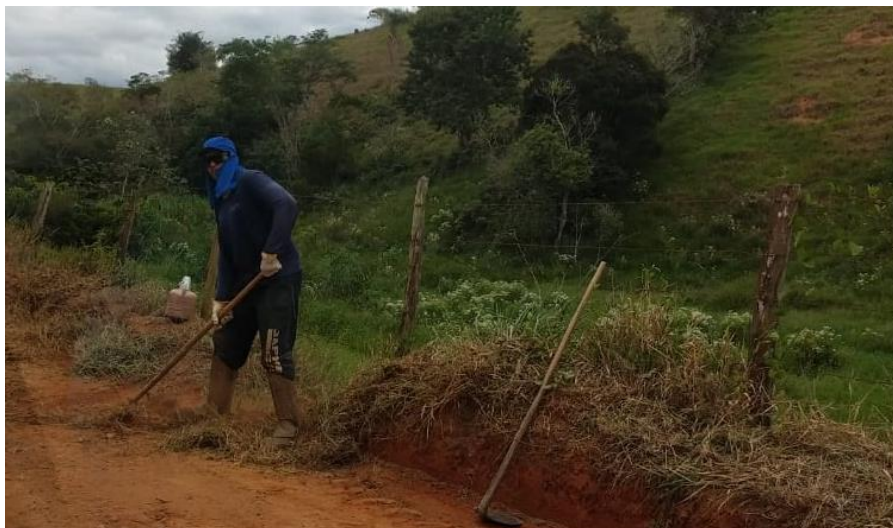
Figura 15 – Trabalhador realizando a atividade de limpeza
