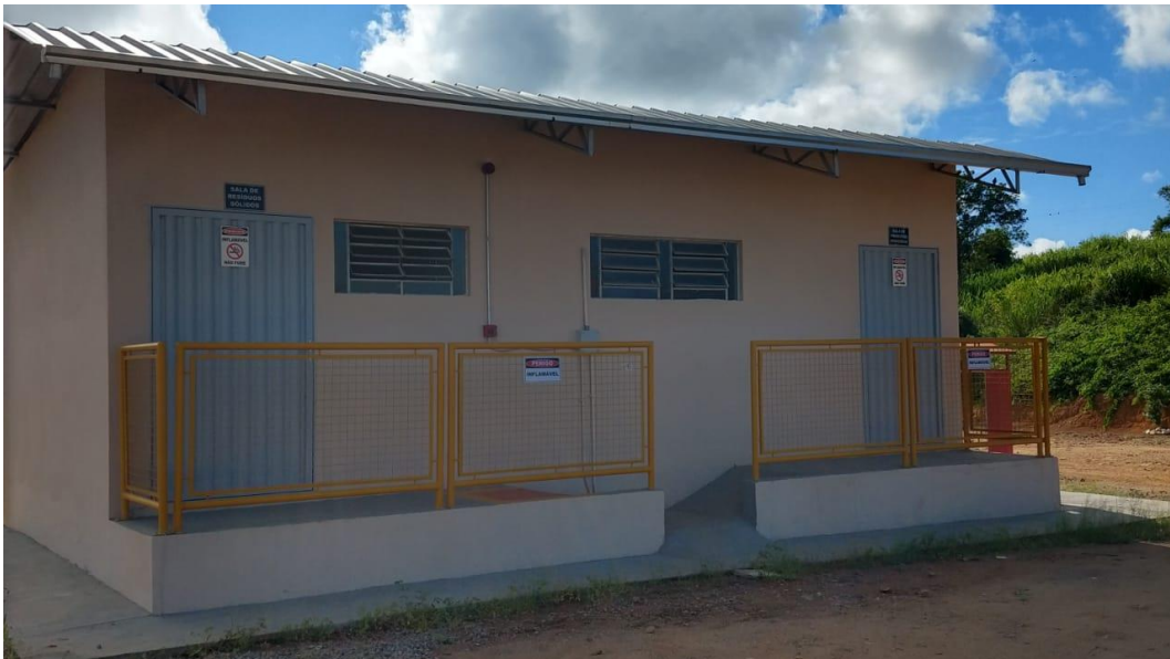
Figura 7 – Salas de armazenamento de resíduos sólidos e produtos inflamáveis.
