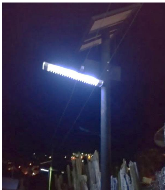
Figura 40 - Primeira iluminação no Bairro Santa Efigênia.
