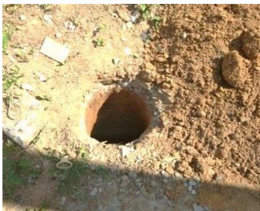
Figura 36 - Ponto onde será inserido um poste.
