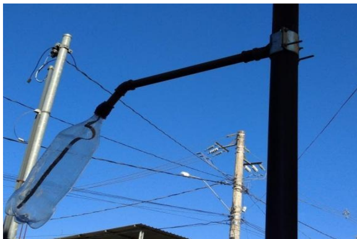
Figura 20 - Disposição da garrafa pet e fita LED.
