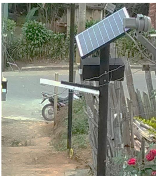
Figura 39 - Estrutura montada na primeira escadaria no bairro Santa Efigênia.
