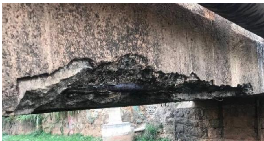
Figura 4.45 Superfície da ponte 2 antes do ensaio
