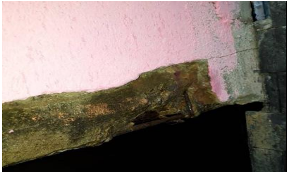
Figura 4.44 Superfície da ponte 1 após o ensaio
