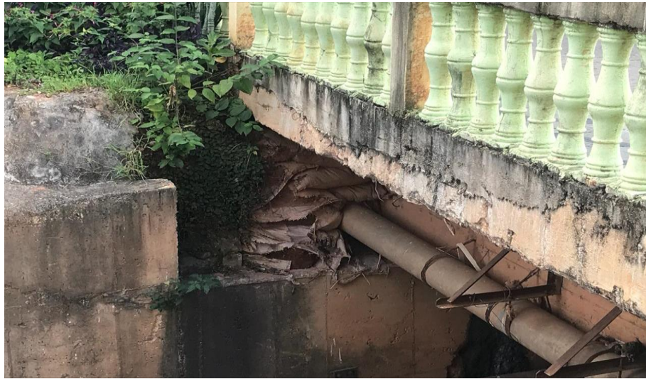
Figura 4.11 Escoras laterais com sacos de areia na ponte 4
