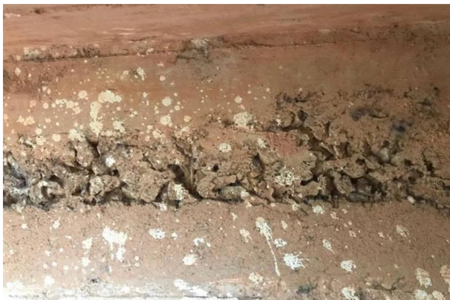
Figura 4.47 Superfície da ponte 3 antes do ensaio
