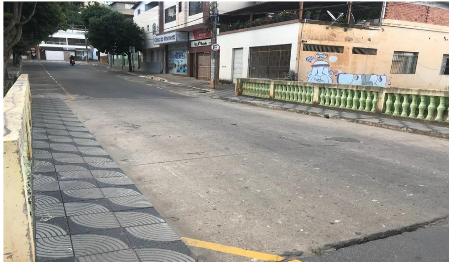
Figura 4.17 Deterioração asfáltica na ponte 4
