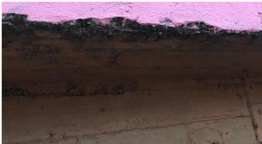
Figura 4.49 Superfície da ponte 4 antes do ensaio
