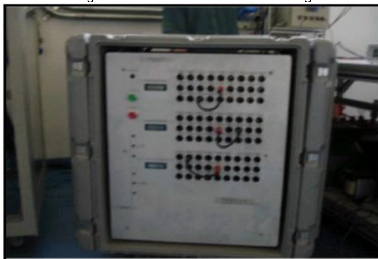
Figura 25 - Fonte de Tensão Porto-Sag
