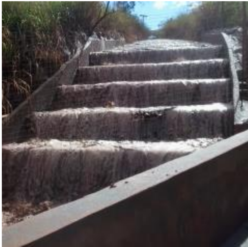
Figura 4.1: Escada Hidráulica por onde é medido o volume das perdas dos tanques de selagem e de polpa.
