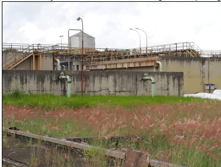
Figura 6: Vista da Estação de Tratamento de Esgoto de Ipatinga/MG
