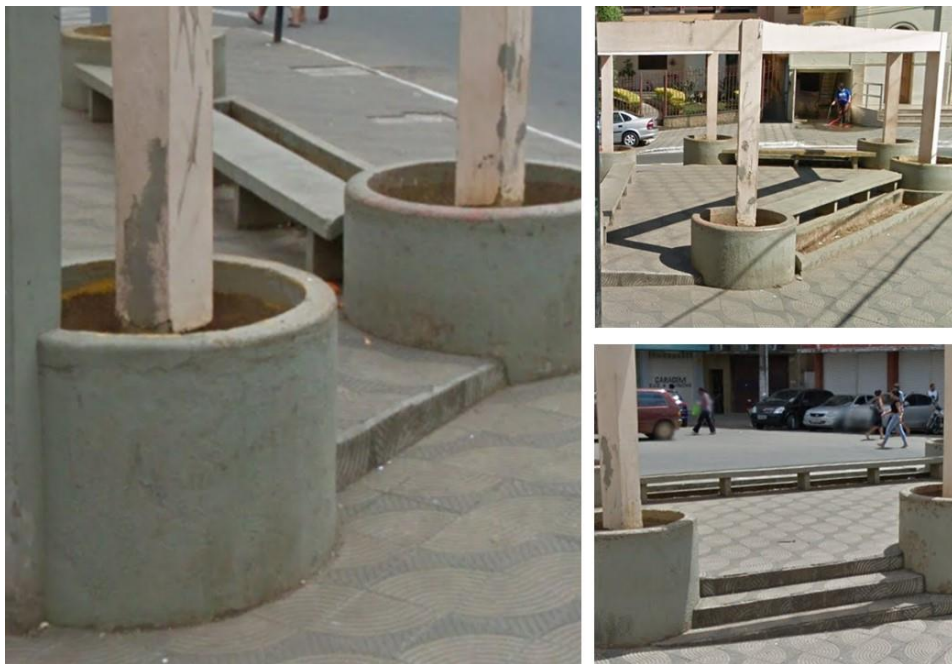
Figura 26: Barreiras físicas encontradas na praça
