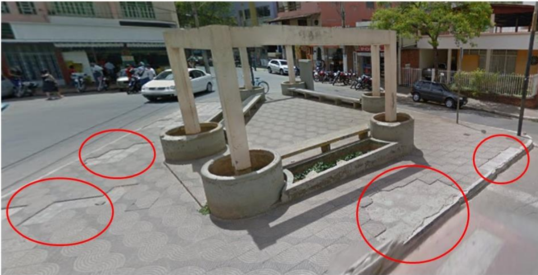
Figura 27: Pavimentação danificada
