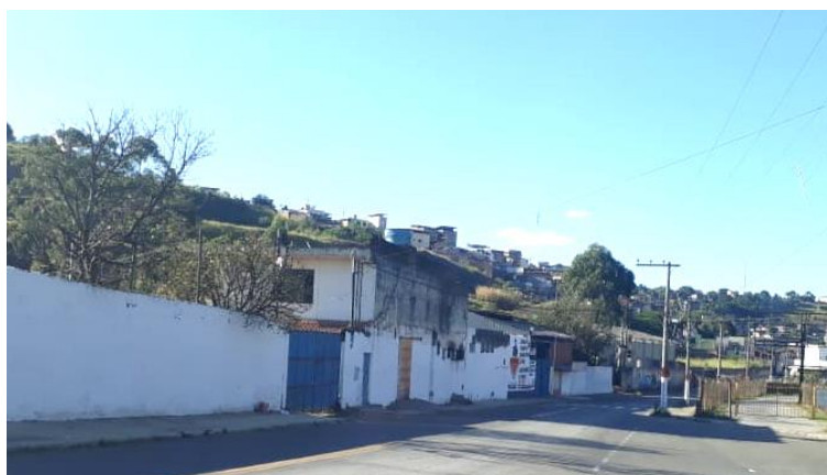
Figura 56 – Instalações a serem demolidas.
