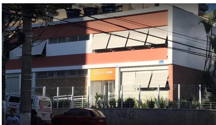
Figura 44 – Fachada da Escola HUB.
