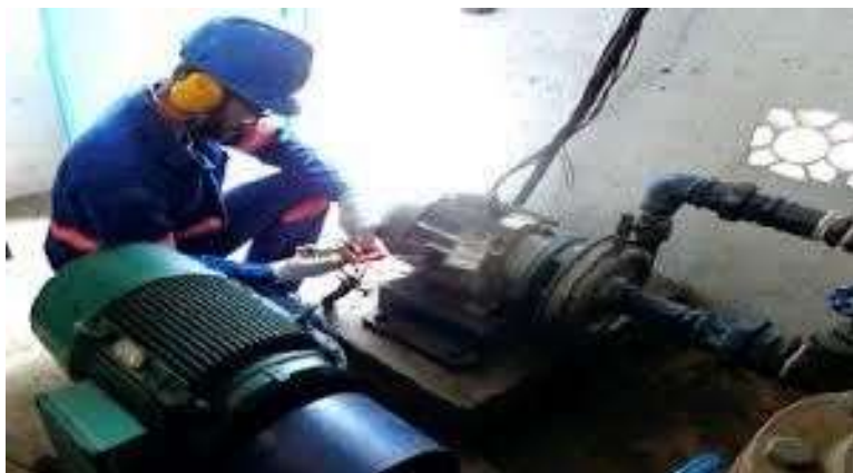
Figura 02: Conjunto moto bomba (realiza a recirculação da água presente no sistema de um filtro)
