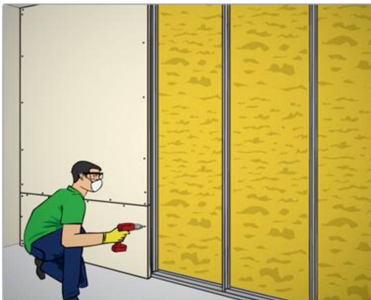
FIGURA 6: Instalação das chapas do outro lado da parede
