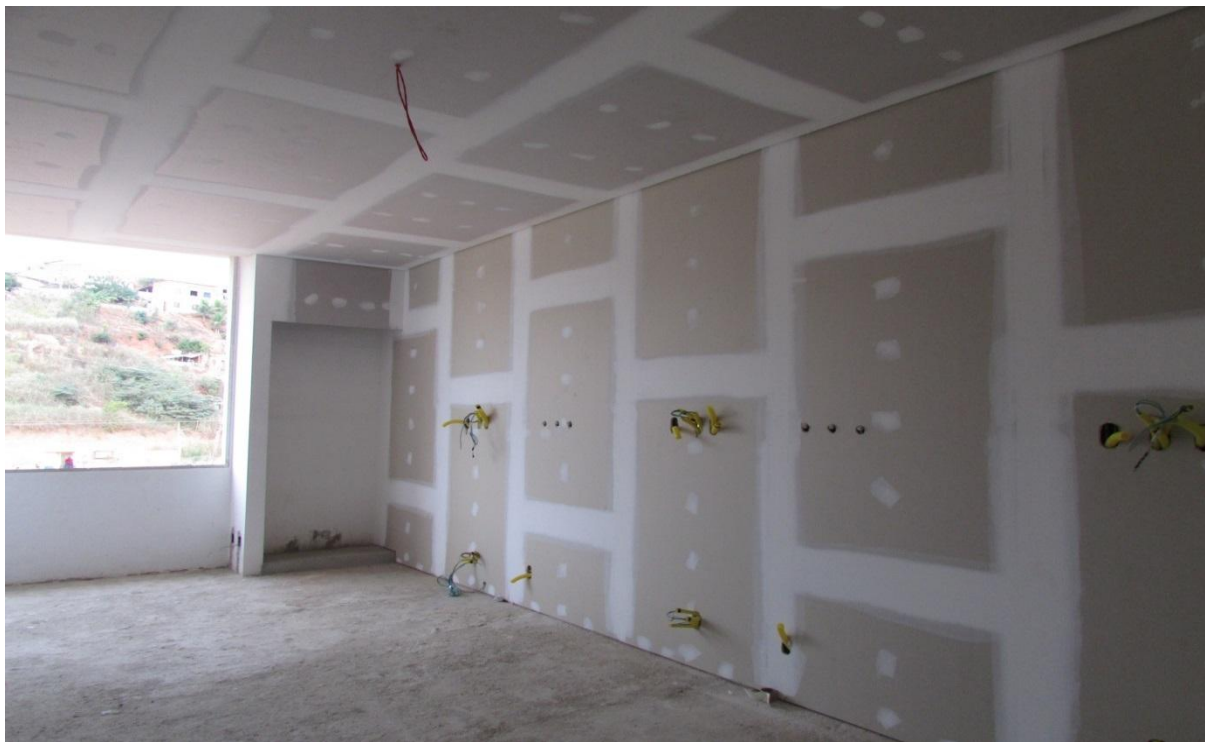
FIGURA 12 - Sistema construtivo drywall pronto (HRTO)
