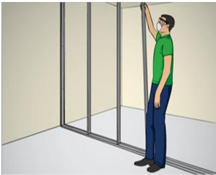
FIGURA 2: Instalação dos montantes
