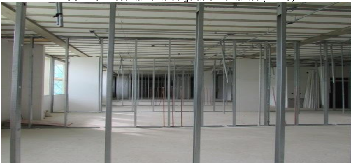
FIGURA 9 - Assentamento de guias e montantes (HRTO)
