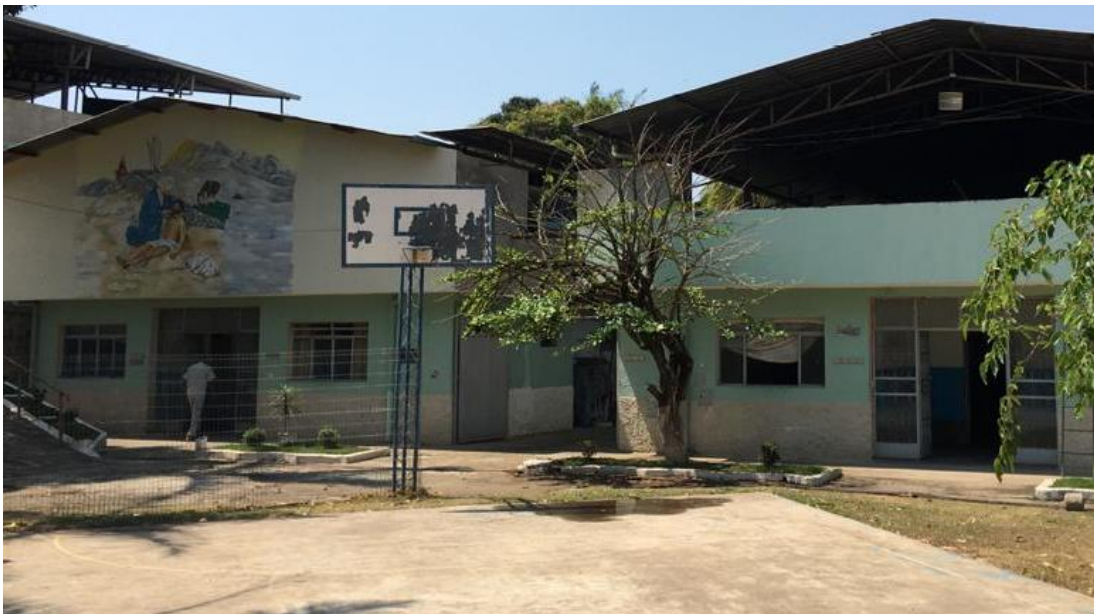
Figura 09 – Fachada atual das alas dos quartos.
