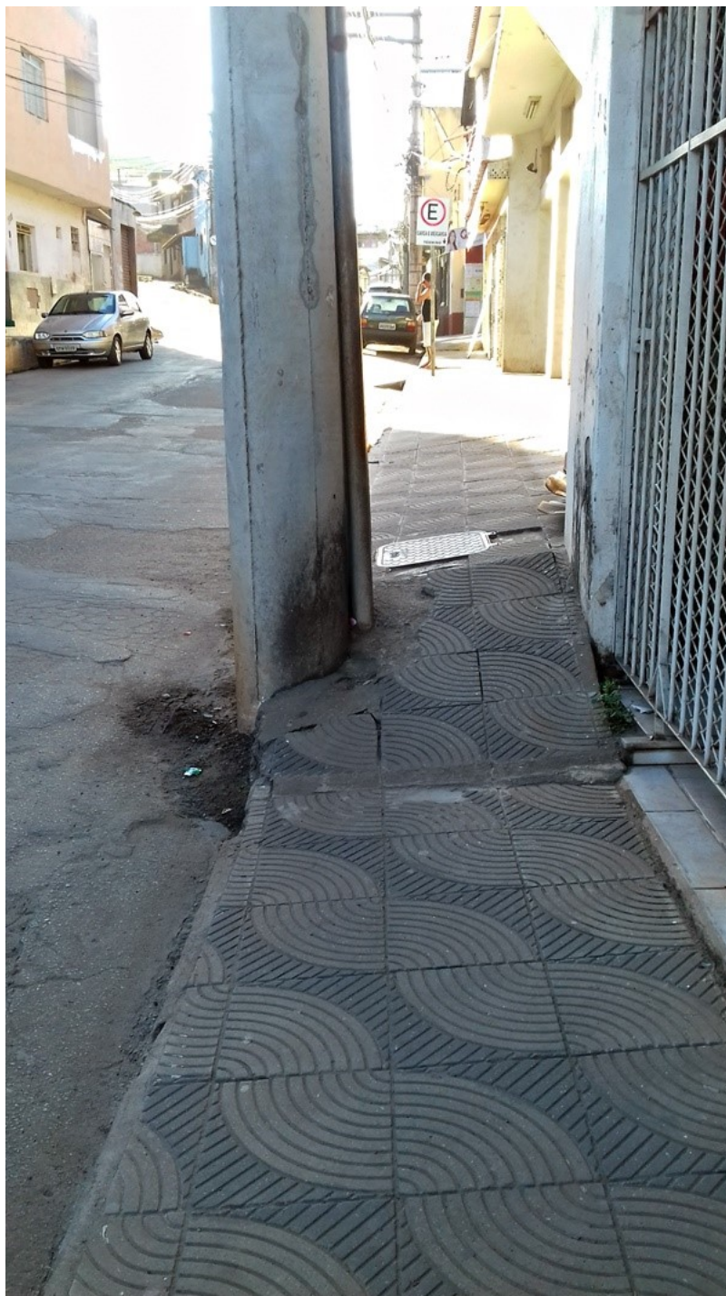
Figura 31: Poste de iluminação no meio do passeio público.
