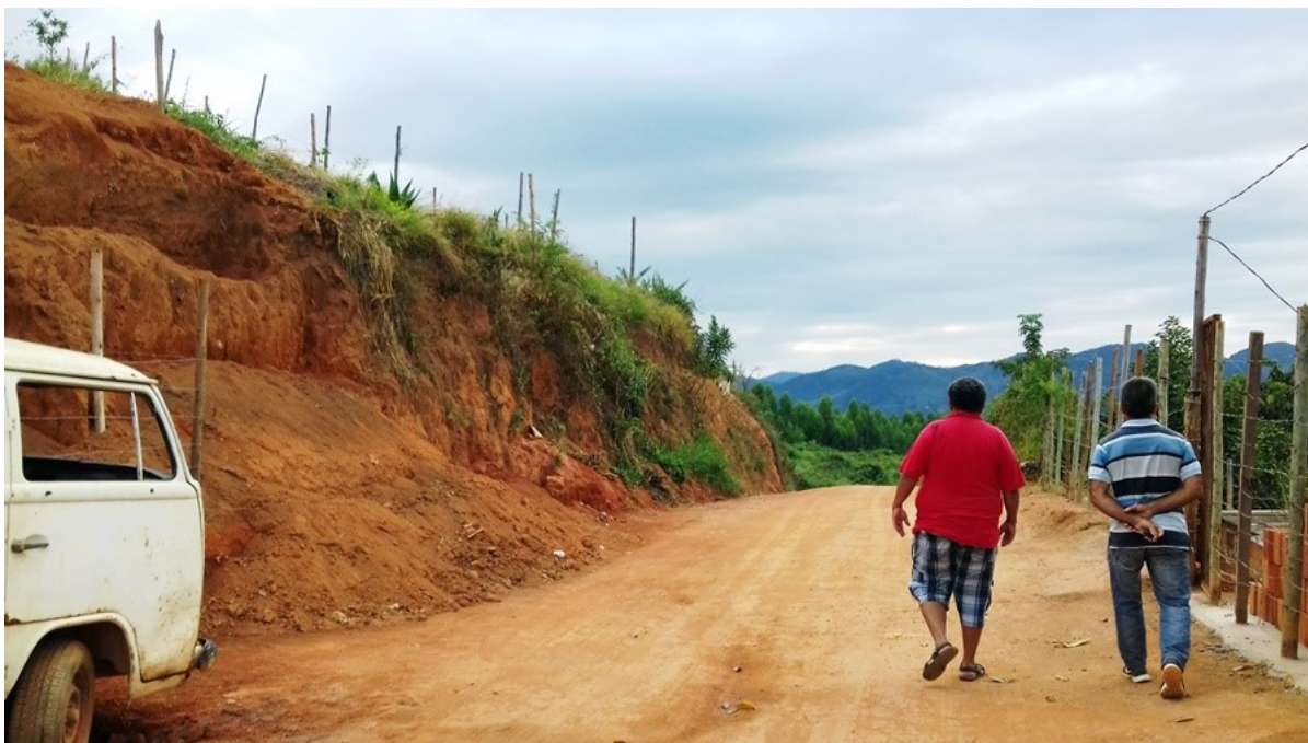
Figura 7: Ausência de Pavimentação na rua Eduardo Ferreira, bairro Dr. Eduardo
