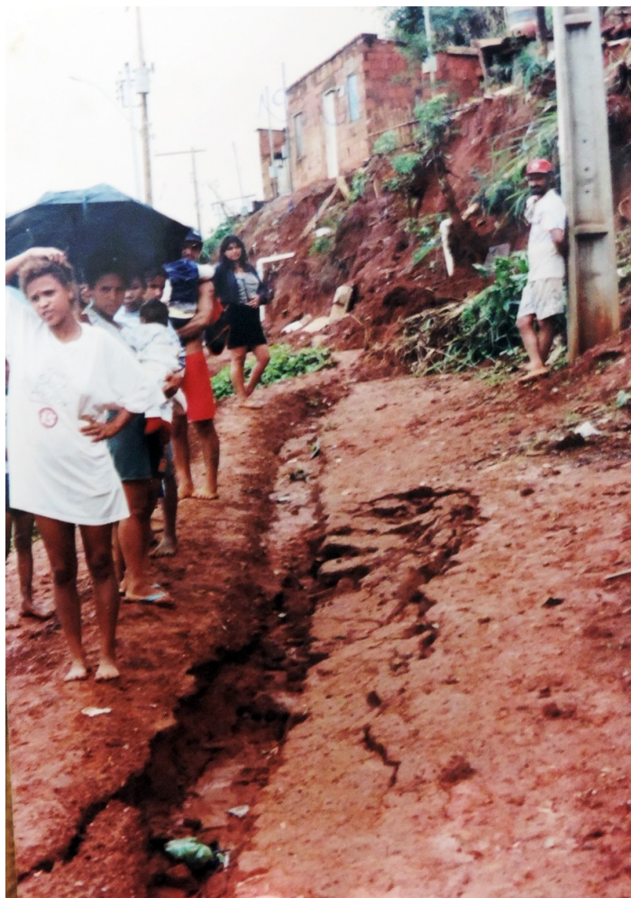
Figura 4: Rua Ângelo Porcaro, Um local Condenado
