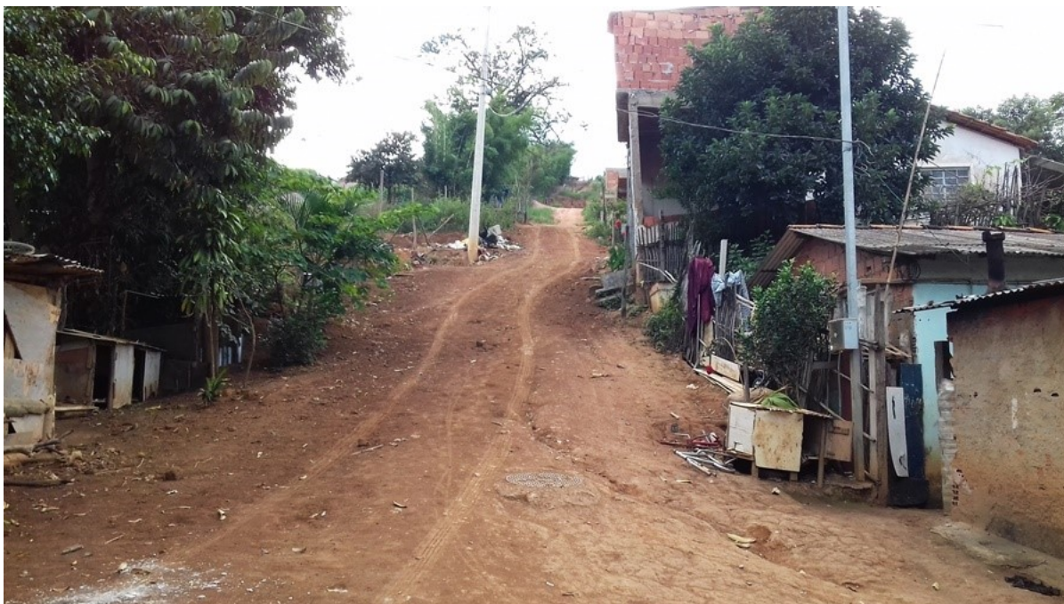
Figura 10: Rua sem Calçamento
