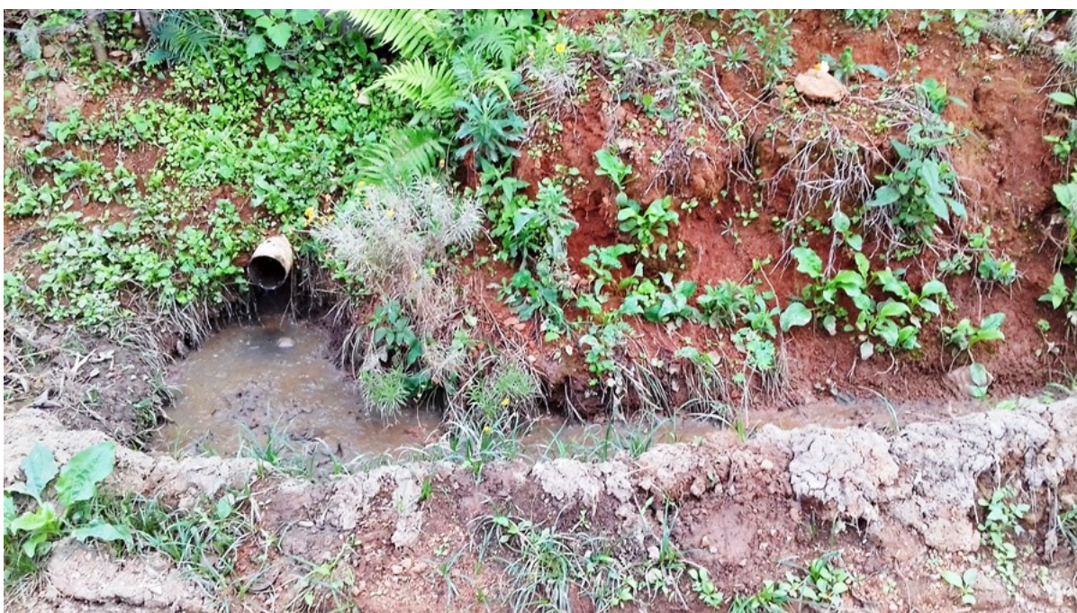
Figura 6: Esgoto a céu aberto na rua Eduardo Ferreira, bairro Dr. Eduardo
