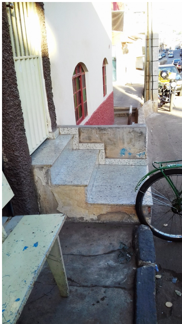
Figura 30: Escada construída no meio da calçada.
