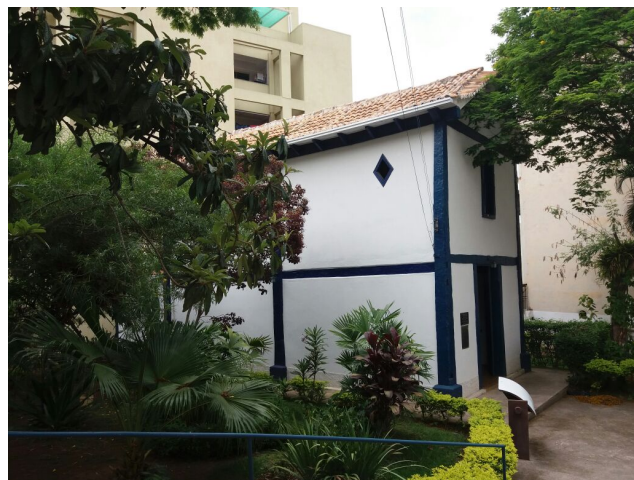
Figura 2: Vista lateral da Igreja São João.
