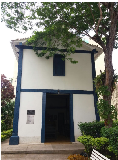
Figura 3: Fachada da Igreja São João. Fonte: Acervo do autor.
