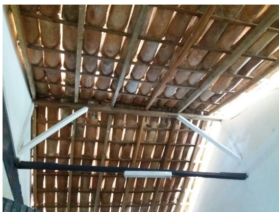
Figura 10: Telhado sem forro (fundos). Fonte: Acervo do autor.
