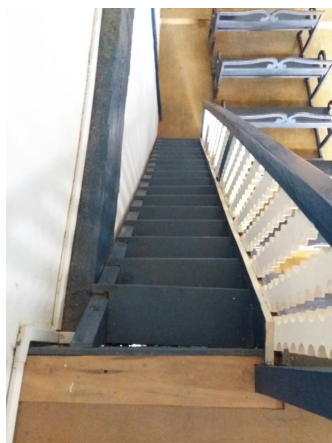
Figura 6: Escada de madeira. Fonte: Acervo do autor.
