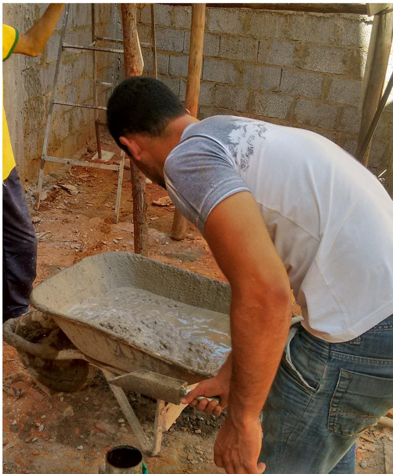
**Figura 11:** Preenchimento dos moldes utilizando a concha de seção U.
