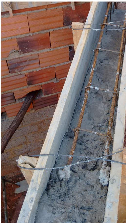
**Figura 9:** Aplicação do concreto as formas.
