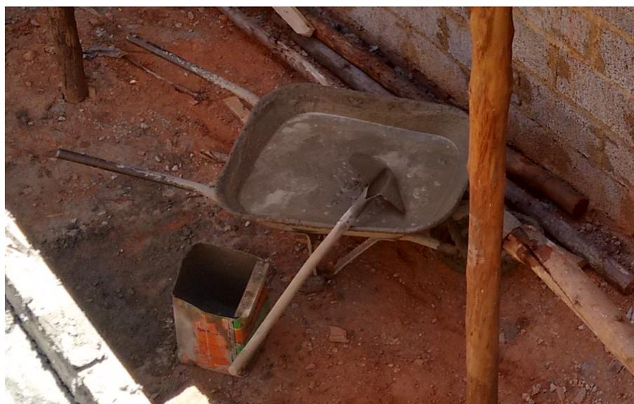
**Figura 8:** Transporte do concreto onde ocorre o assentamento dos agregados graúdos e formação de nata de cimento por exsudação.
