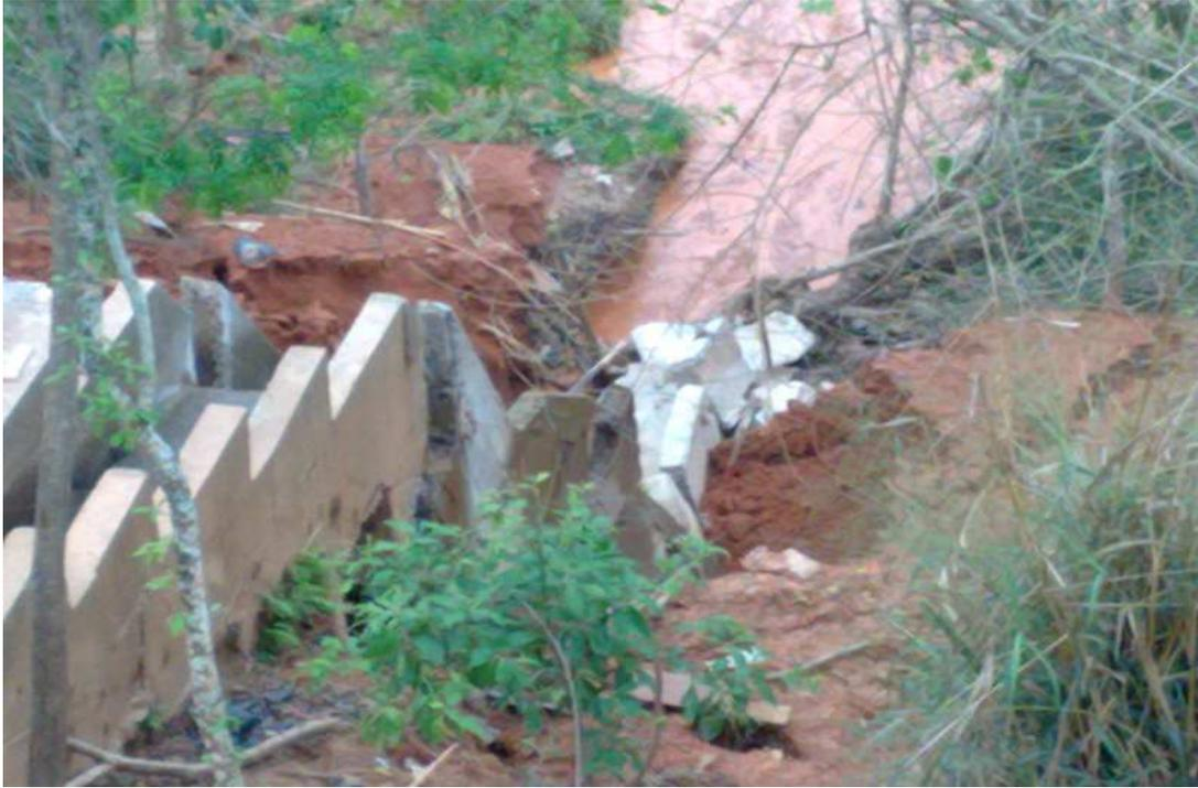
Como descrito acima, e devido a falta de manutenção uma simples recuperação do aterro e da descida d'água, que rompeu e acabou entupindo a boca do bueiro, onde em um outro período chuvoso mais intenso gerou um problema enorme, onde originou a quebra do BSTC Ø 1,00m levando assim ao rompimento da pista levando até a interdição da rodovia como descrito nas imagens abaixo:
