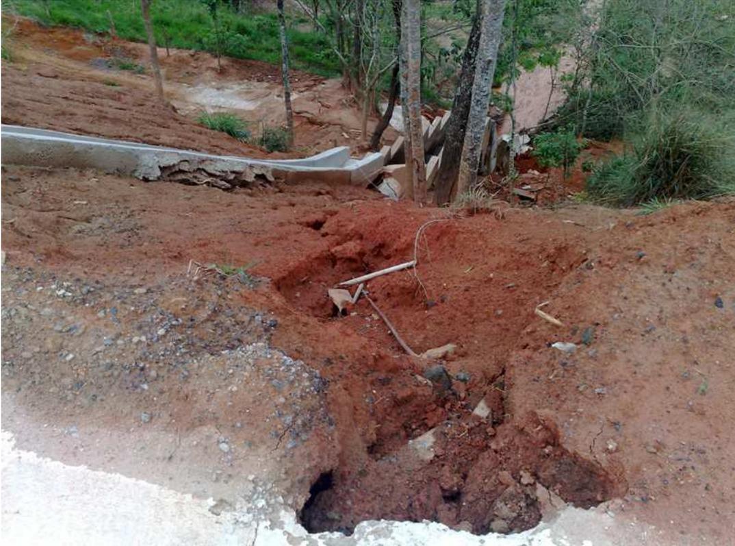
O aterro com 24m de altura, devido a um período de chuva intensa, começou a erosão no corpo do aterro até o pé do aterro.
