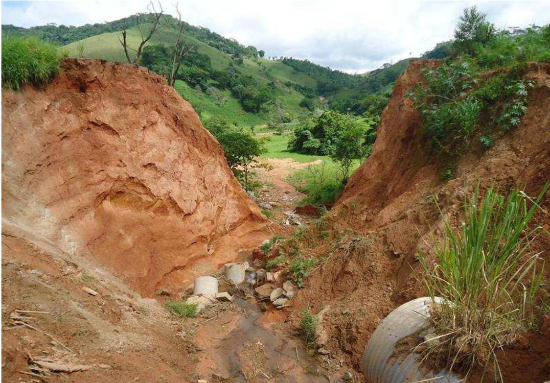
Uma simples erosão no aterro e conseqüentemente a quebra da descida d'água originou todo este estrago, prejudicando assim o direito dos usuários de trafegarem pela estrada.
