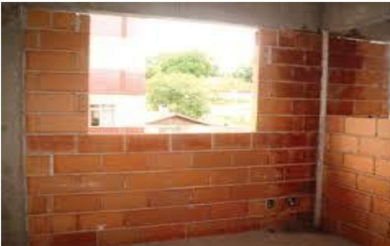
**Figura 3: Fechamento vertical com bloco cerâmico vazado**
