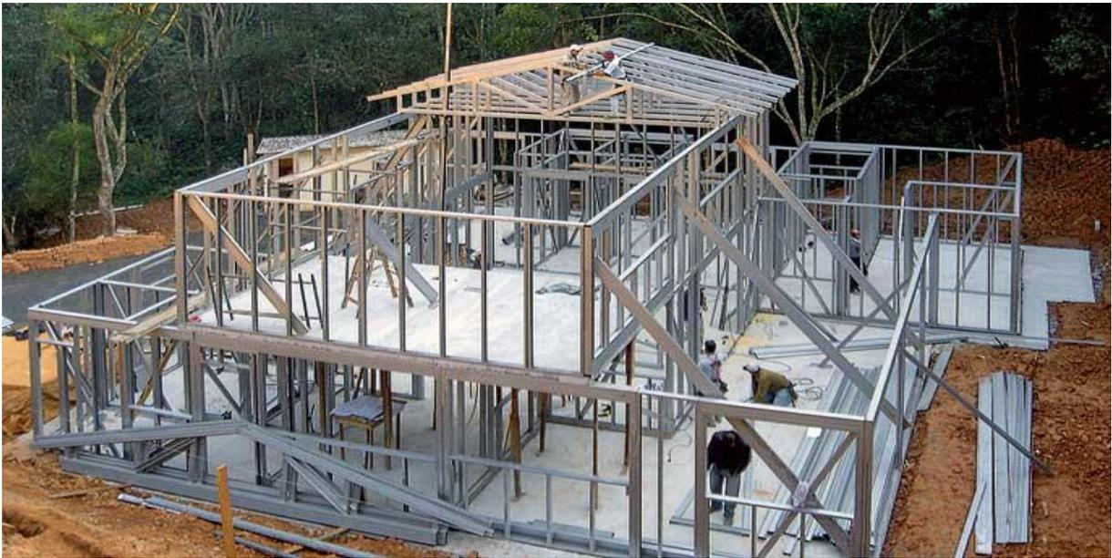
**Figura 6: Estrutura de uma Residência em Light Steel Framing**
