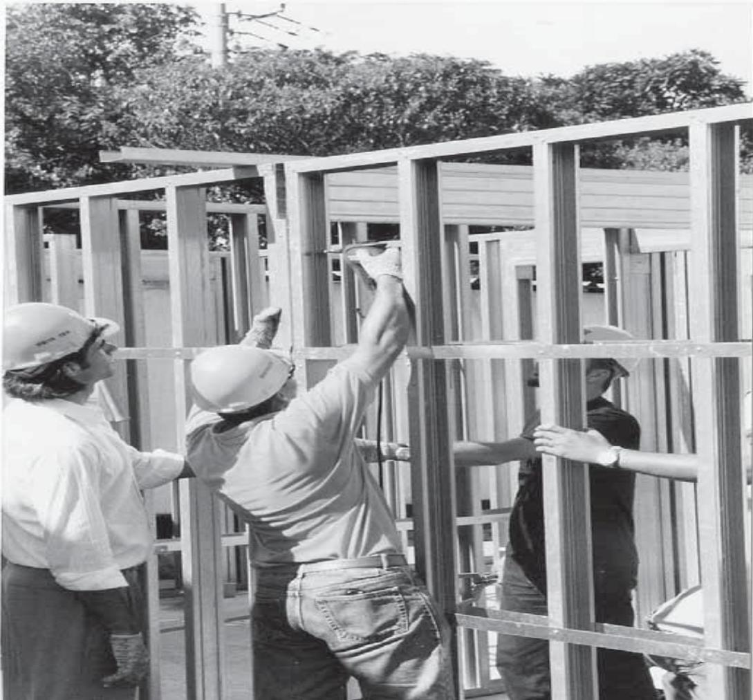
**Figura 21: Fixação dos Painéis com parafusos estruturais.**
