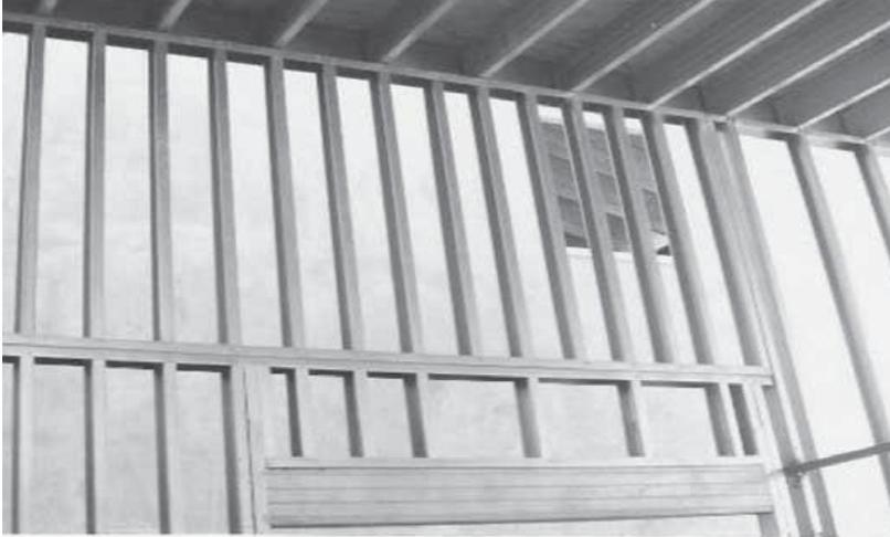
**Figura 12:** Painel cuja modulação é de 200 mm devido à carga de caixa d'água.
