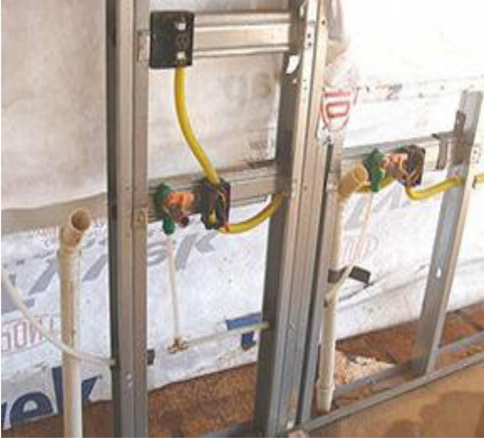
**Figura 23: Instalação elétrica e hidráulica fixada nos painéis de aço galvanizado.**
