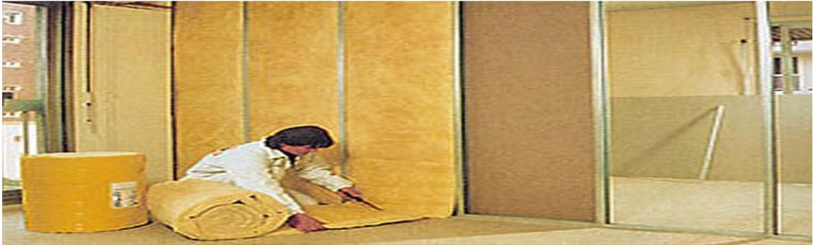
**Figura 20: Instalação de lã de vidro em painel**
