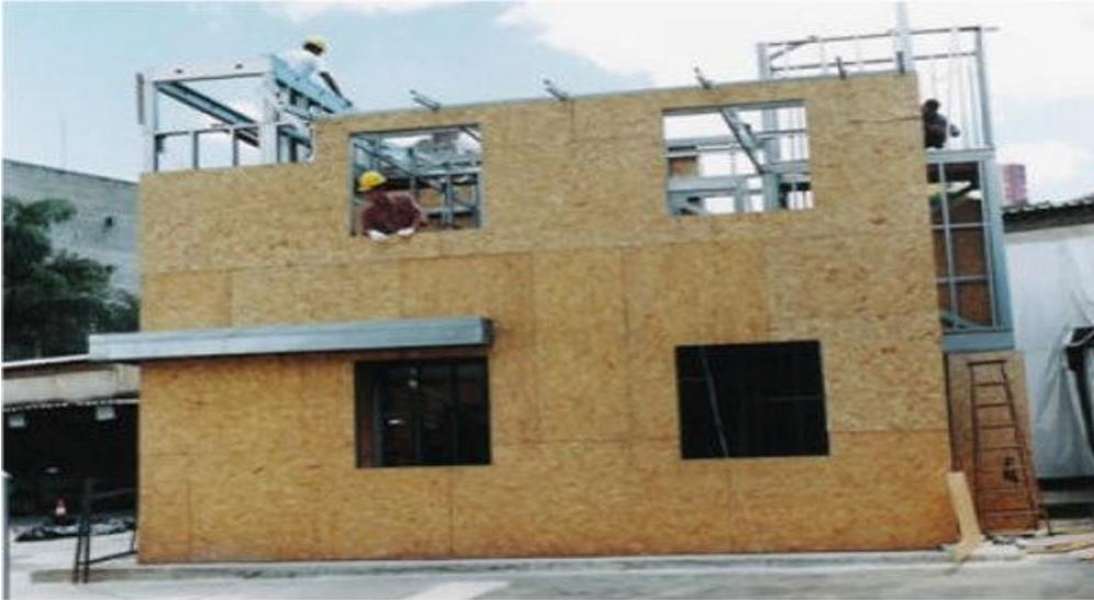
**Figura 17: Fechamento externo em Placas de OSB.**
