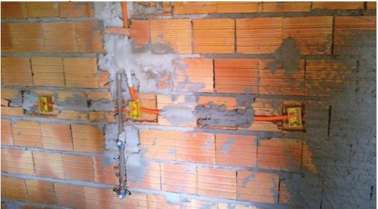
**Figura 5: instalações elétricas e hidrossanitárias: Alvenaria convencional**
