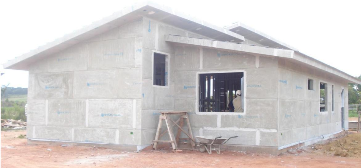
**Figura 18: Fechamento externo com Placas Cimentícias.**
