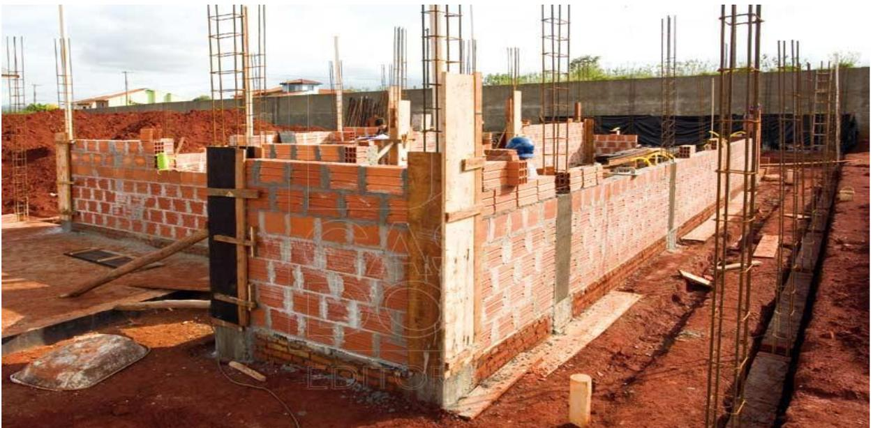
**Figura 1: Alvenaria Convencional**
