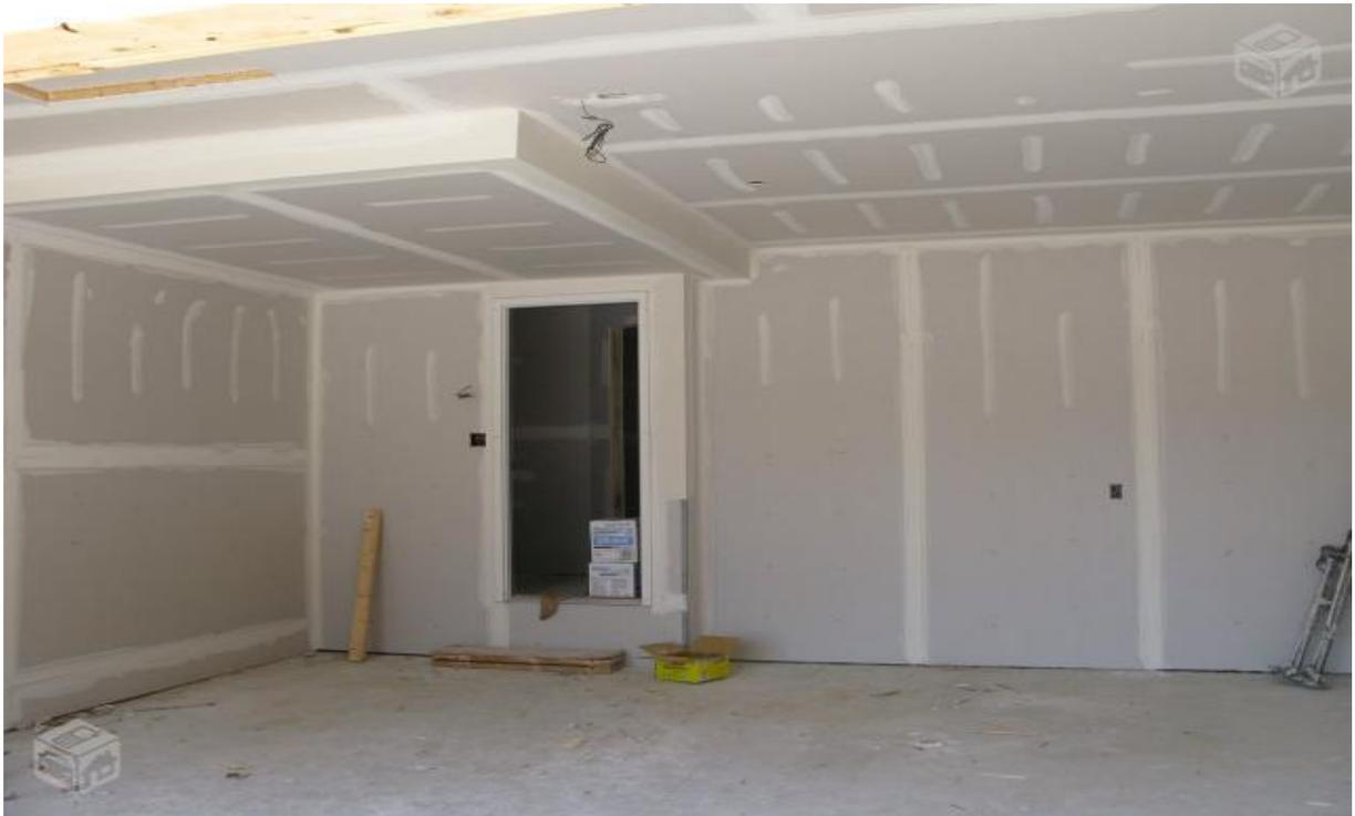
**Figura 19: Fechamento externo com Placas de Gesso acartonado.**
