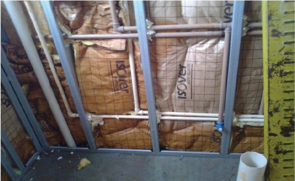
**Figura 22: Instalação hidrossanitária**
