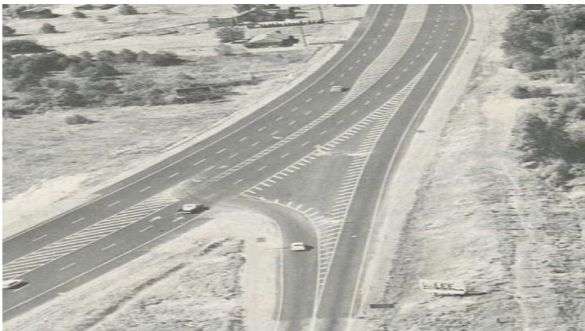
Figura 2-1: Exemplo de interseções em nível
