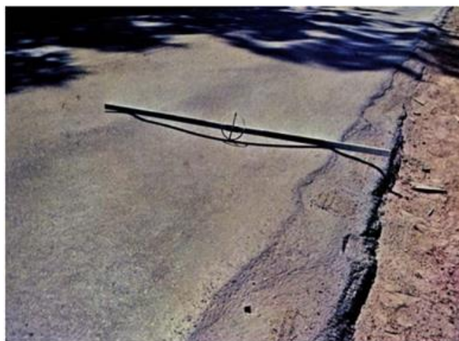
Figura 13 – Afundamento plástico de trilha de roda
