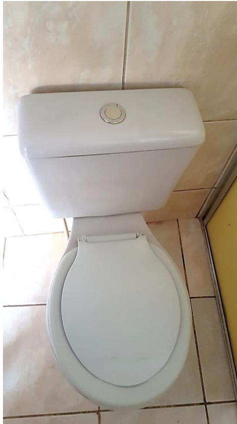
Figura 12 – Bacia Acoplada
