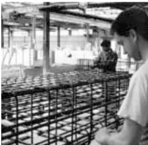
Figura 08 – Execução de armadura de painel.
