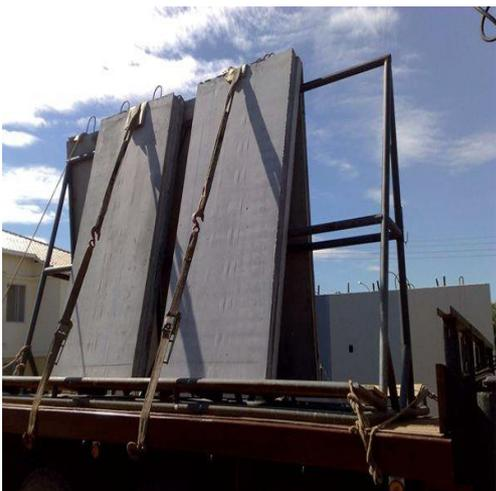
Figura 09 – Transporte de painéis pré-moldados de concreto.
