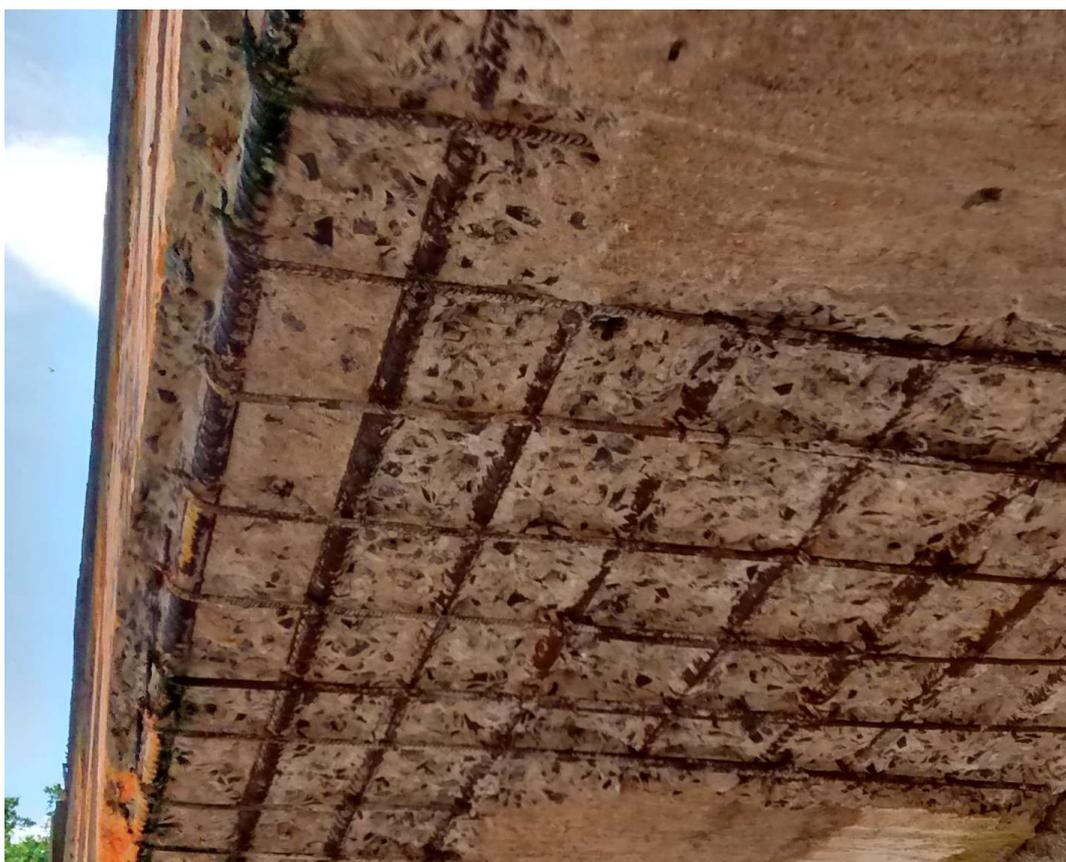
Figura 3 – Corrosão da Armadura. (Google Imagens, 2019)
