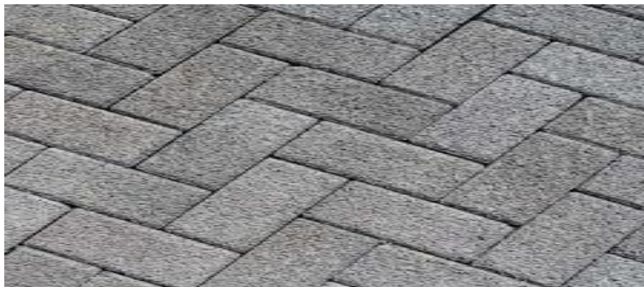
Figura 14: Pavimento de bloco Inter travado poroso
