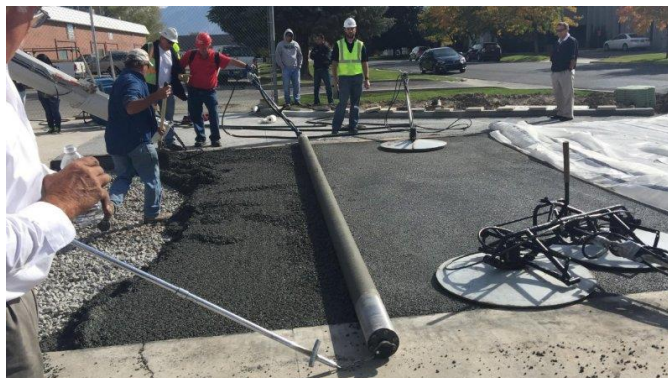
Figura 16: Pavimentação de concreto permeável moldado no local
