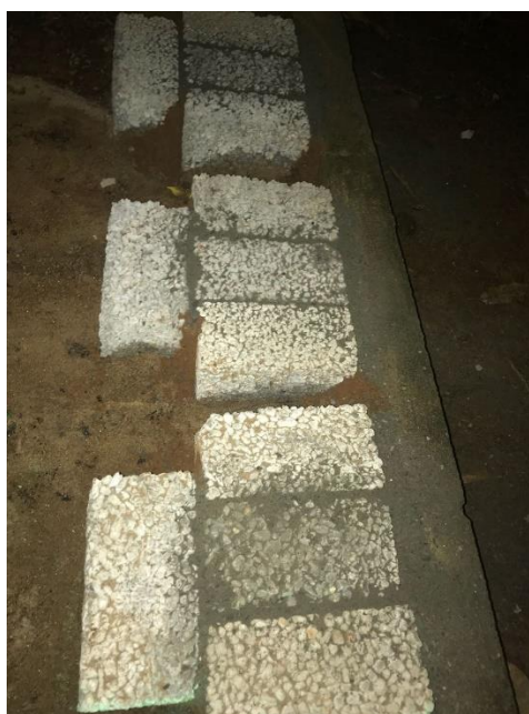
Figura 46: Aplicação do pó de pedra no rejunte nos blocos para o ensaio de percolação
