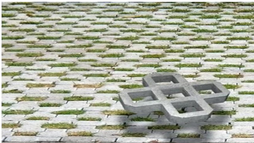
Figura 13: Pavimento com revestimento em concreto vazado.
