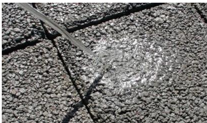
Figura 15: Revestimento permeável com placas de concreto
