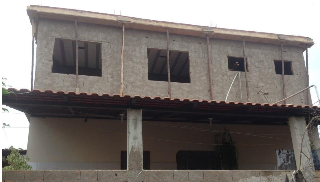
Figura 4.1: Edificação do estudo de caso 01.
