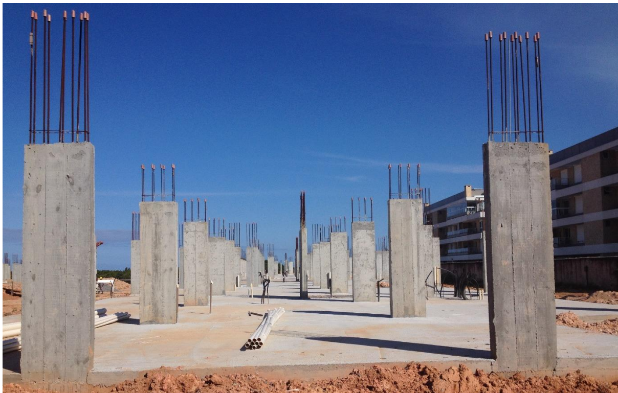
Figura 2.6: Pilares de concreto armado.
