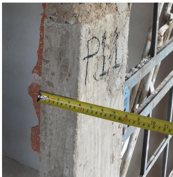
Figura 5.14: Caso 02 – pilar com menor dimensão de 09 cm.
