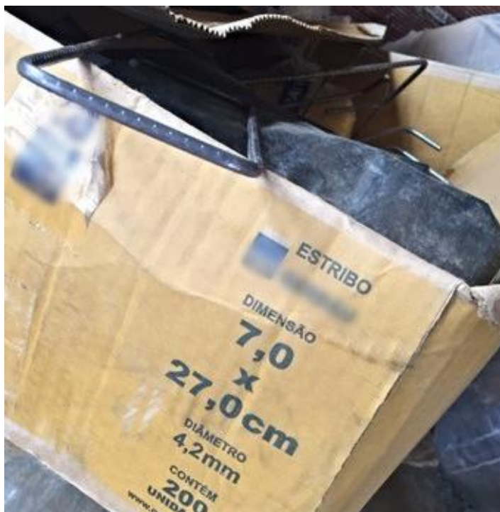
Figura 5.3: Caso 01 – estribos com 4,2 mm utilizados na obra.
