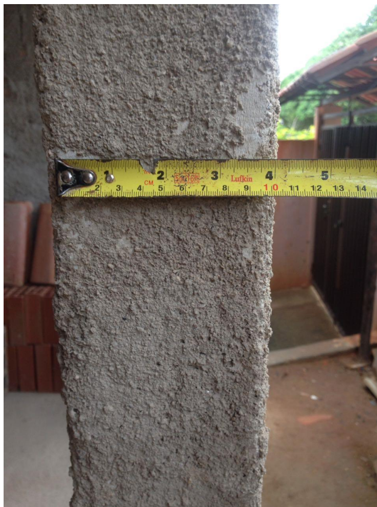
Figura 5.2: Caso 01 – pilar com menor dimensão de 10 cm.
