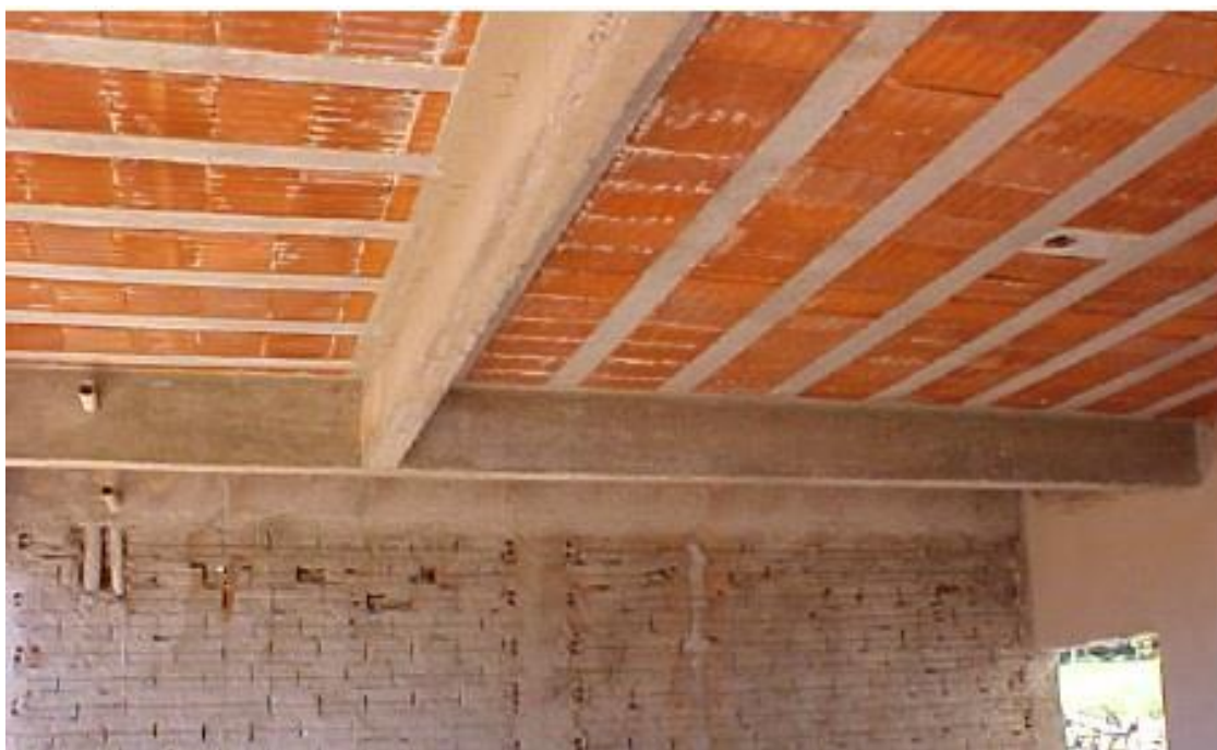
Figura 2.5: Vigas de concreto armado.
