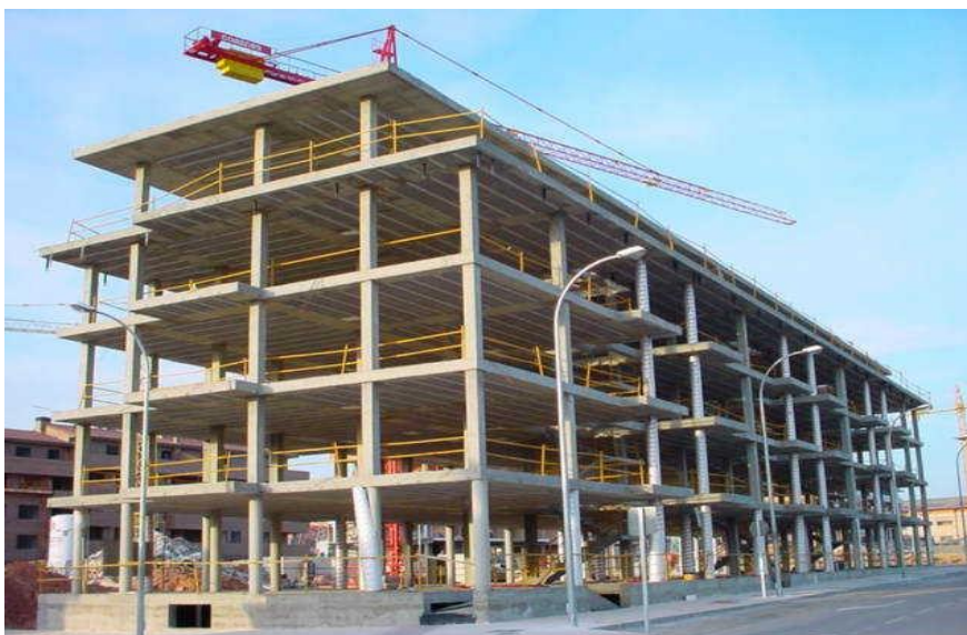
Figura 2.8: Estrutura de concreto armado.
