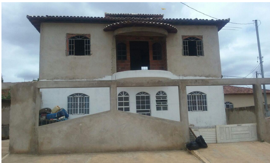
Figura 4.15: Edificação do estudo de caso 02.
