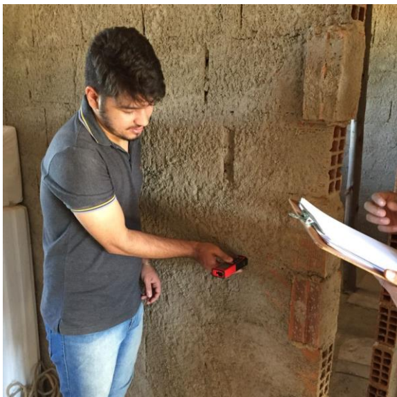
Figura 3.2: Procedimento de medição da obra.
