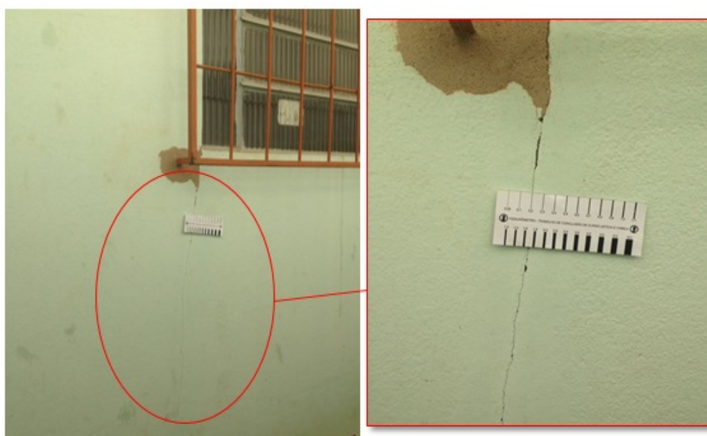
Figura 64: Parede lateral da residência.
