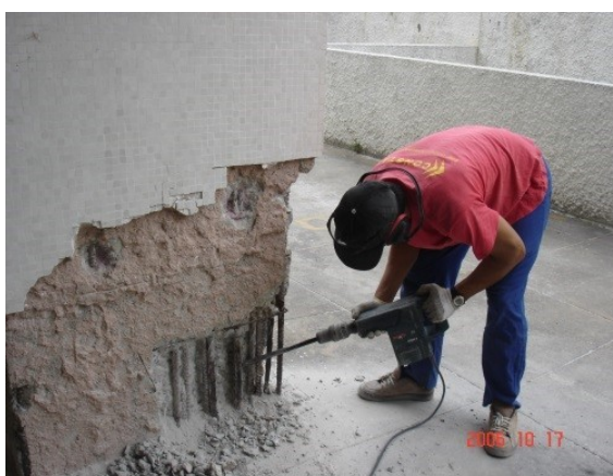
Figura 41: Técnica de apicoamento mecânico.
