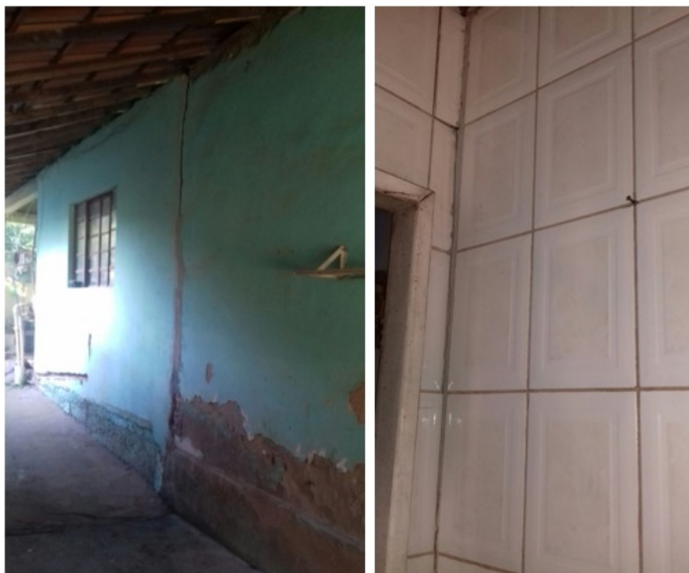
Figura 93: Vista geral da parede externa da residência (esquerda) e vista da parede interna (direita).
