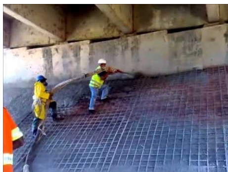
Figura 43: Execução do concreto projetável.
