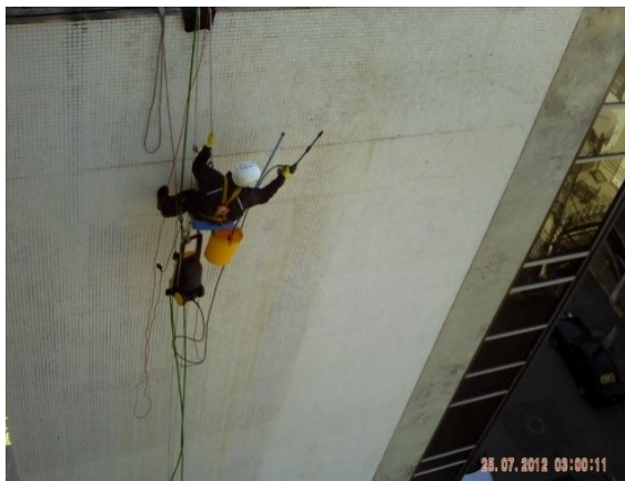
Figura 42: Limpeza com jato de água.
