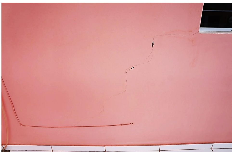
Figura 75: Vista da parte externa da parede do quarto/sacada
