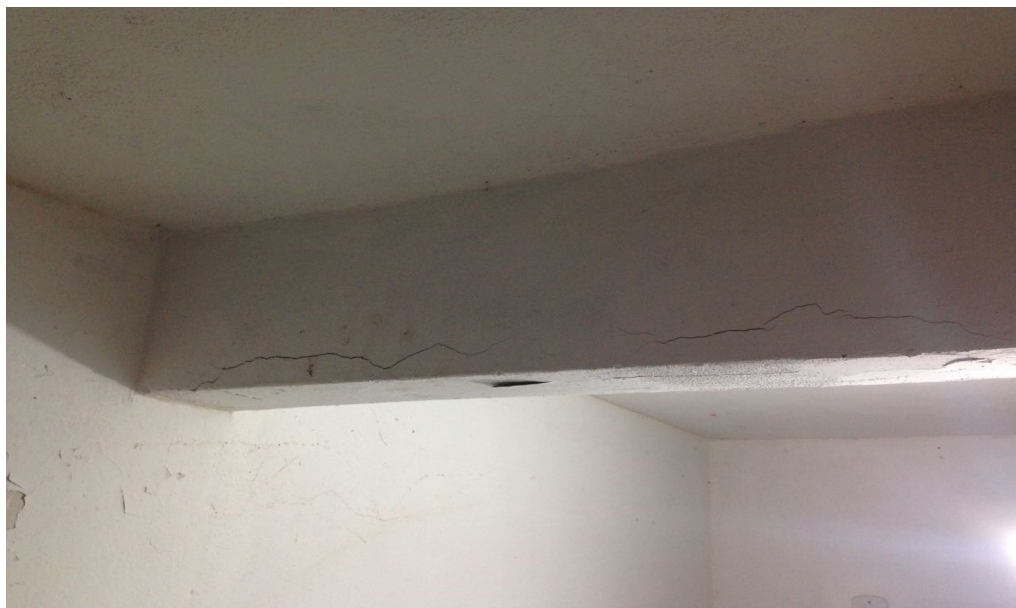
Figura 67: Viga localizada na parte superior do corredor da caixa de escadas.
