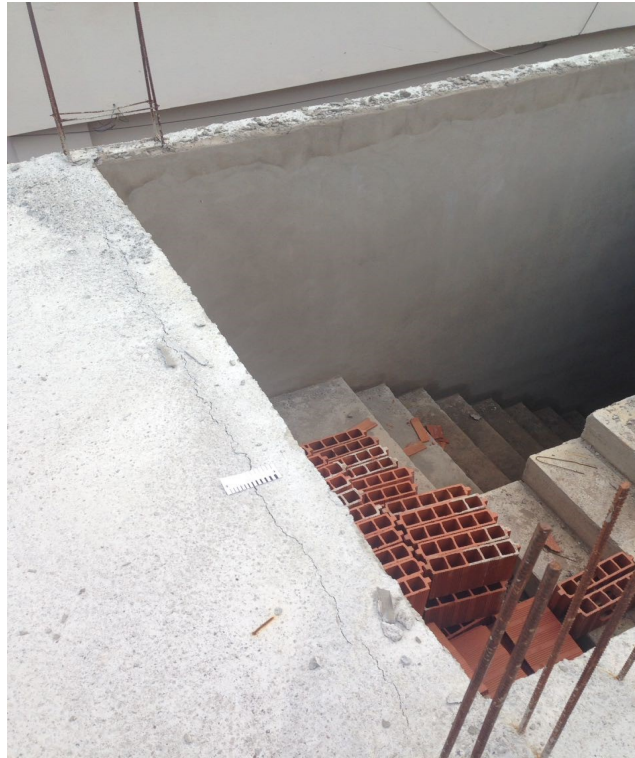
Figura 89: Vista da laje, próximo a caixa de escadas.
