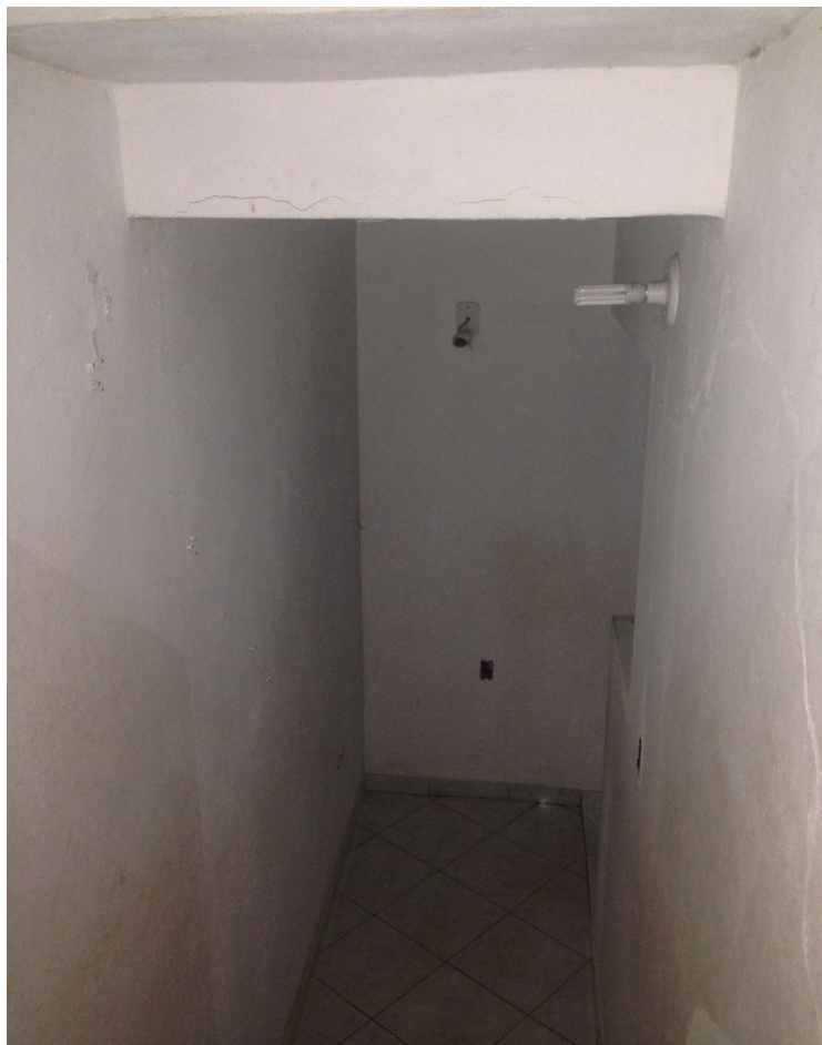
Figura 66: Vista da caixa de escadas.
