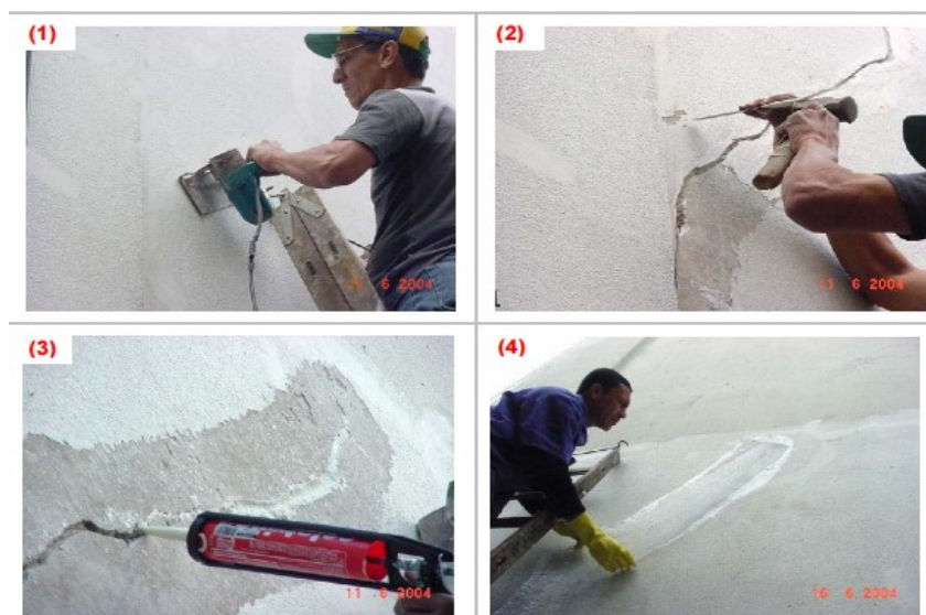
Figura 50: (1) abertura do sulco sobre a fissura com disco de corte; (2) remoção do acabamento da parede; (3) aplicação do selante acrílico; (4) 2ª demão de impermeabilizante acrílico estruturado com tela de poliéster.
