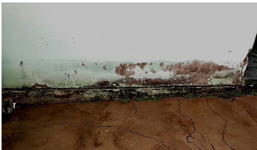
Figura 62: Parede localizada nos fundos da edificação.
