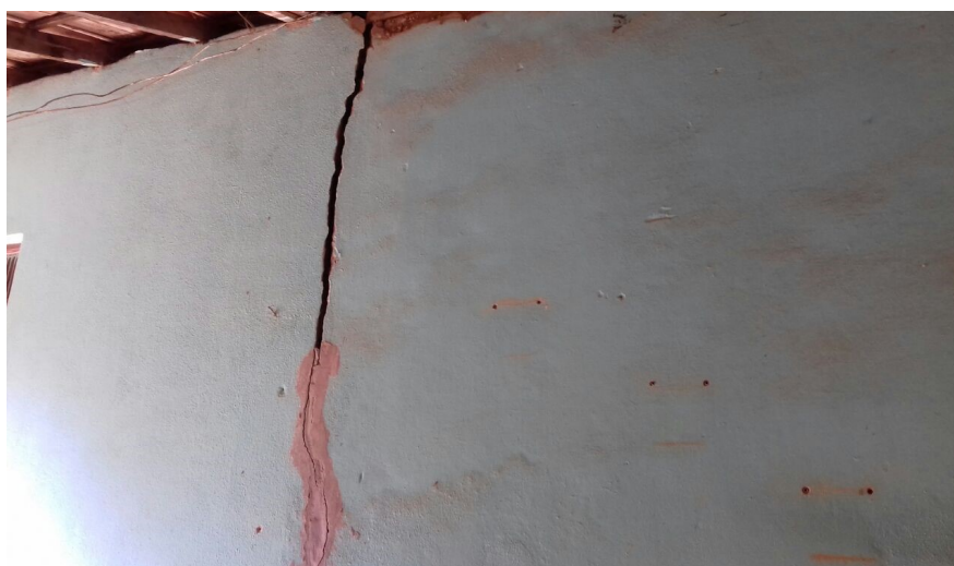
Figura 94: Vista aproximada da parede externa da residência.
