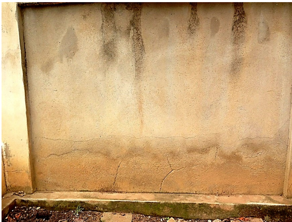
Figura 58: Parede exterior nos fundos da edificação.
