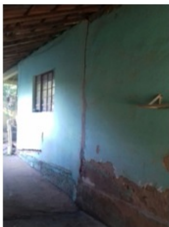
Figura 96: Figura 3.42: Fissura real (esquerda) e configuração típica de fissura causada por recalque (direita).
