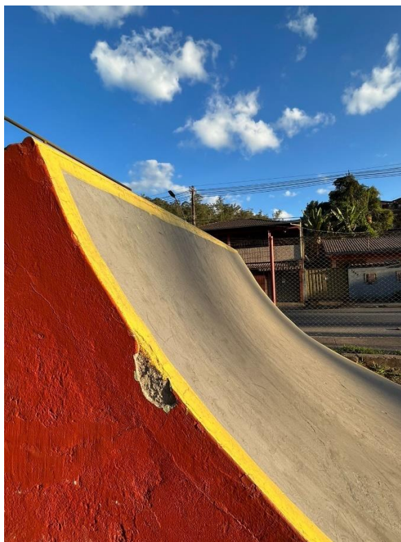
Figura 13 - Rampa Danificada
