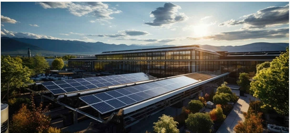
Figura 5 – Conjunto de módulos de Energia Fotovoltaica
