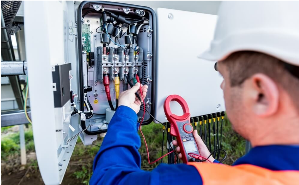
Figura 3 – Inversores Fotovoltaicos
