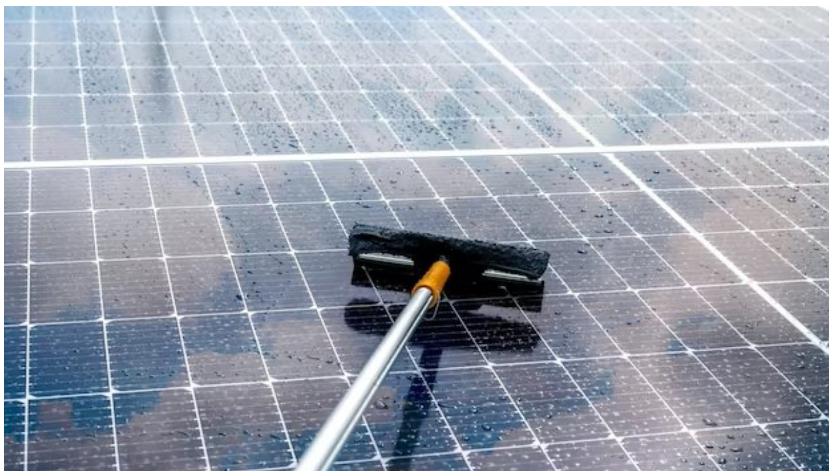
Figura 8 – Limpeza de Usina Solar
