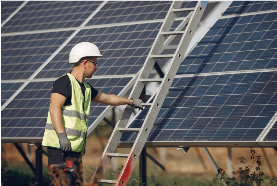
Figura 7 – O&M: Inspeção em Usinas Solares
