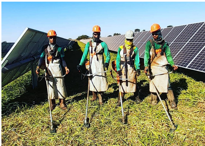
Figura 6 – Roçagem em Usina Solar
