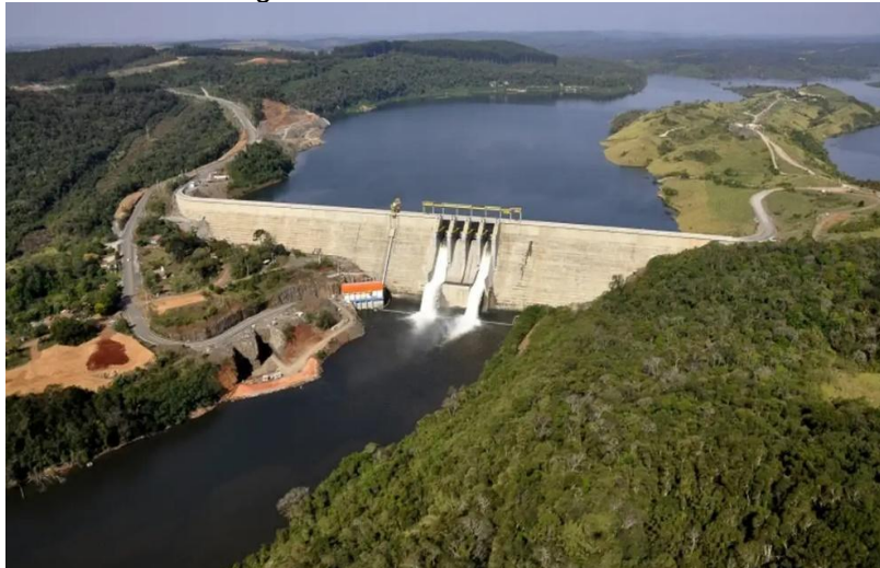
Figura 2 - Usina com reservatório
