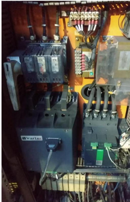
Figura 5 – sistema de carregamento de baterias
