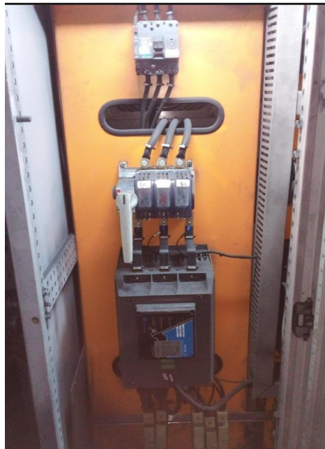
Figura 6 – Retificador para alimentação de eletroimã
