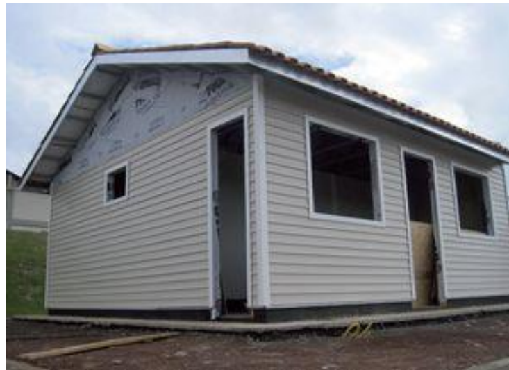
Figura 16: Revestimento externo finalizado em Siding vinílico
