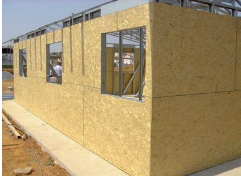
Figura 13: Chapas de OSB fixadas na face externa da estrutura
