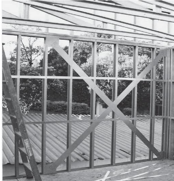
Figura 38: Painel com contraventamento em “X”
