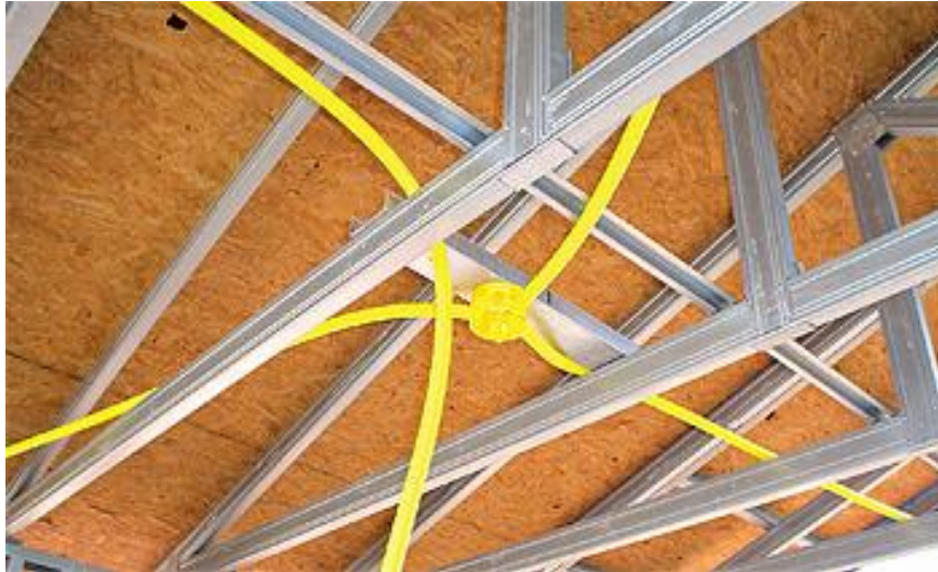
Figura 21: Passagem de instalações por tesoura de cobertura
