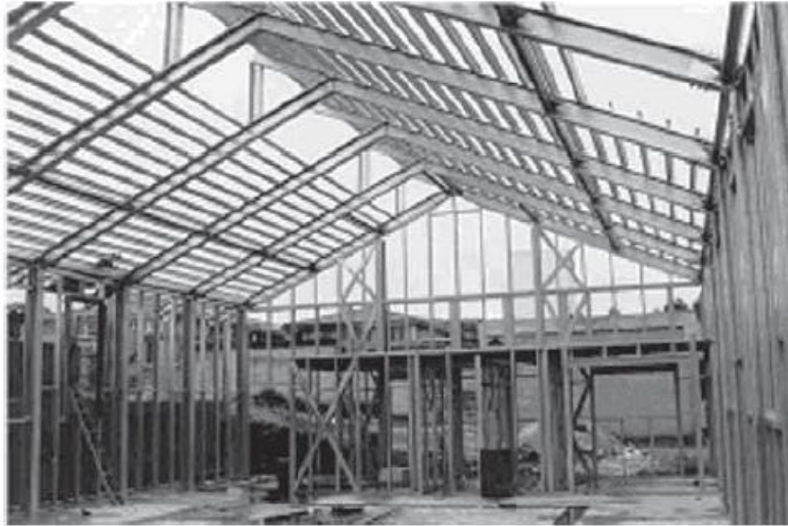
Figura 28: Telhado estruturado com caibros em um Laboratório na Universidade Federal de Ouro Preto– MG
