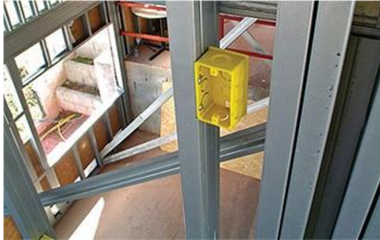
Figura 23: Caixa de luz fixada em montante
