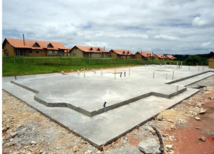
Figura 5: Fundação em radier
