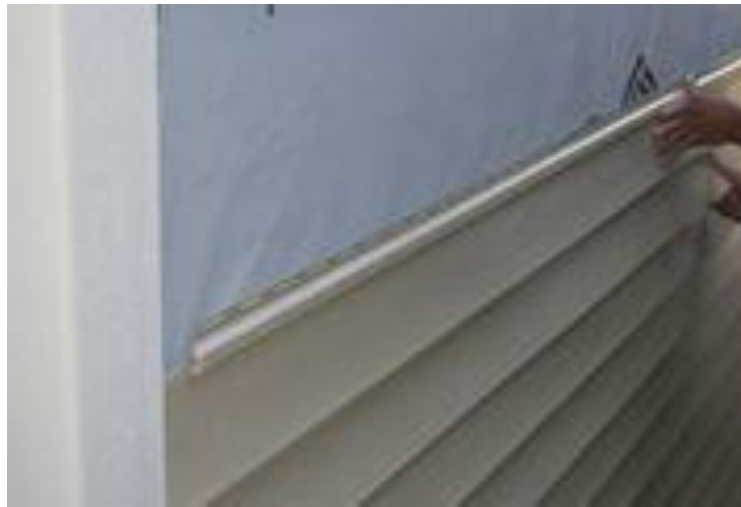
Figura 14: Aplicação de siding vinílico como revestimento externo
