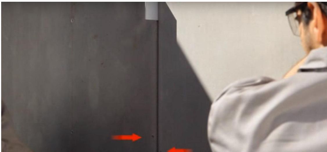
Figura 19: Aplicação de junta de dilatação entre placas cimentícias
