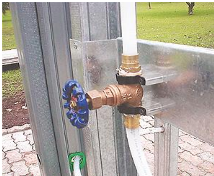
Figura 20: Registro fixado em peça auxiliar
