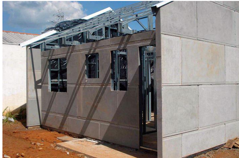
Figura 17: Casas populares com placas cimentícias
