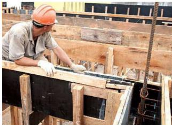
FIGURA 15 – Nivelamento das tábuas
