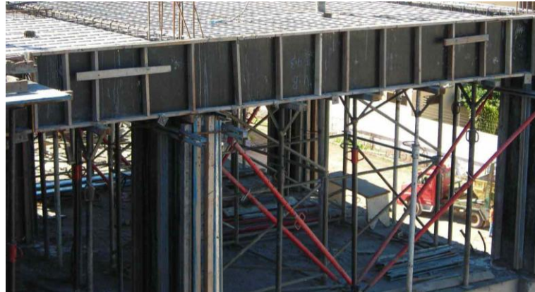
FIGURA 5 - Montagem de fôrmas de laje maciça
