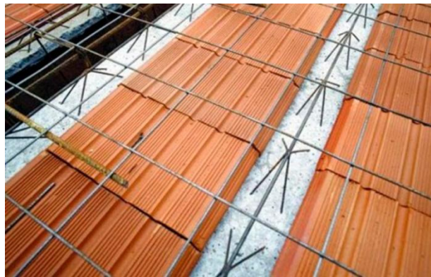
FIGURA 12 - Laje com enchimento cerâmico
