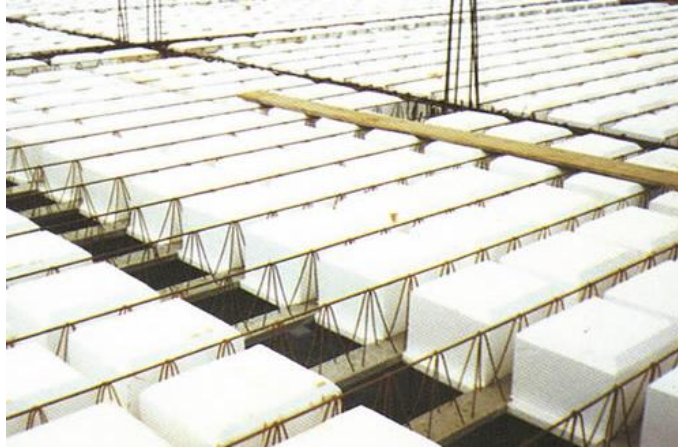
FIGURA 8 - Laje nervurada treliçada com enchimento de EPS
