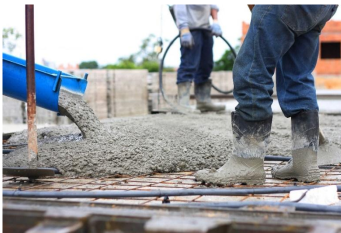
FIGURA 6 - Concretagem laje maciça
