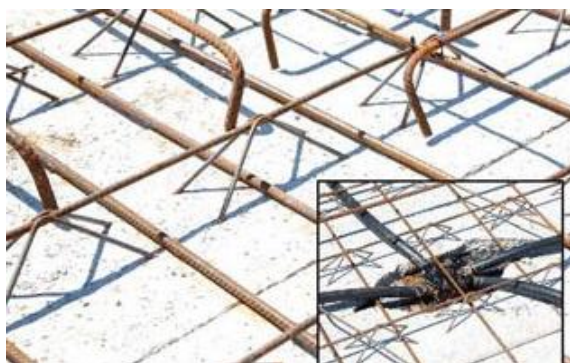
FIGURA 16 – Colocação das vigotas e armaduras positivas e negativas
