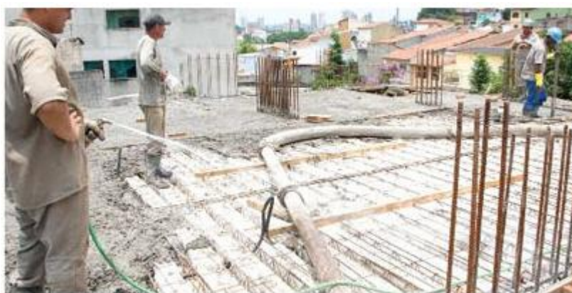
FIGURA 18 - Lançamento do concreto
