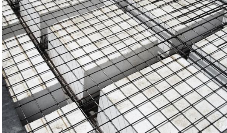
FIGURA 11 - Laje com enchimento de EPS
