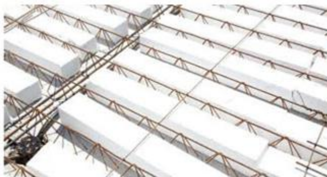
FIGURA 17 - Colocação dos EPS
