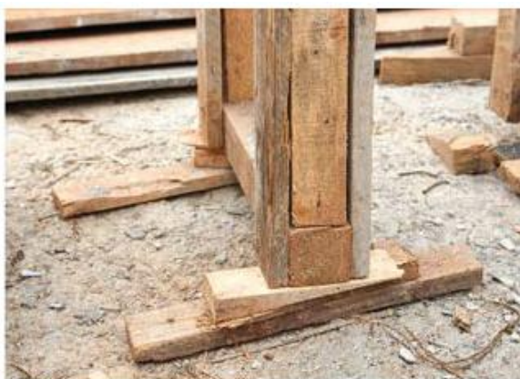
FIGURA 14 – Colocação das escoras
