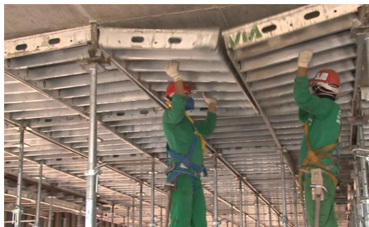
FIGURA 7 - Retirada das fôrmas
