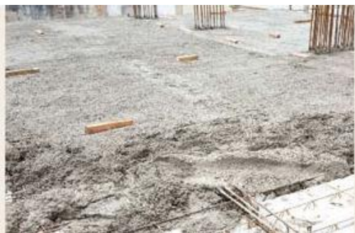
FIGURA 19 - Sarrafeamento e nivelamento do concreto seguindo a altura das taliscas
