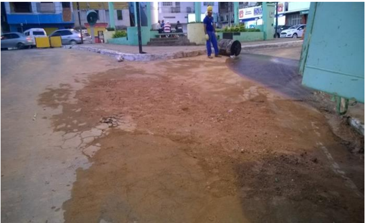
Foto 4 – Aterro executado, faltando somente a pavimentação asfáltica.
