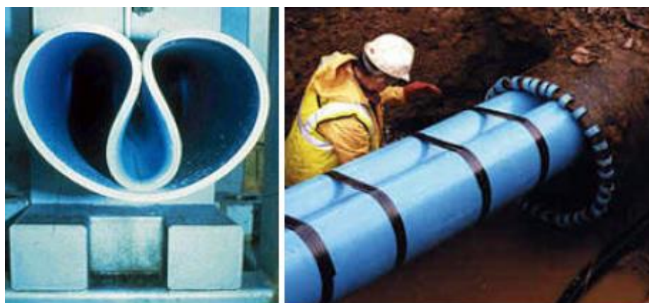
Figura 9: Apresentação do tubo de polietileno dobrado em forma de coração, e o processo de inserção com tubo de parede dobrada.
