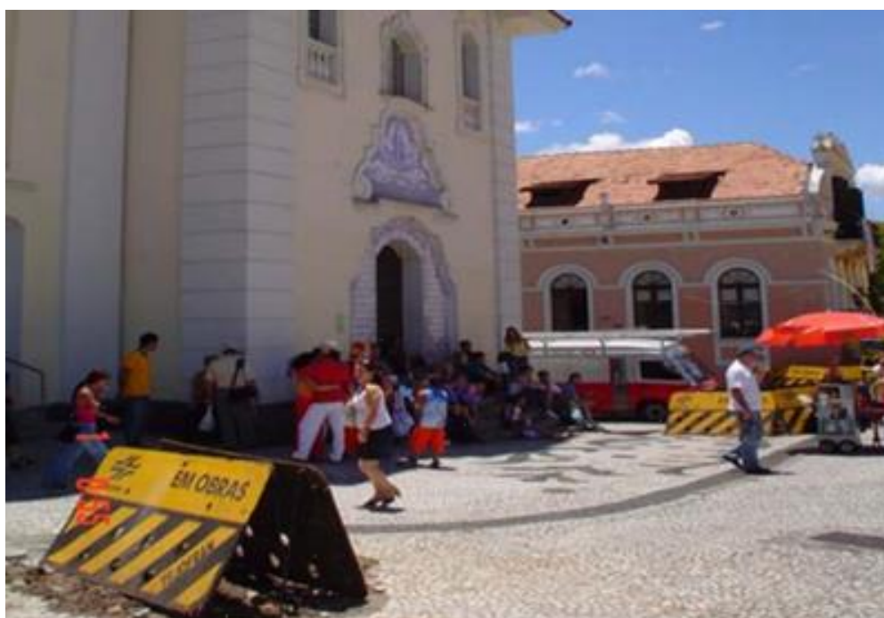
Figura 3: Obra de substituição de rede pelo método não destrutivo. Fonte: ANTUNES, 2006.
