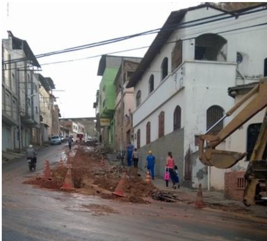
Figura 15: Substituição de rede de água na rua Professor Olinto, método destrutivo. Fonte: Arquivo pessoal.
