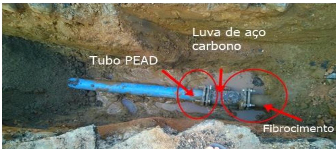
Figura 13: Local de manutenção de uma rede de fibrocimento. Fonte: Arquivo pessoal.
