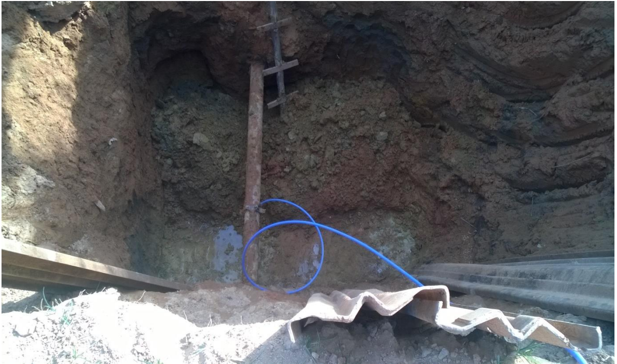
Foto 1 – Rede de água DN 150, após executada a manutenção.
