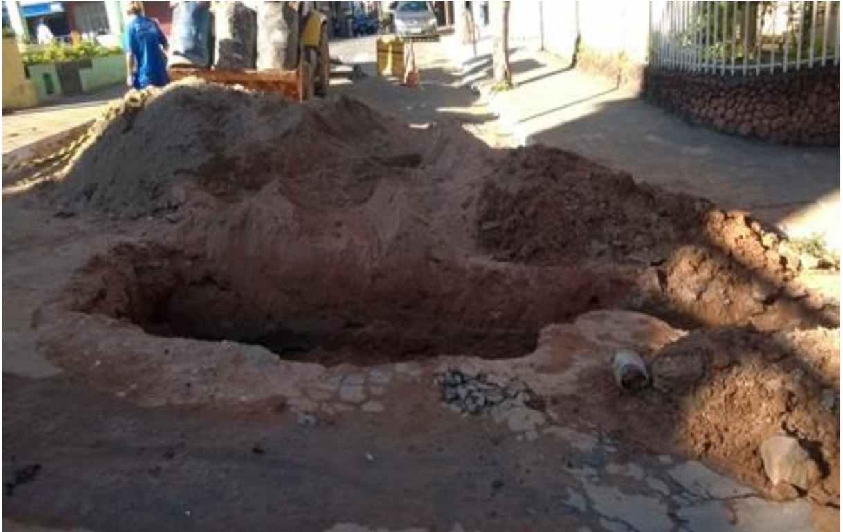
Foto 1 – Vala onde foi executado manutenção na rede de fibrocimento.
