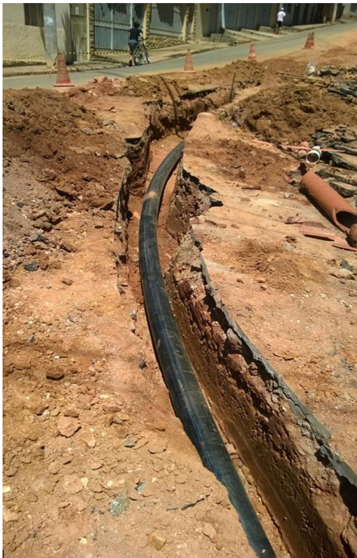
Figura 16: Tubo de Polietileno com curvatura devido ao traçado da rede. Fonte: Arquivo pessoal.
