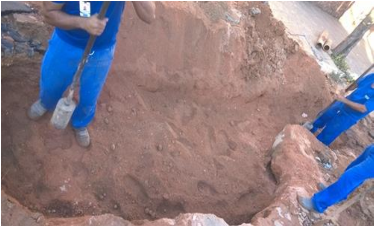
Foto 3 – Compactação executada manualmente.
