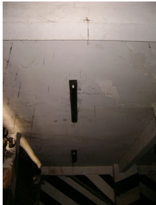
Laje L1 – pavimento térreo.
