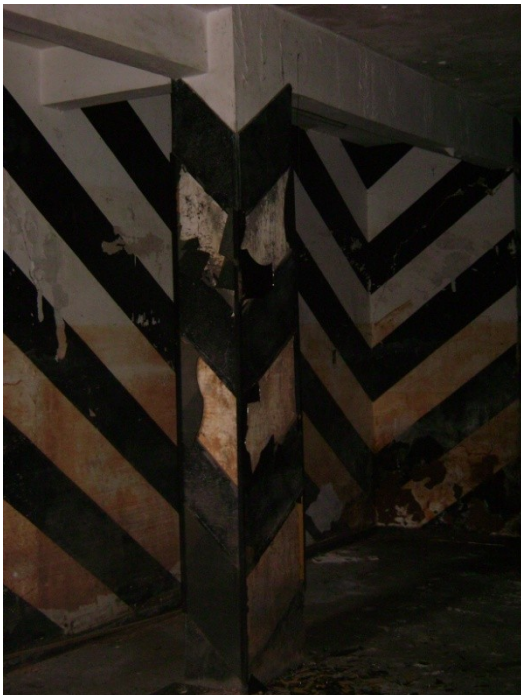
Pilar P14 – pavimento térreo.
