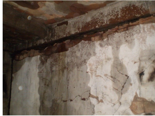
Vigas do 3º pavimento.
