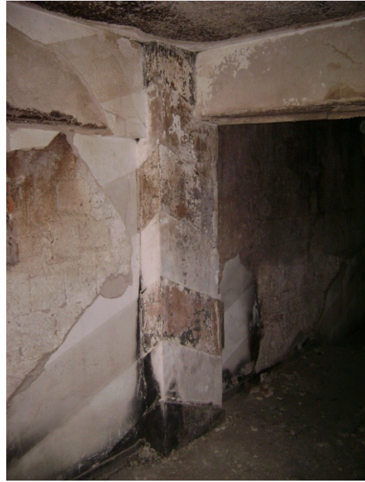
Pilar P24 – 1º pavimento.
