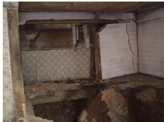
Vigas do 3º pavimento.
