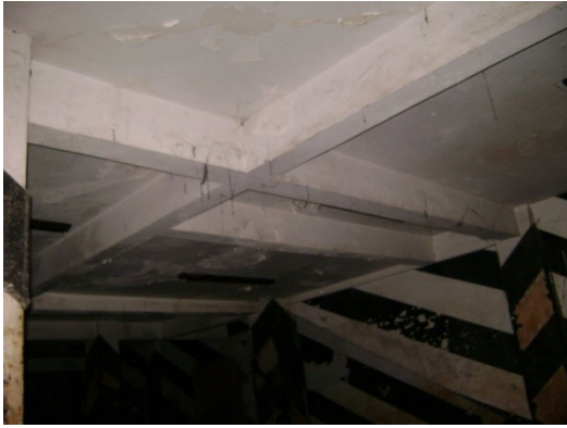
Vigas do pavimento térreo.
