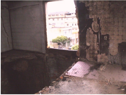
Vigas do 3º pavimento.
