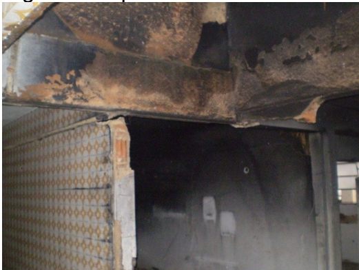
Vigas do 3º pavimento.
