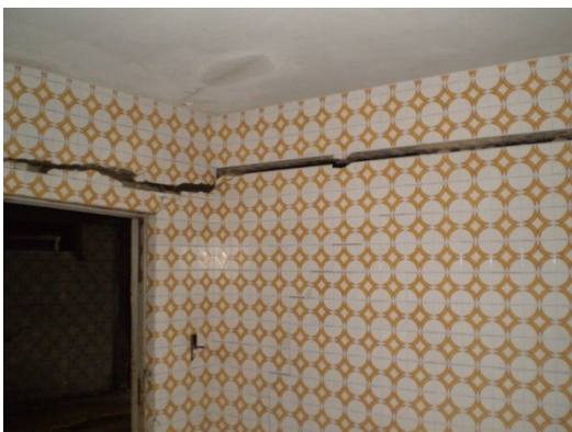
Vigas do 3º pavimento.
