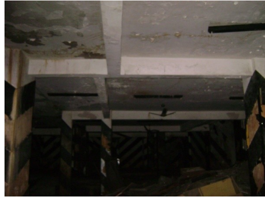
Vigas do pavimento térreo.
