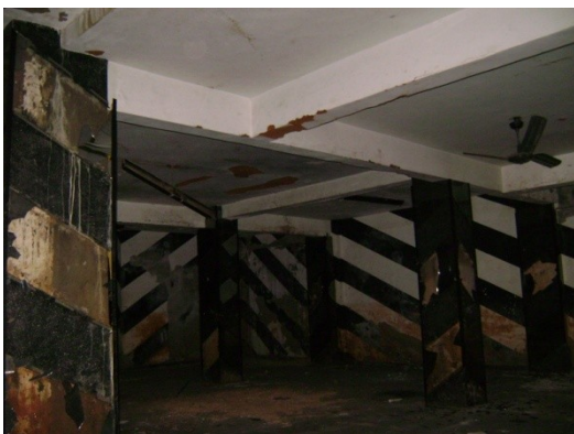
Vigas do pavimento térreo.
