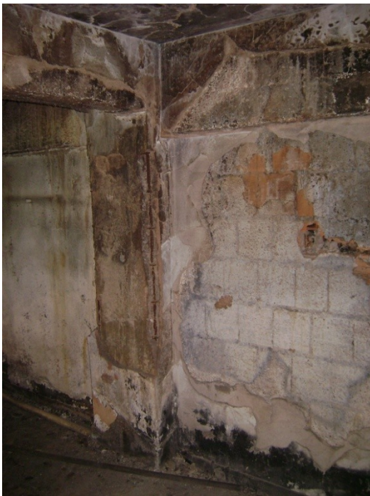
Pilar P13 – 1º pavimento.
