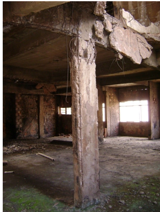
Pilar P14 – 2º pavimento.
