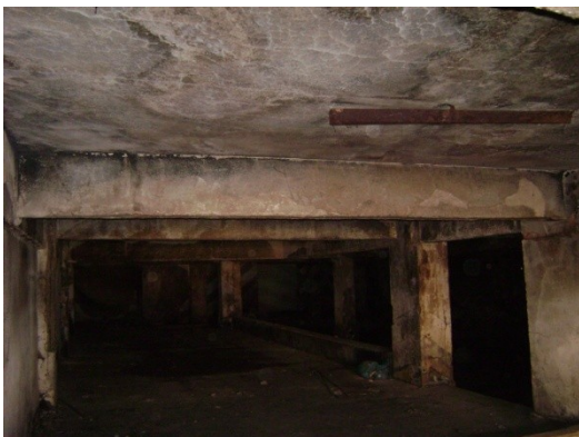
Vigas do 1º pavimento.
