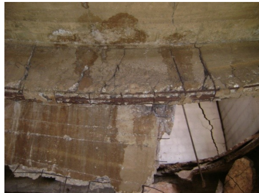
Vigas do 2º pavimento.
