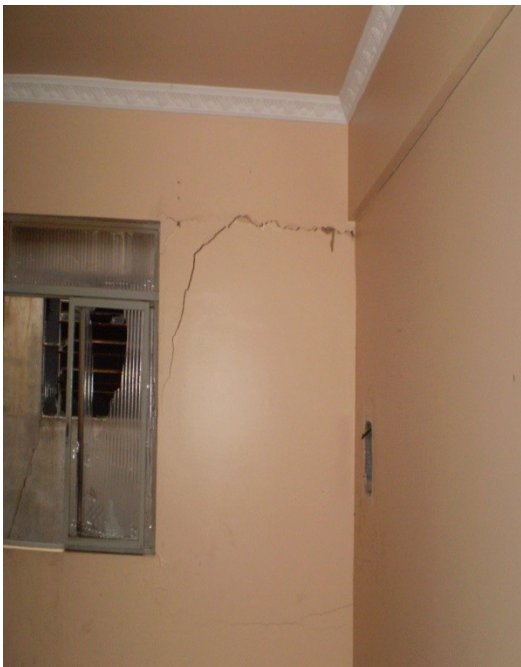
Vigas do 4º pavimento.
