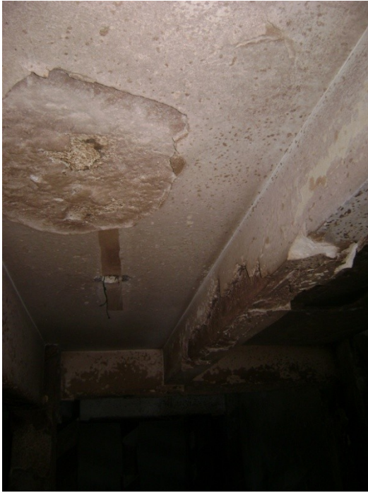
Laje L17 – 1º pavimento.
