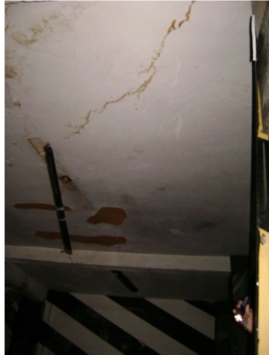
Laje L15 – pavimento térreo.
