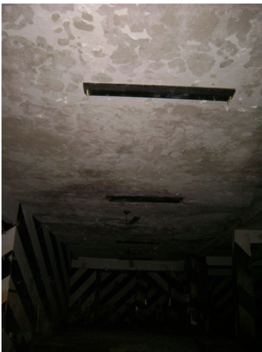
Laje L12 – pavimento térreo.
