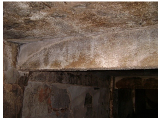
Vigas do 1º pavimento.
