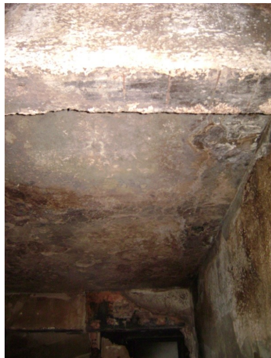
Laje L6 – 1º pavimento.
