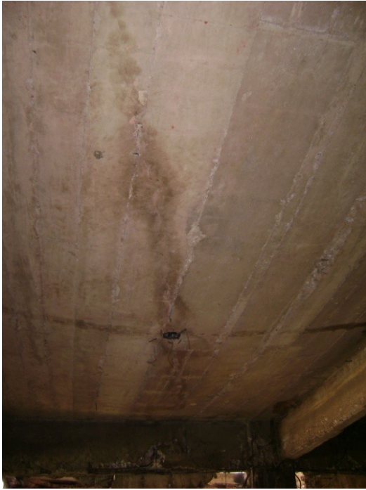
Laje L9 - 2º pavimento.
