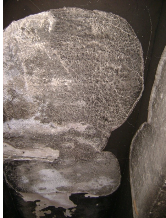
Laje L1 – 1º pavimento.
