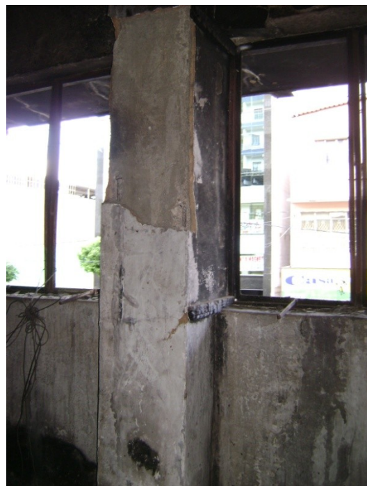
Pilar P2 – 1º pavimento.
