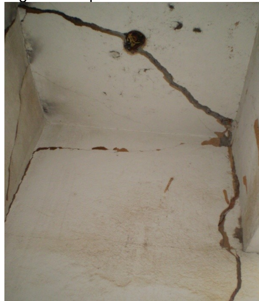
lajes do 3º pavimento.
