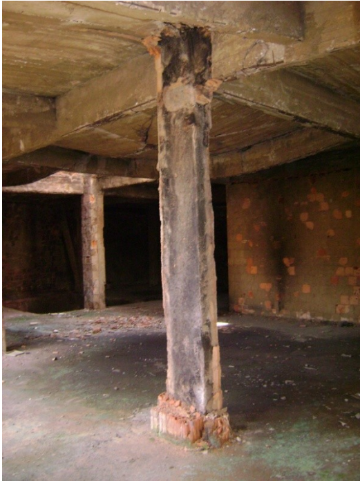
Pilar P19 – 2º pavimento.
