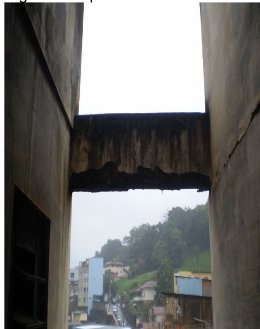
Vigas do 4º pavimento.
