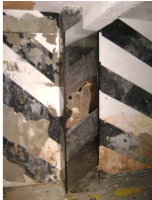
Pilar P32 – pavimento térreo.
