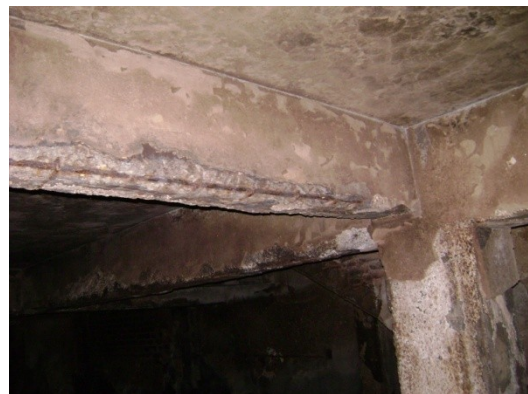
Vigas do 1º pavimento.
