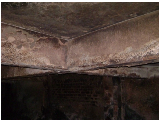
Vigas do 1º pavimento.
