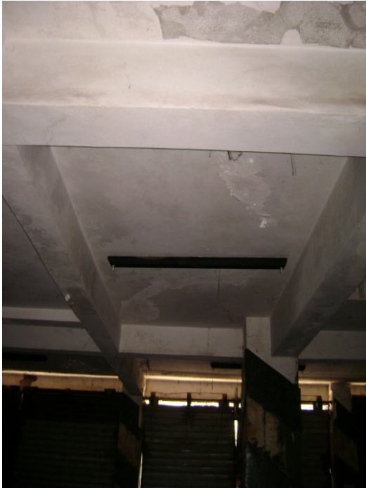
Laje L5 – pavimento térreo.
