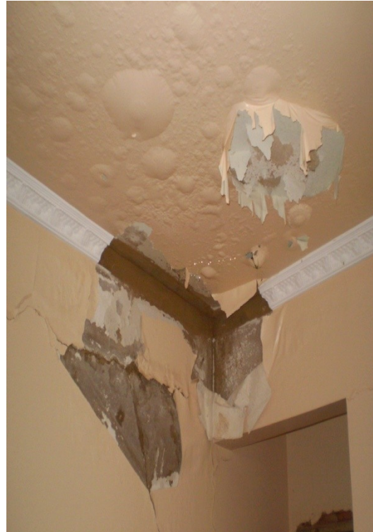
Vigas do 4º pavimento.
