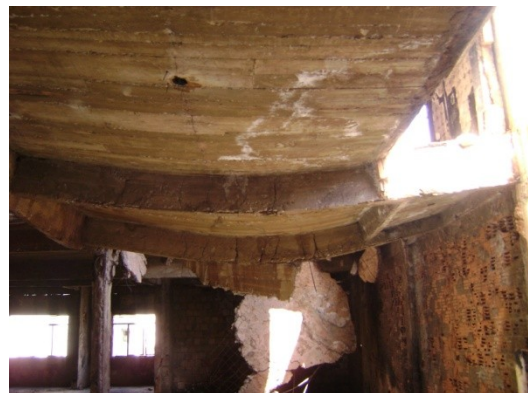
Vigas do 2º pavimento.
