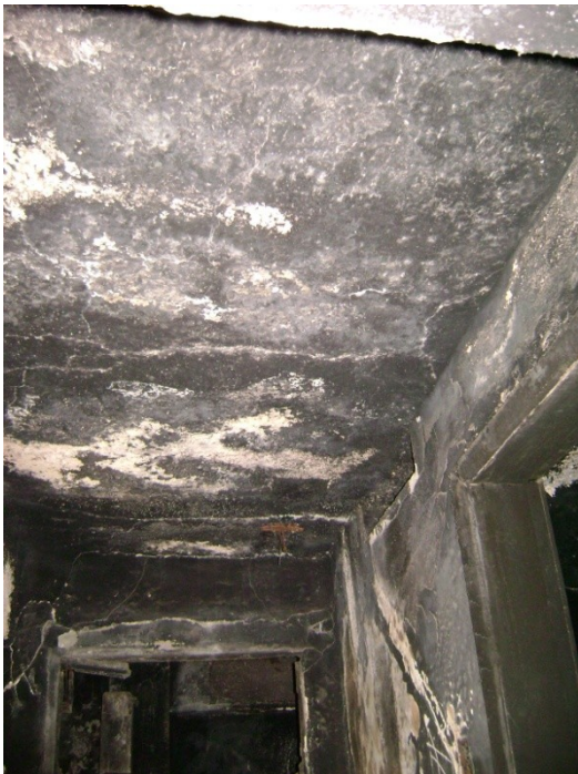
Laje L24 – 1º pavimento.
