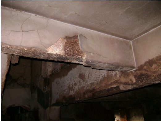
Vigas do 1º pavimento.
