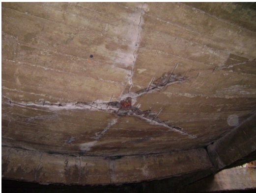
Laje L20 - 2º pavimento.
