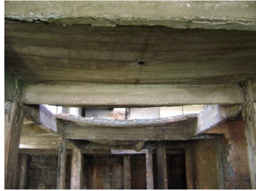
Vigas do 2º pavimento.
