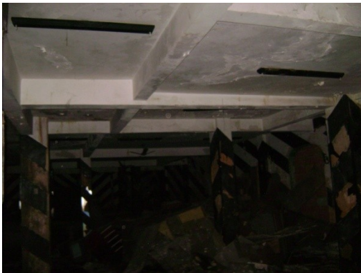
Vigas do pavimento térreo.
