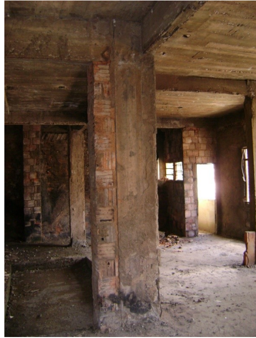
Pilar P7 – 2º pavimento.
