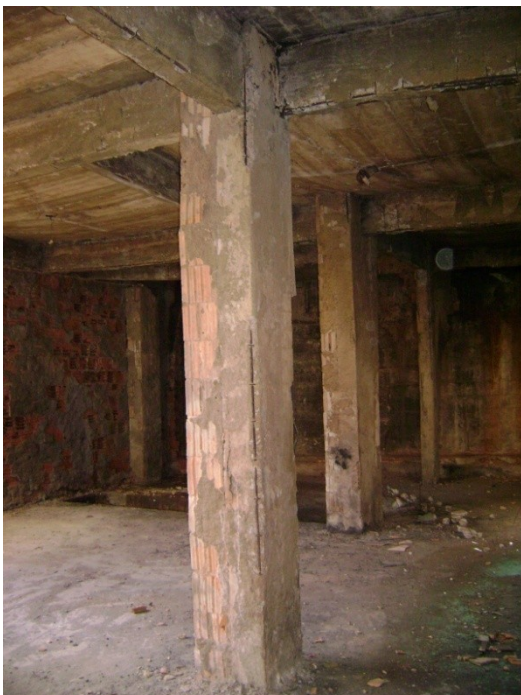
Pilar P24 – 2º pavimento.
