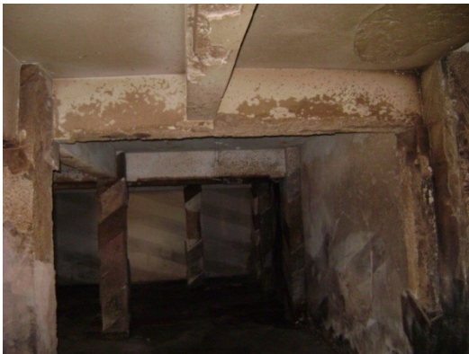
Vigas do 1º pavimento.
