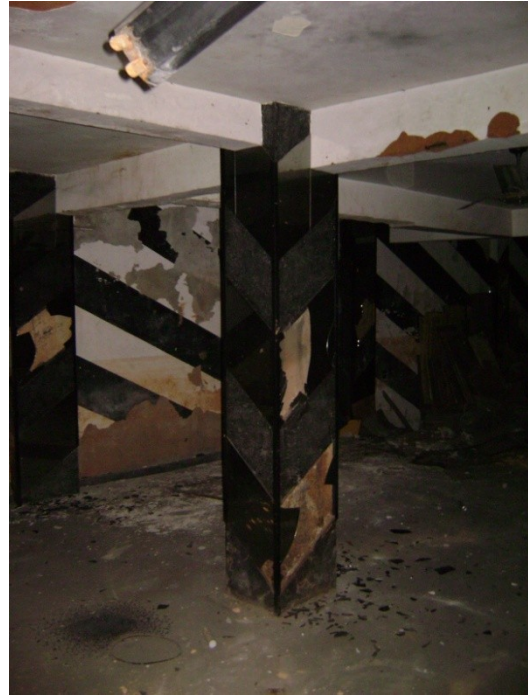
Pilar P26 – pavimento térreo.
