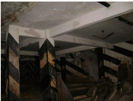
Vigas do pavimento térreo.
