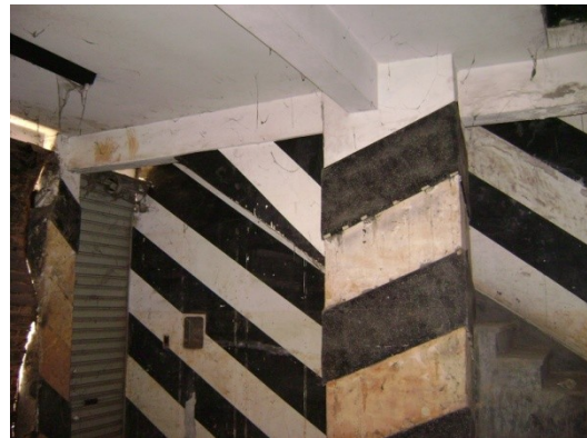
Vigas do pavimento térreo.
