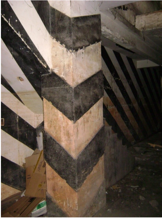
Pilar P6 – pavimento térreo.
