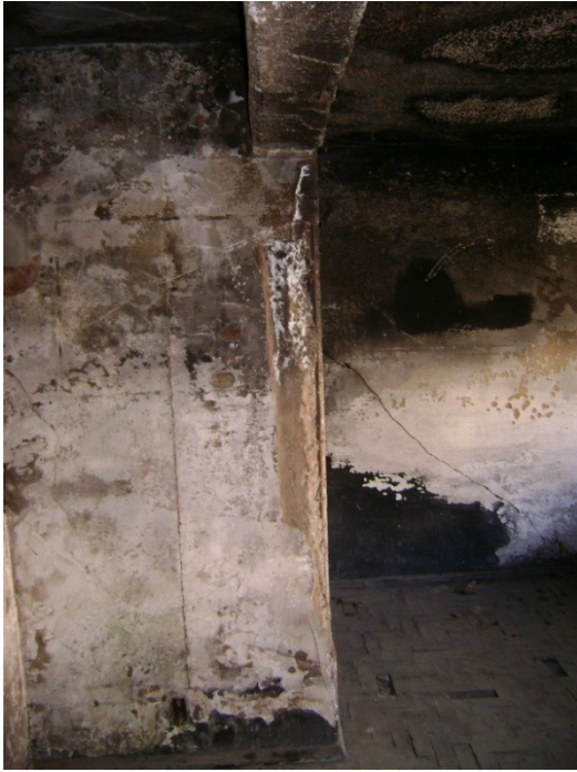
Pilar P7 – 1º pavimento.
