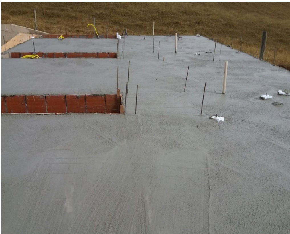
Foto 5 - laje concretada
