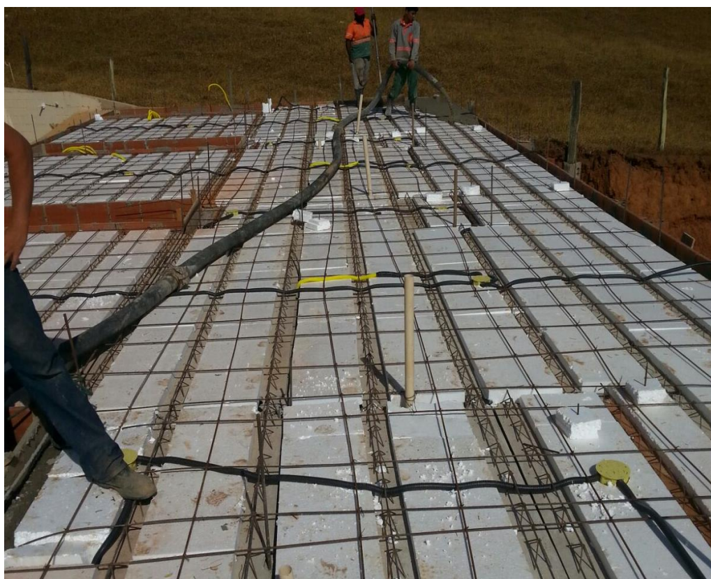
Foto 4 - Concretagem da laje treliçada
