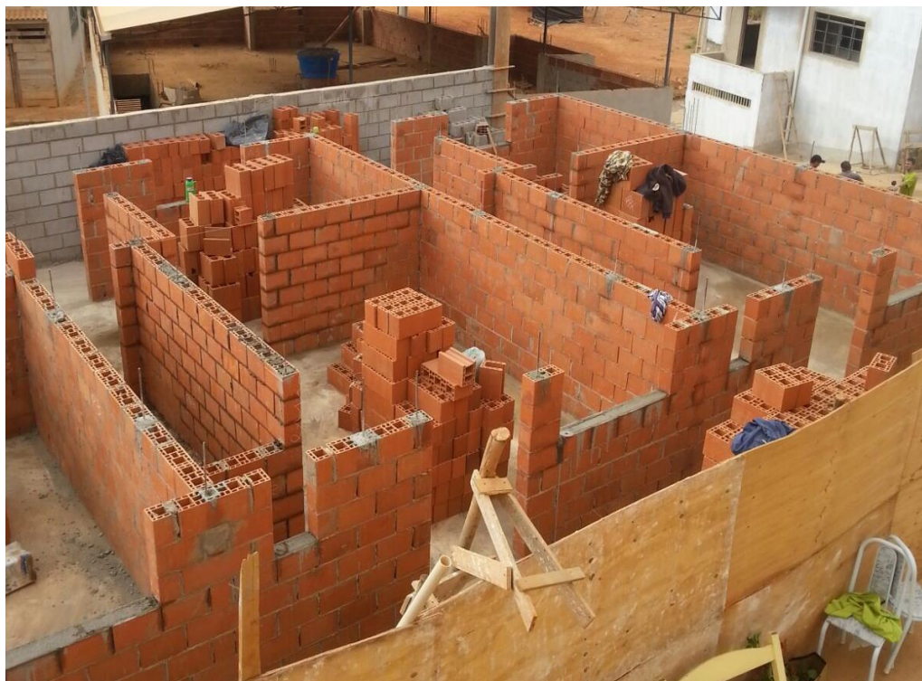
Foto 1 - Grauteamento e preenchimento das contravergas
