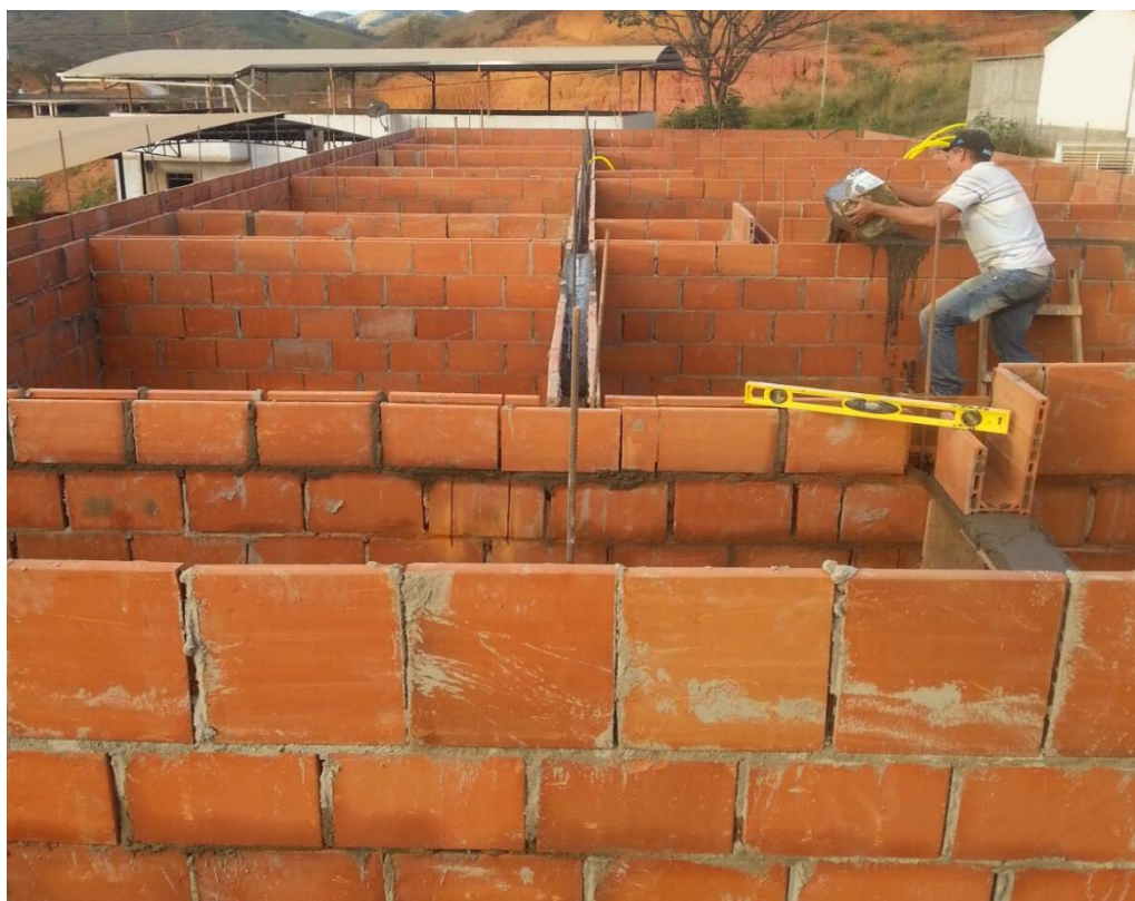
Foto 4 - Preenchimento dos blocos tipo canaleta
