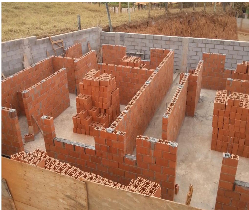
Foto 2 - Grauteamento e preenchimento das contravergas
