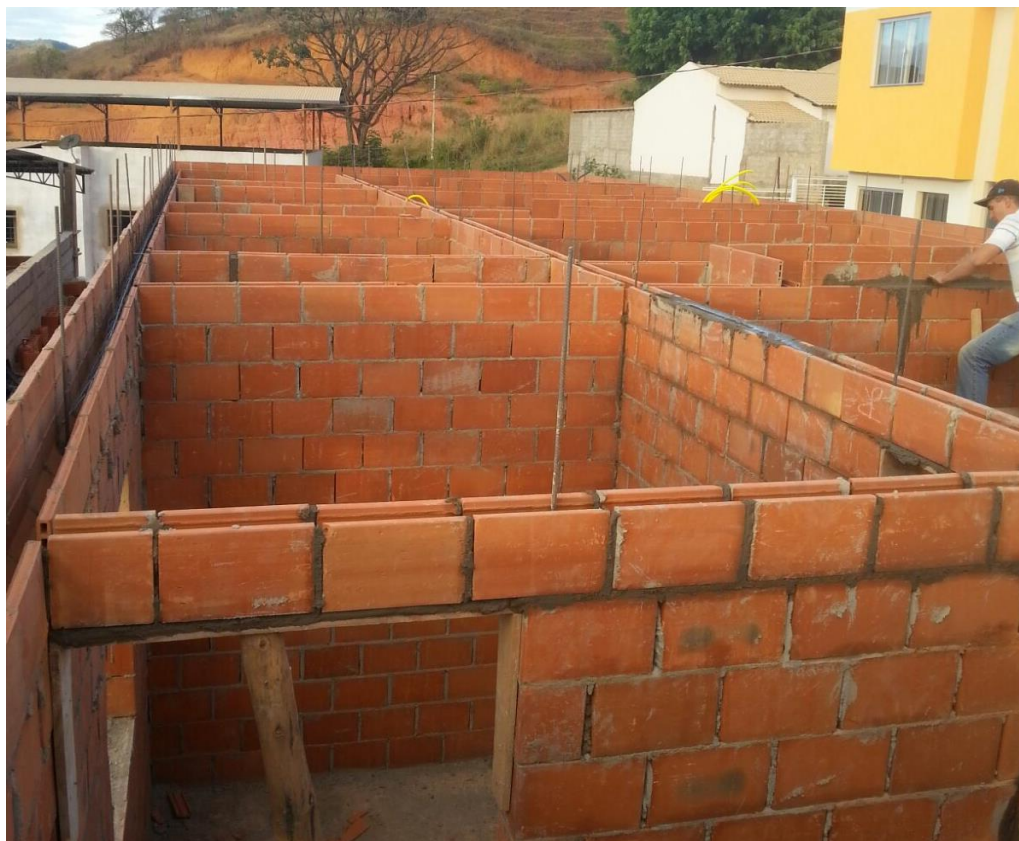
Foto 3 - Uso do bloco tipo canaleta para executar o coxim
