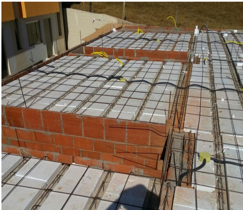
Foto 5 - Montagem da laje treliçada utilizando o bloco canaleta “J”
