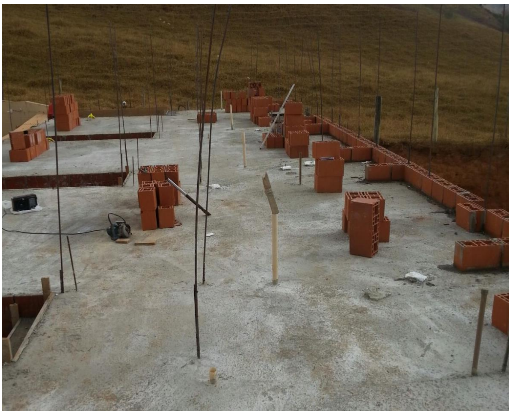
Foto 6 - Alocação da primeira fiada dos blocos cerâmicos estruturais
