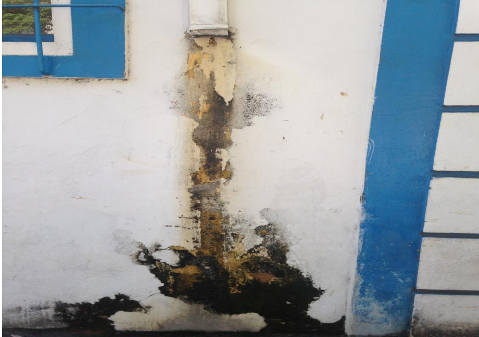
Figura 09 – Infiltração por condensação
