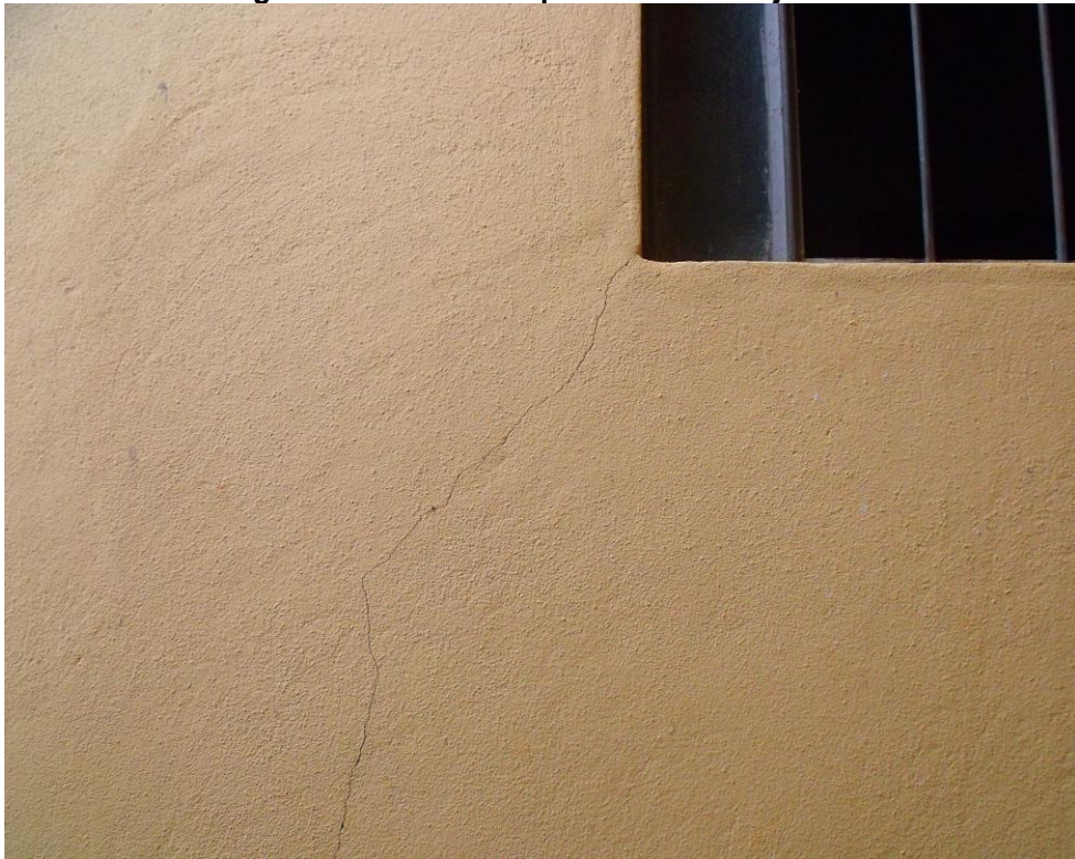
Figura 10 – Fissura na parte inferior da janela
