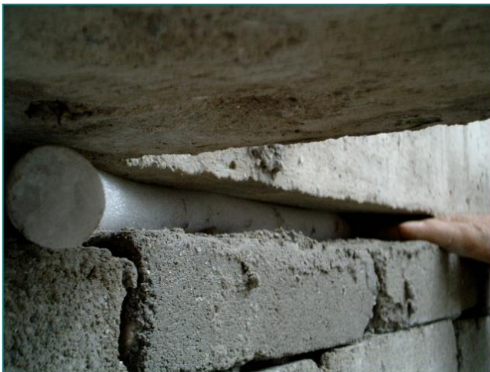
Figura-11 Uso de material flexível no encunhamento
