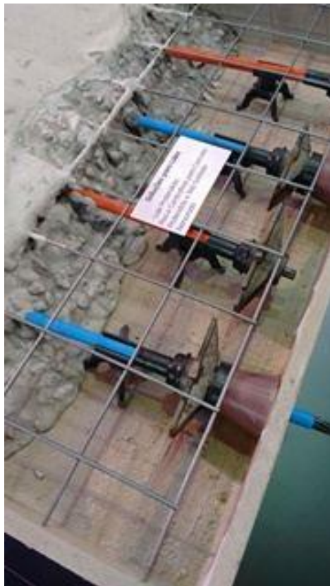
Figura-01 Exemplo de concretagem de uma laje
