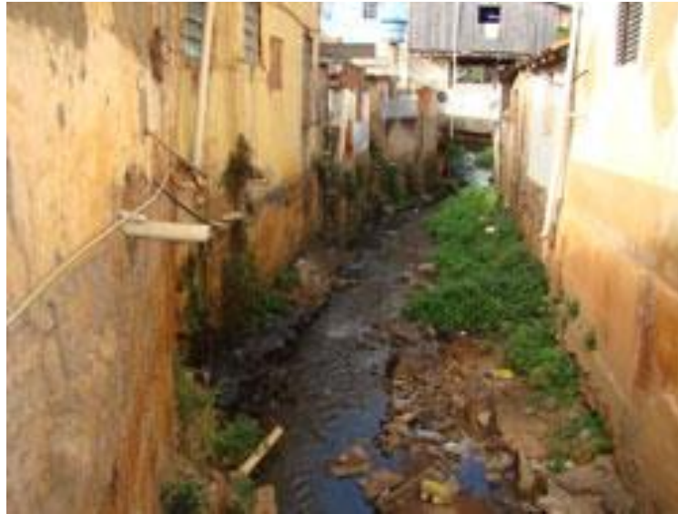
Figura 5: Lançamento de esgoto direto no rio
