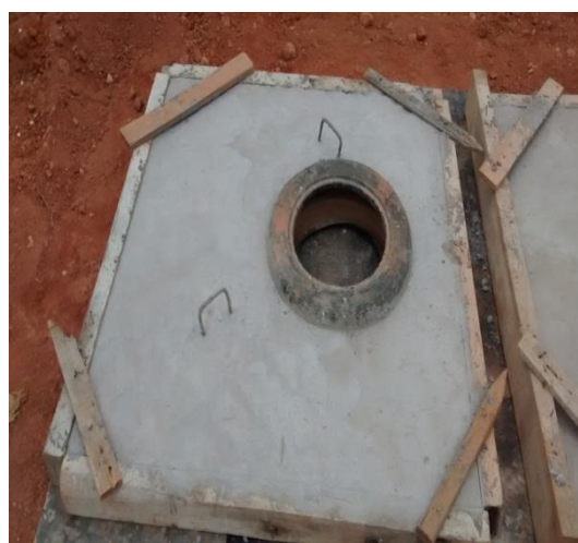
Figura 63 - Laje de transição concretada na forma. Fonte: Acervo dos autores.
