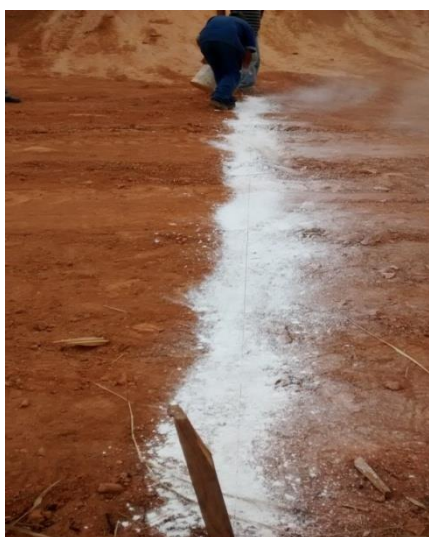
Figura 19 - Marcação da rede em um loteamento. Fonte: Acervo dos autores.
