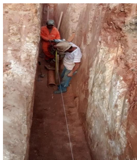
Figura 33 - Método do ELI - aferição do nível da tubulação no interior da vala. Fonte: Acervo dos autores.
