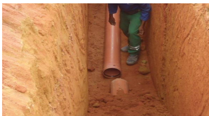
Figura 44 - Processo executivo das juntas a partir do encaixe da ponta e bolsa do tubo em um loteamento. Fonte: Colina do Campo, 2013.
