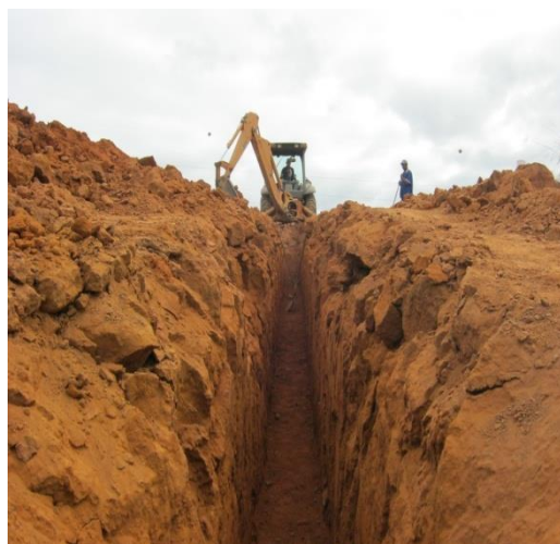
Figura 22 - Escavação a céu aberto com auxílio de retro escavadeira. Fonte: Acervo dos autores.
