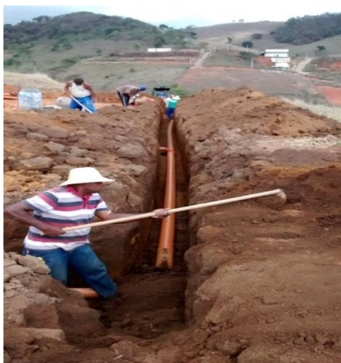
Figura 79 - Reaterro da tubulação de esgotamento e compactação manual em rede de loteamento. Fonte: Acervo dos autores.
