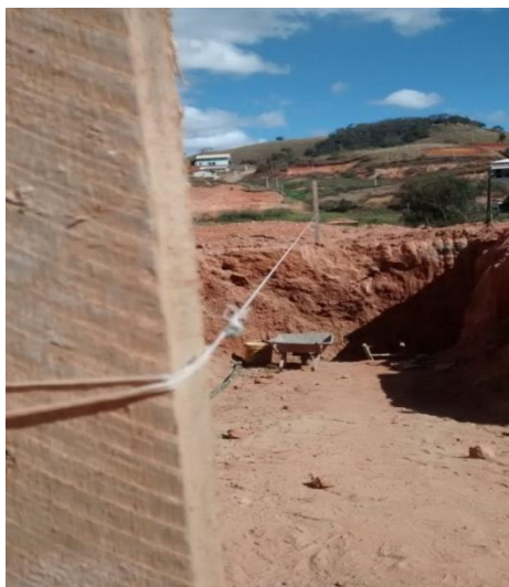
Figura 31 - Método do ELI - nivelamento pelo logradouro. Fonte: Acervo dos autores.
