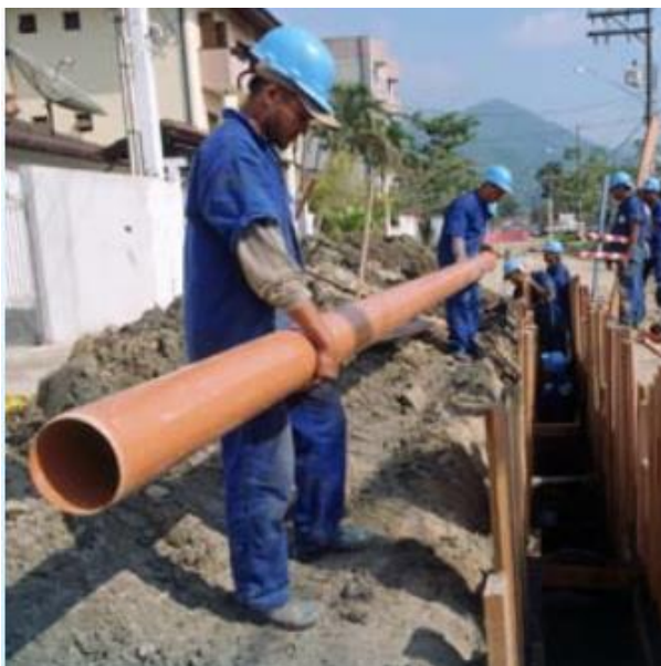
Figura 23 - Escoramento tipo pontaleteamento em rede de esgotamento em loteamento. Fonte: SABESP, 2014.
