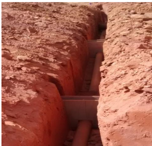
Figura 48 - Ancoragem em placas de concreto armado moldada in loco . Fonte: Acervo dos autores.
