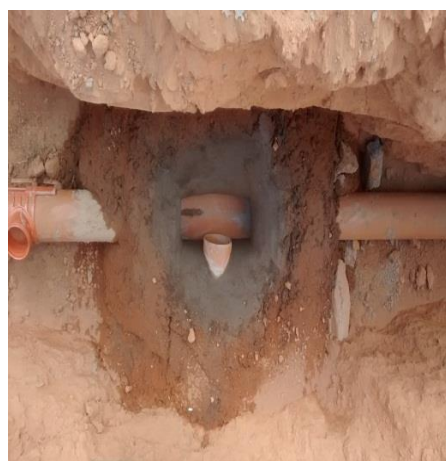
Figura 58 - Poço de Visita in loco com uma contribuição e passagem reta. Fonte: Acervo dos autores.
