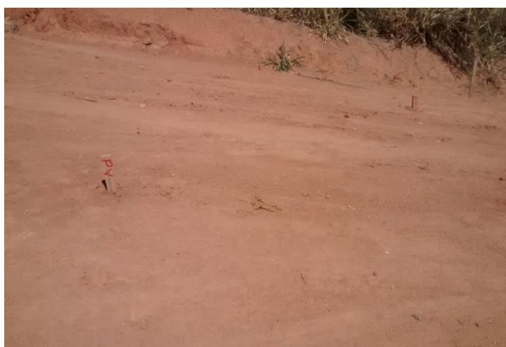
Figura 17 - Sinalização da marcação dos PV's. Fonte: Acervo dos autores.
