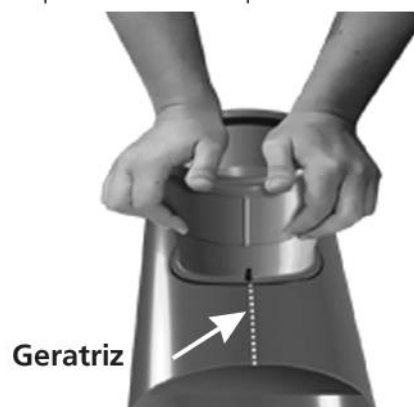
Figura 72 - Posicionamento do selim no coletor sanitário. Fonte: TIGRE, 2013.
