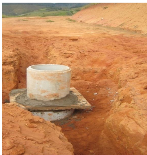
Figura 59 - Poço de Visita com balão e chaminé em um loteamento. Fonte: Acervo dos autores.
