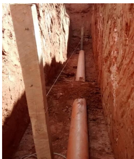
Figura 32 - Método do ELI - nivelamento no interior da vala. Fonte: Acervo dos autores.
