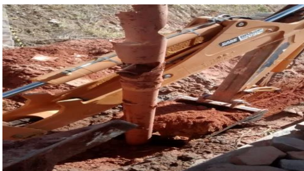
Figura 39 - Trecho de rede onde ocorreu a inserção de elementos inertes a instalação. Fonte: Acervo dos autores.
