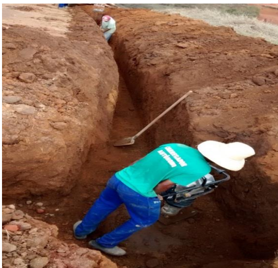
Figura 54 - Compactação do berço com equipamento de percussão. Fonte: Acervo dos autores.
