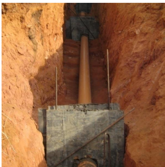
Figura 49 - Posicionamento da armadura nas fôrmas para a concretagem das ancoragens. Fonte: Acervo dos autores.
