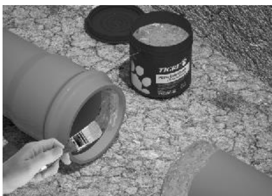
Figura 42 - Processo executivo das juntas. Fonte: TIGRE, 2013.
