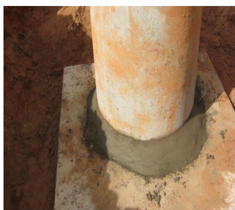
Figura 60 - Poço de Visita com balão e chaminé in loco em um loteamento Fonte: Acervo dos autores.
