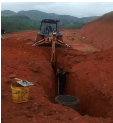
Figura 21 - Escavação a céu aberto com auxílio de retro escavadeira. Fonte: Acervo dos autores.
