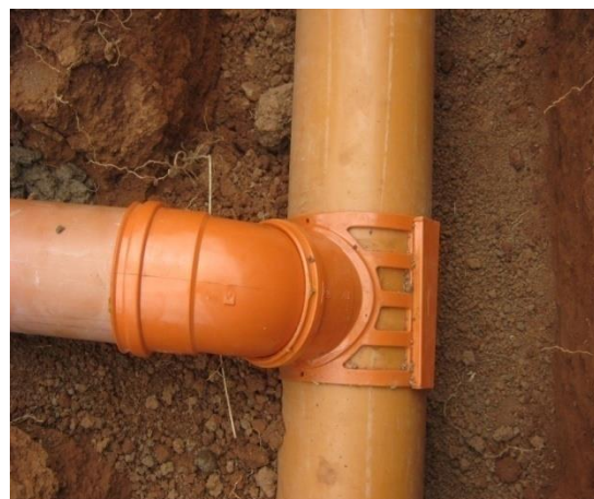
Figura 74 - Coletor com ligação predial com selim e curva em um loteamento. Fonte: Acervo dos autores.
