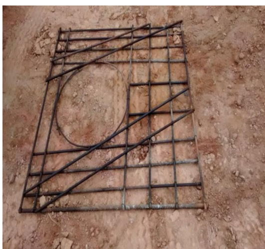
Figura 62 - Armadura da laje de transição. Fonte: Acervo dos autores.
