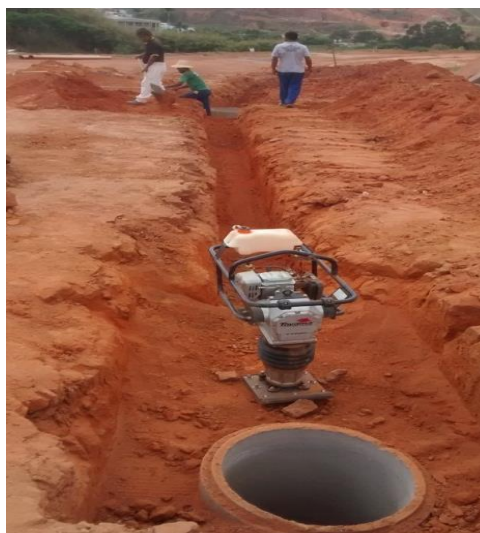
Figura 81 - Compactação da vala utilizando compactador de percussão. Fonte: Acervo dos autores.
