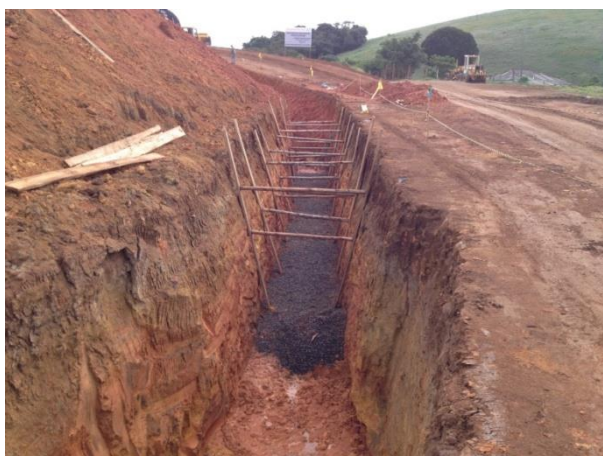
Figura 34 - Instalação de rede em loteamento com lastro de brita e com escoramento tipo pontaleamento.
