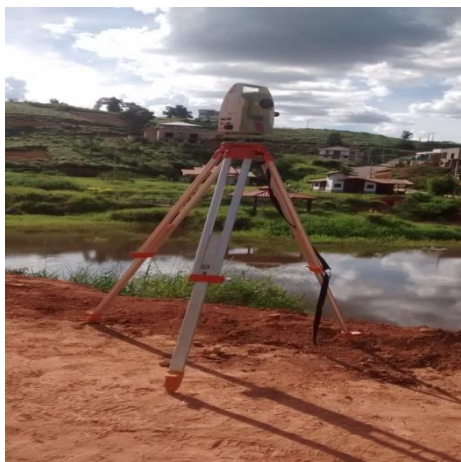
Figura 16 - Equipamento topográfico Estação Total Fonte: Acervo dos autores.
