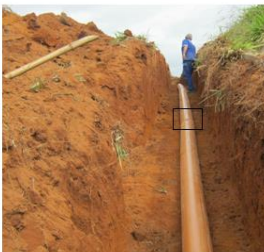
Figura 38 - Material hidráulico de coleta sanitária sendo alocado nos devidos trechos aptos a instalação da rede com a junta marcada com linha de náilon vermelha. Fonte: Acervo dos autores.
