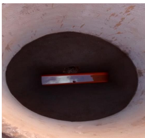
Figura 45 - Teste de estanqueidade dentro de um PV em uma rede sanitária em um loteamento. Fonte: Acervo dos autores.
