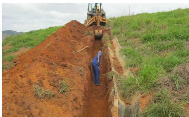
Figura 28 - Regularização manual do berço. Fonte: Acervo dos autores.
