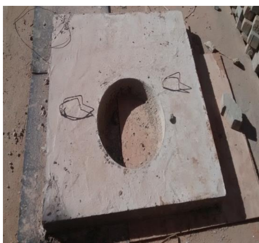
Figura 64 - Laje de transição pronta para ser utilizada em um PV com balão e chaminé. Fonte: Acervo dos autores.
