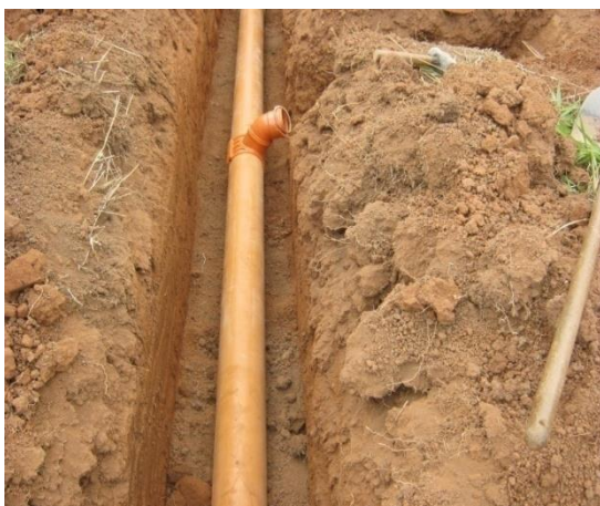
Figura 73 - Coletor com selim e curva em um loteamento pronto para a ligação predial. Fonte: Acervo dos autores.
