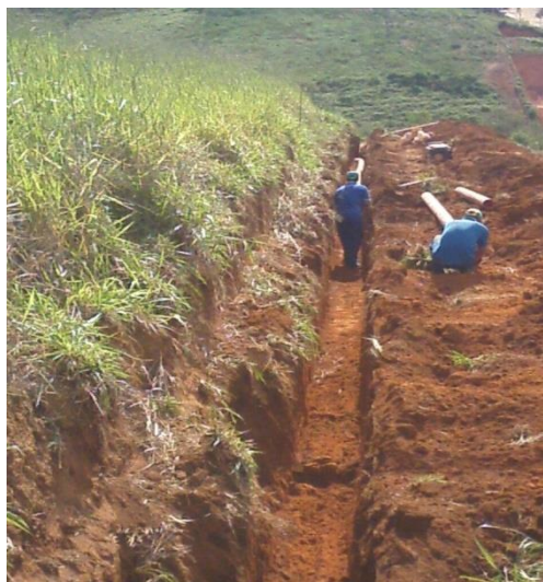
Figura 37 - Material hidráulico de coleta sanitária sendo alocado nos trechos aptos a instalação da rede.
