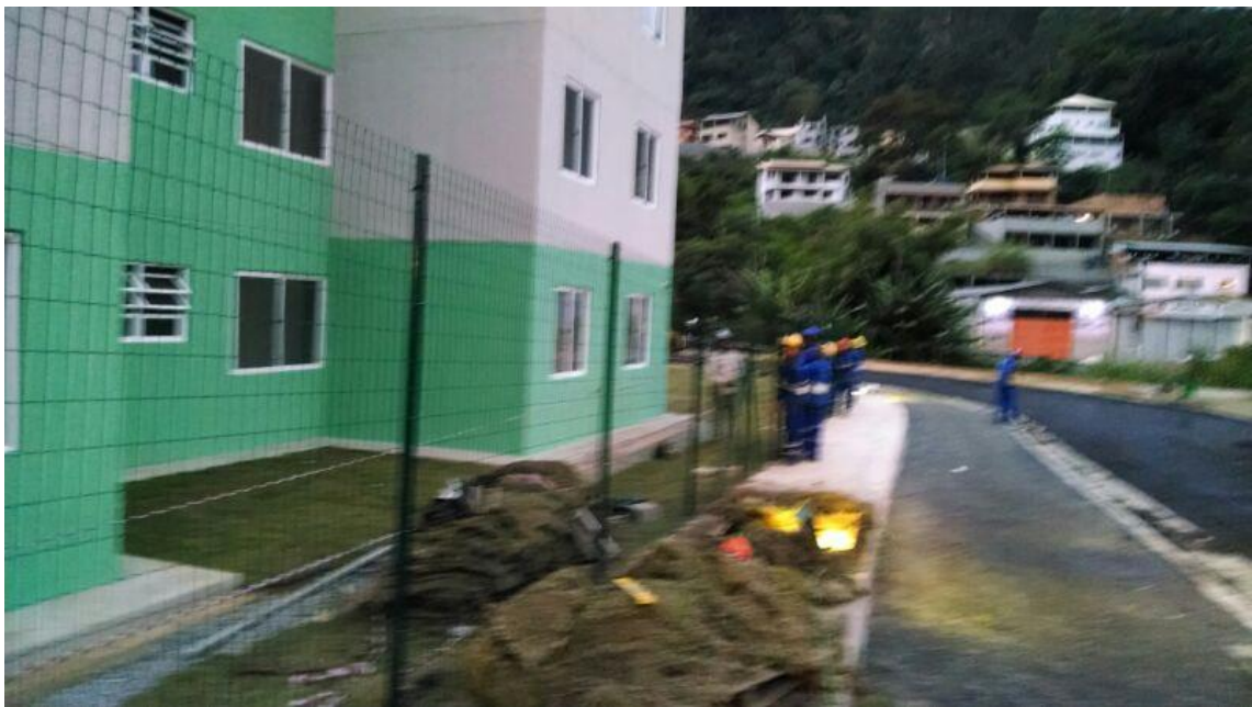
Figura 30: Local onde foi realizado o aterro estaqueado.
