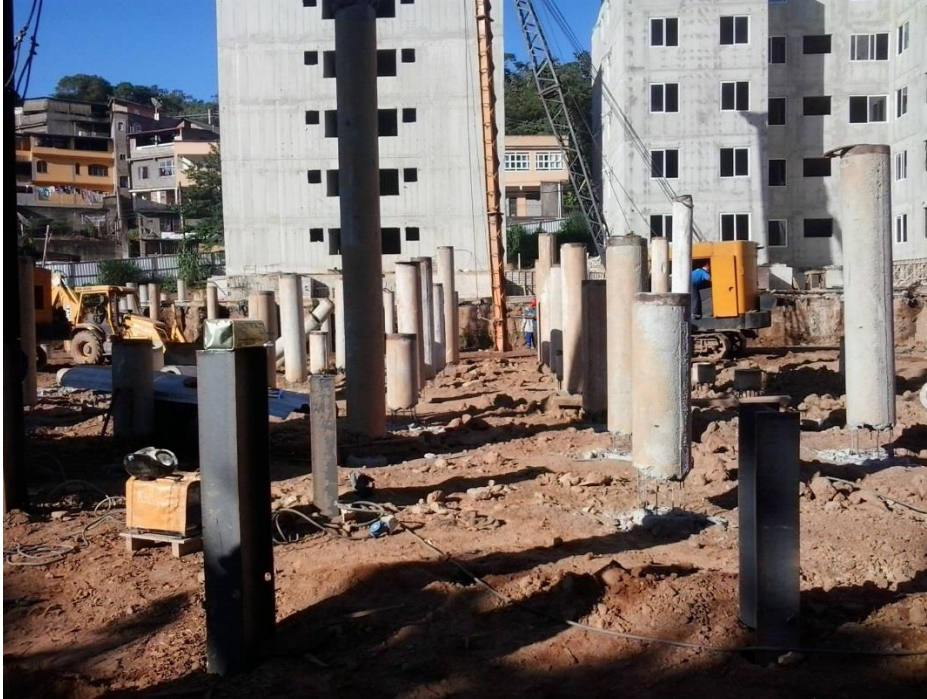
Figura 23: Cravação de Estacas.
