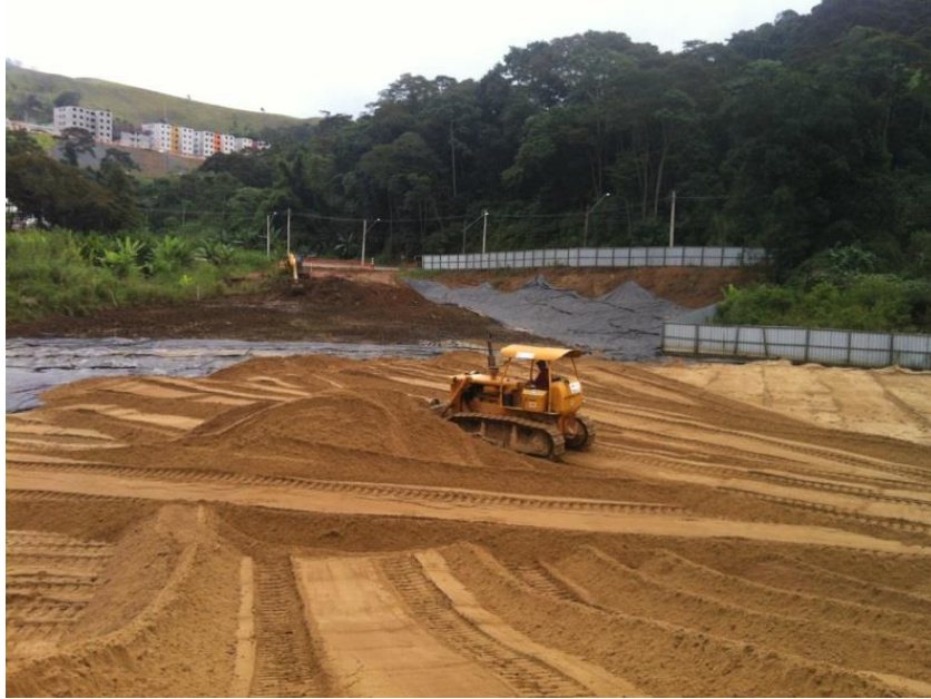
Figura 21: Execução do Aterro de Conquista.
