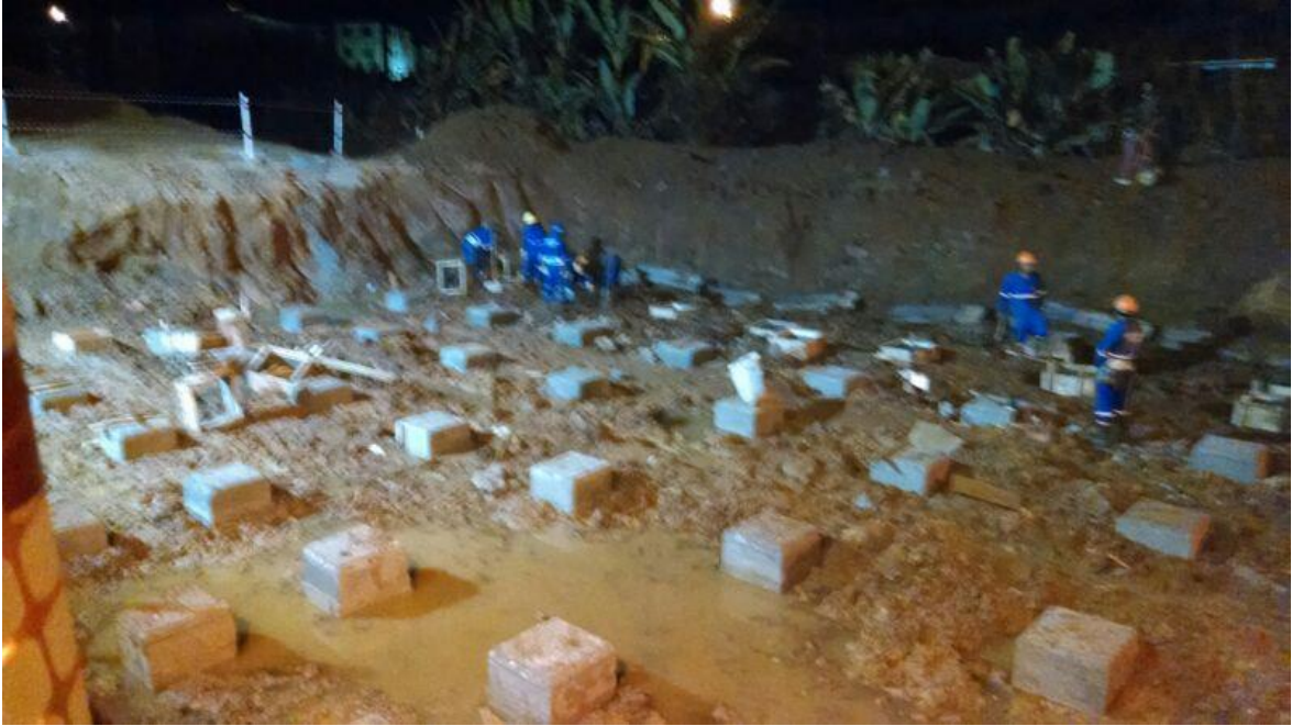
Figura 25: Execução de Capitéis.
