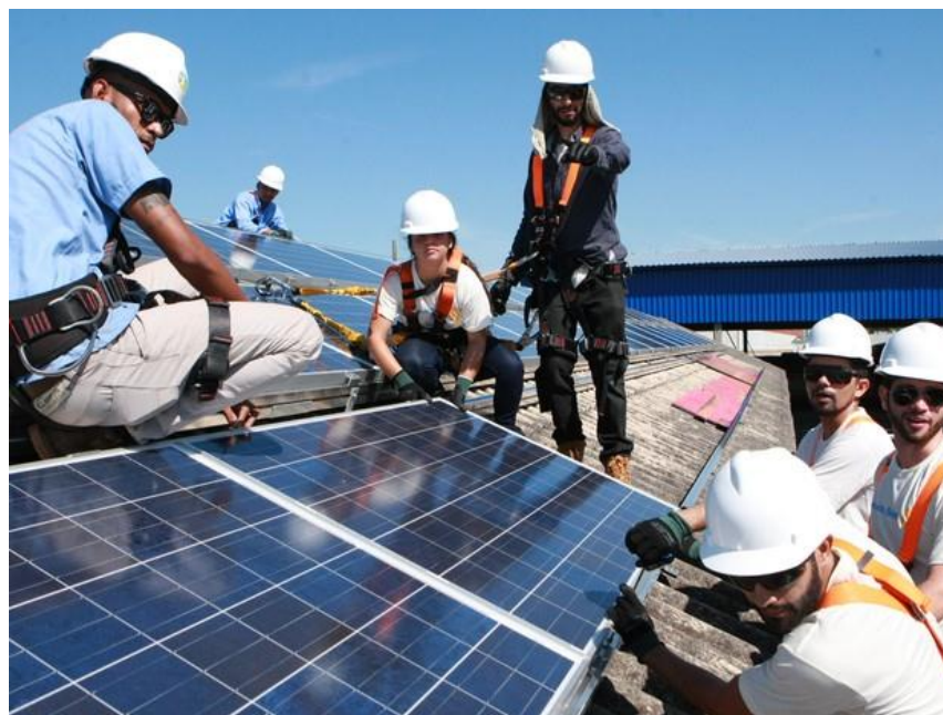
Figura 3: Instalação de painel fotovoltaico
