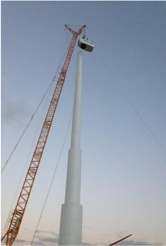
Fotos 5 e 6 – Colocando a nacele
