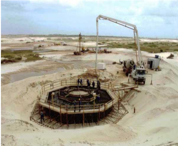
Figura 19.2 – Concretagem
