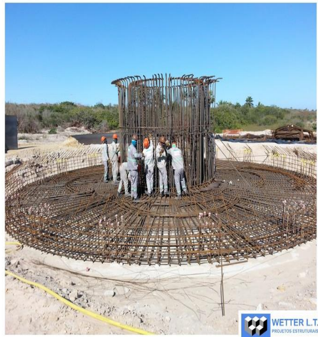
Figura 19.1 – Armação da estruturada base.
