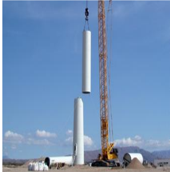
Figura 18 – Montagem de uma torre tubular
