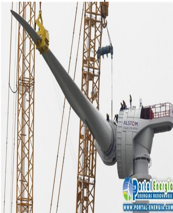
Foto 7 e 8 Colocando as pás
