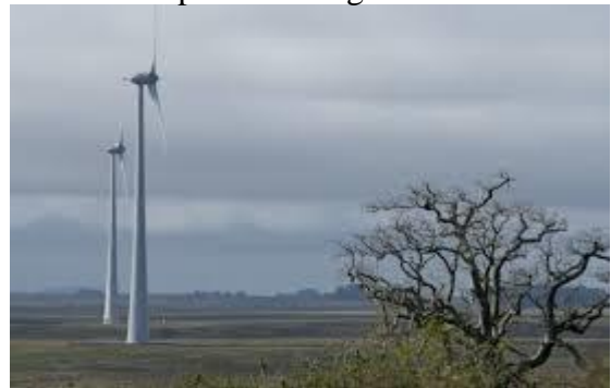
19.5 Torre após a montagem
