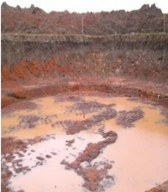
Figura 19 – Escavação para construção da base de um aerogerador.
