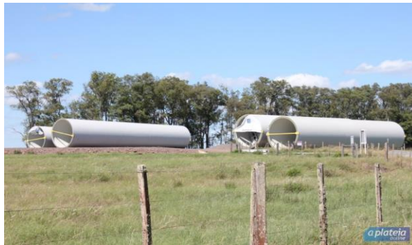
19.4 Torre tubular a ser montada na base
