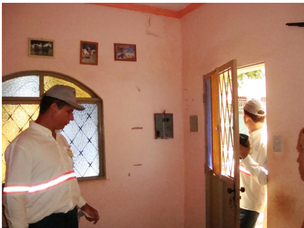
Figura 5: Exemplo de medidor localizado em local de não livre acesso Fonte: Cemig 5 - Rota de Leitura de Medidores (2011)
