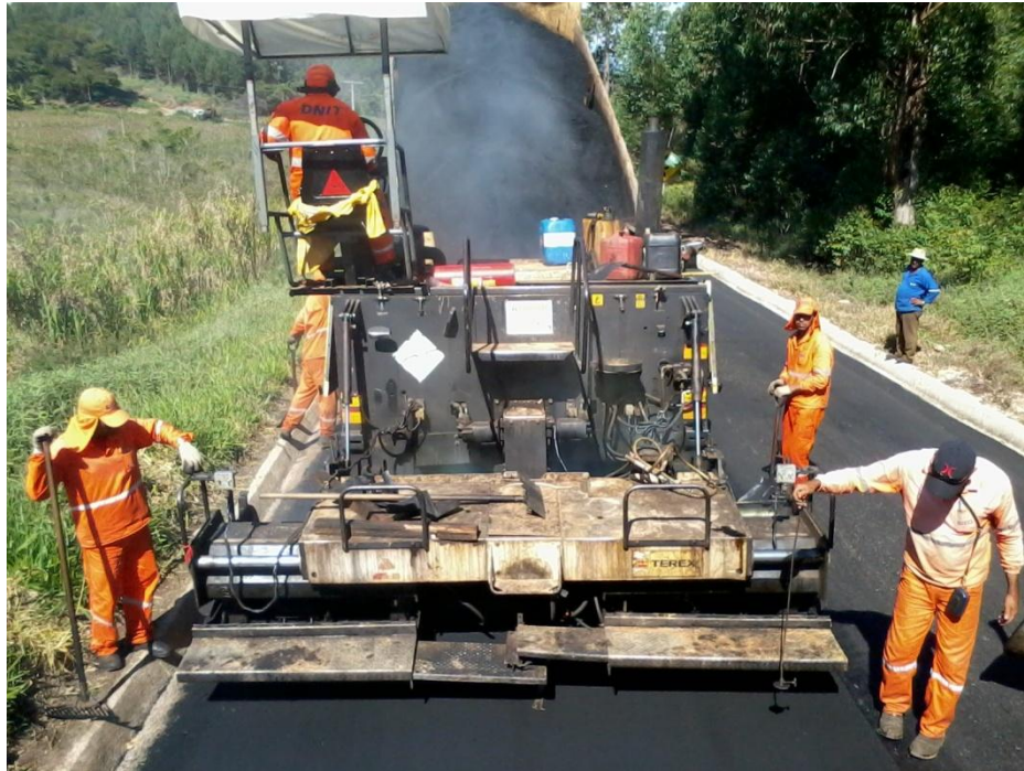
Figura 5. Pavimento flexível. Fonte: BRAYAN RODRIGUES (2014).
