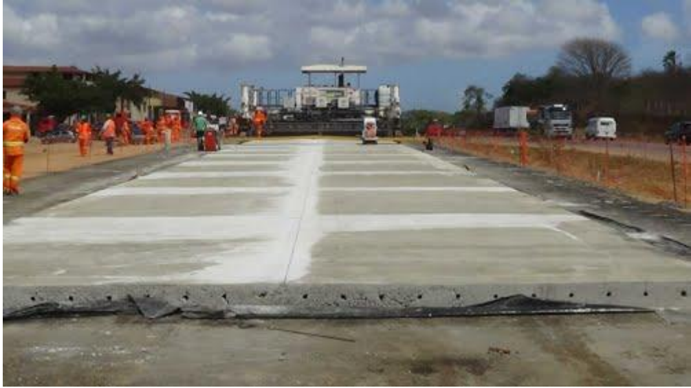
Figura 8. Pavimento rígido. Fonte: ( www.panoramio.com/user/61971 )
