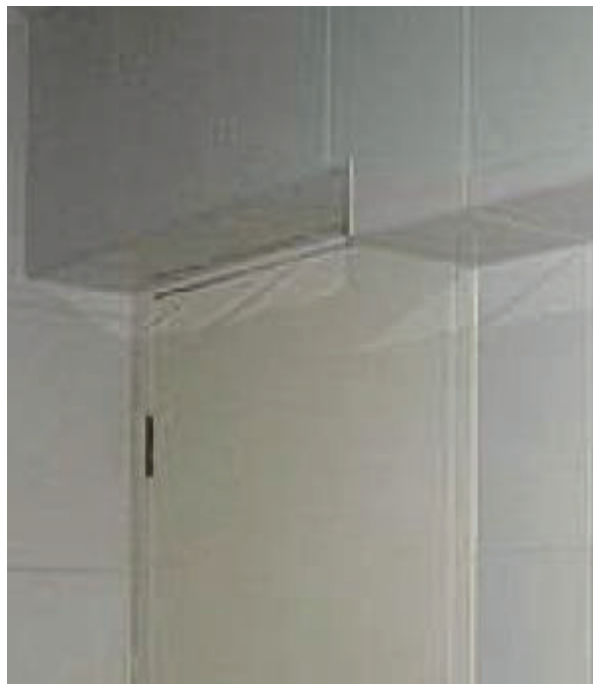
Figura 10 - Verificação da altura de portas e janelas antes de projetar a viga
