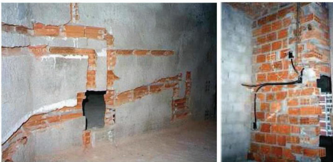
Figura 08 - Retrabalho por falta de compatibilização
