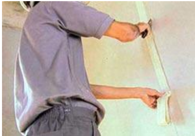
Figura 1 – Drywall na fase de acabamento.
