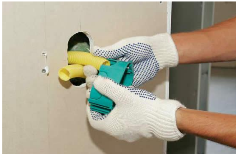
Figura 4: Ilustração da Instalação Elétrica do Drywall
