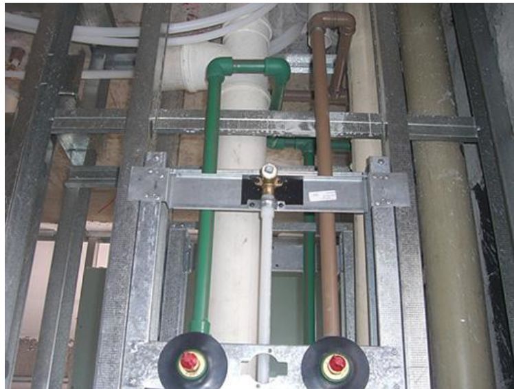
Figura 5: Ilustração da Instalação Hidráulica do Drywall
