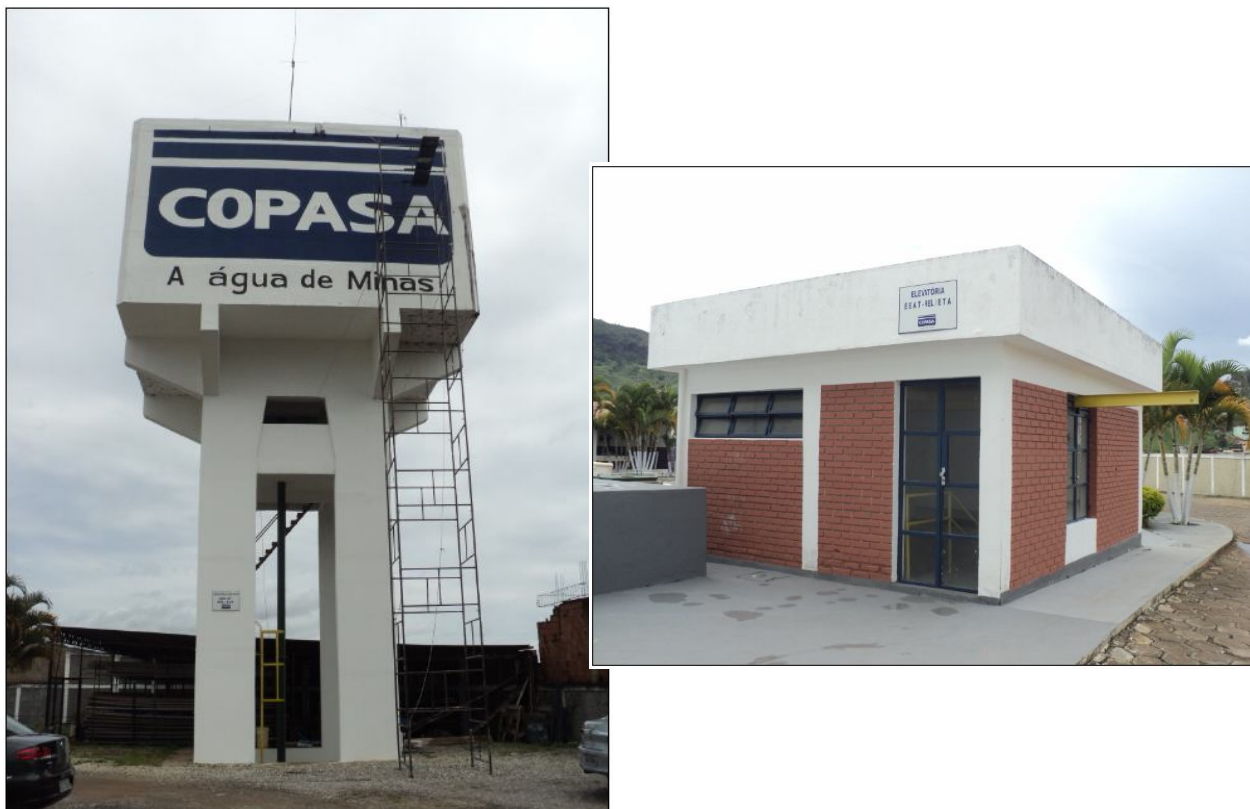
Figura 3.6 – (a) Reservatório Elevado R-03 / (b) Estação Elevatória EEAT-16
